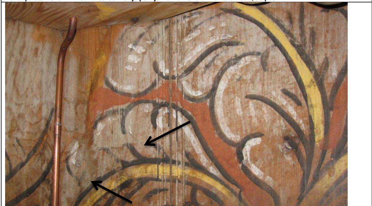
Sydvegg under prekestol. Piler markerer mulige hjelpelinjer.
