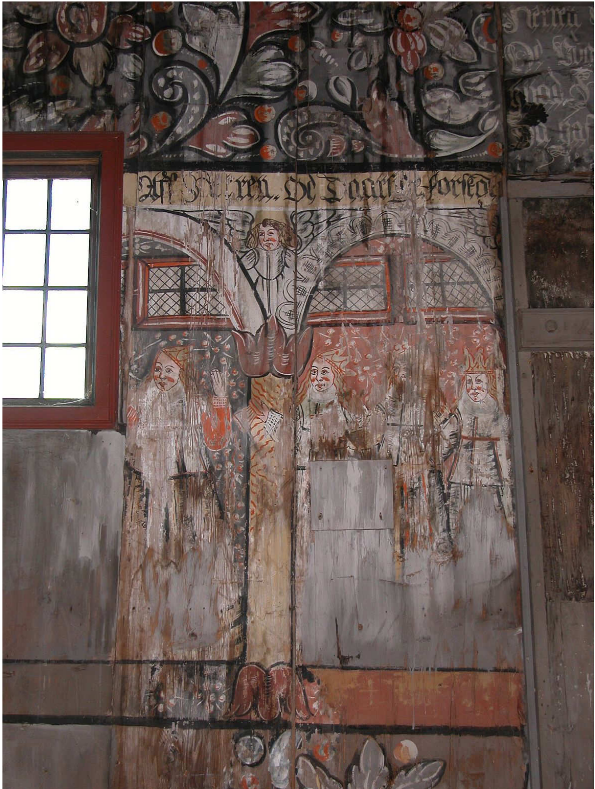
Figur 2. Limfargedekor på den vestlige delen av sørveggen. Motivet er hentet fra liknelsen om de kloke og de dårlige jomfruene. På rankedekoren øverst på veggens ses mørke skjolder etter fuktpåvirkning. På nedre del er det store, retusjerte felter på forhugginger og innkabbinger som er dårlig fargemessig tilpasset den slitte dekoren. Foto: NIKU, KSo 2007.
