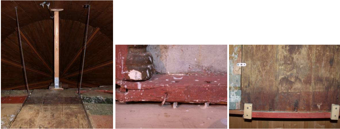
Figur 47. Altertavlen i Hedalen stavkirke. Demonsteringen 2005: Til v. :altertavlens bakvegg var festet til korveggen med to jernstenger og en treplanke (bildet er tatt fra gulvet opp mot taket). Samme metode ble brukt ved remonsteringen 2007. I midten: To spikre var slått gjennom nedre list på sidefløyen mot syd og ned i alteret. Disse ble saget over. Til h.: Ved remonstering ble støtteklosser skrudd til alterbord og bakvegg. Samtidig ble hengslingen mellom bakvegg og fløyer forsterket med ekstra hengsler. Foto Merete Winness, NIKU, 2005, 2007
