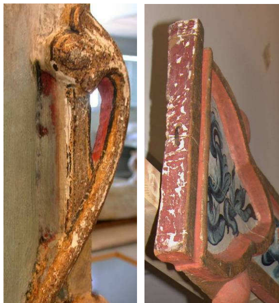
Figur 24. Korset, detalj fra korsstammen. Rankene var opprinnelig imitasjonsforgylte, med røde kanter og sort konturering. Foto: Mille Stein, NIKU 2007.
