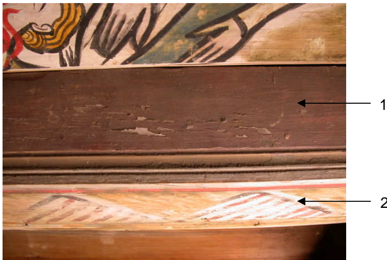
1. Monokrom, horisontal flate med mye støv og en del løs maling. 2. Hvelvbjelke med sik-sakmønster. Fra lektoriets sydside. Foto: NIKU, 2009
