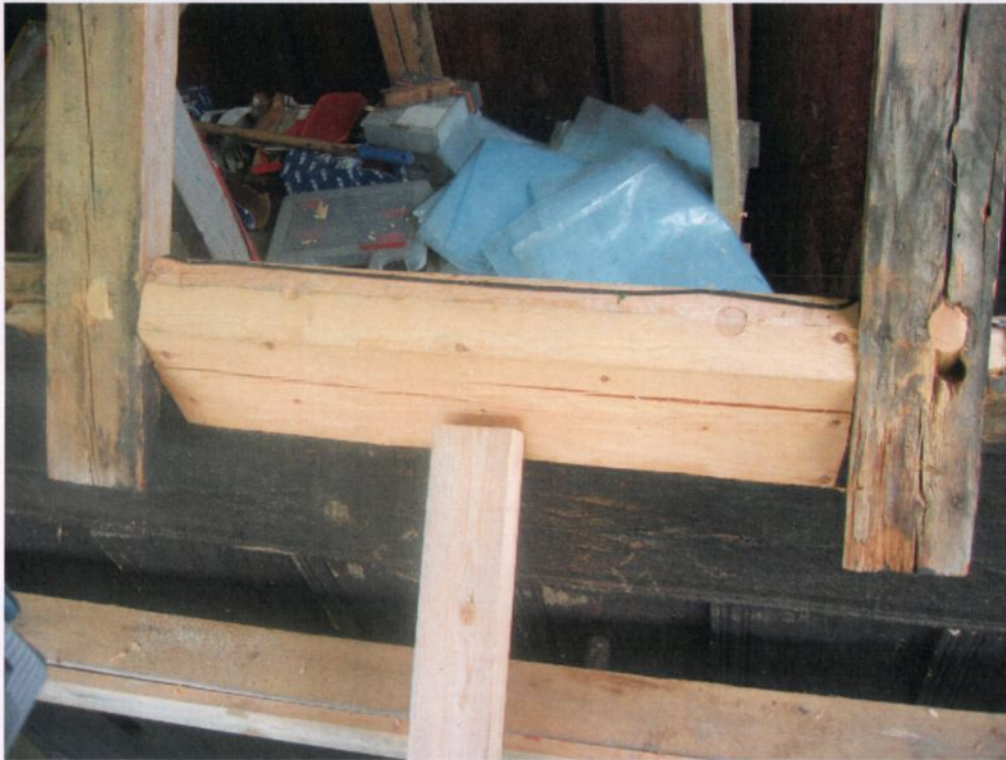
Utskiftet del av den øvre stavlegjen i svalgangen på nordsiden av skipet. Foto OS 08
