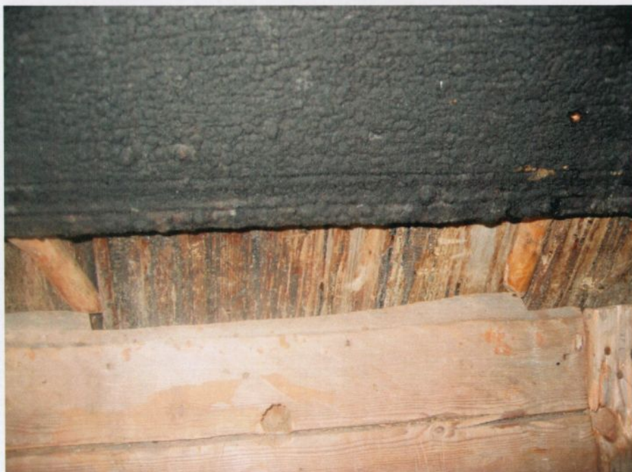
Parti av festebjelken med uttak for veggplanker. Rissene for uttakene kan så vidt skimtes. Foto OS 08
