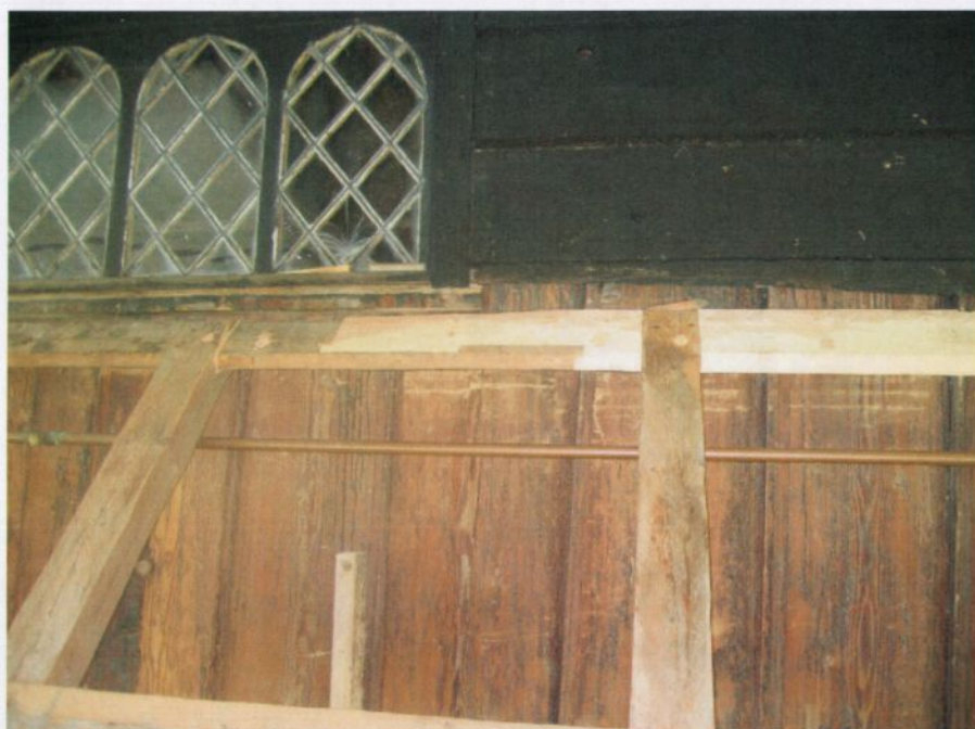
Forbindelsen mellom festebjelken og den utskiftete delen. Foto OS 08
