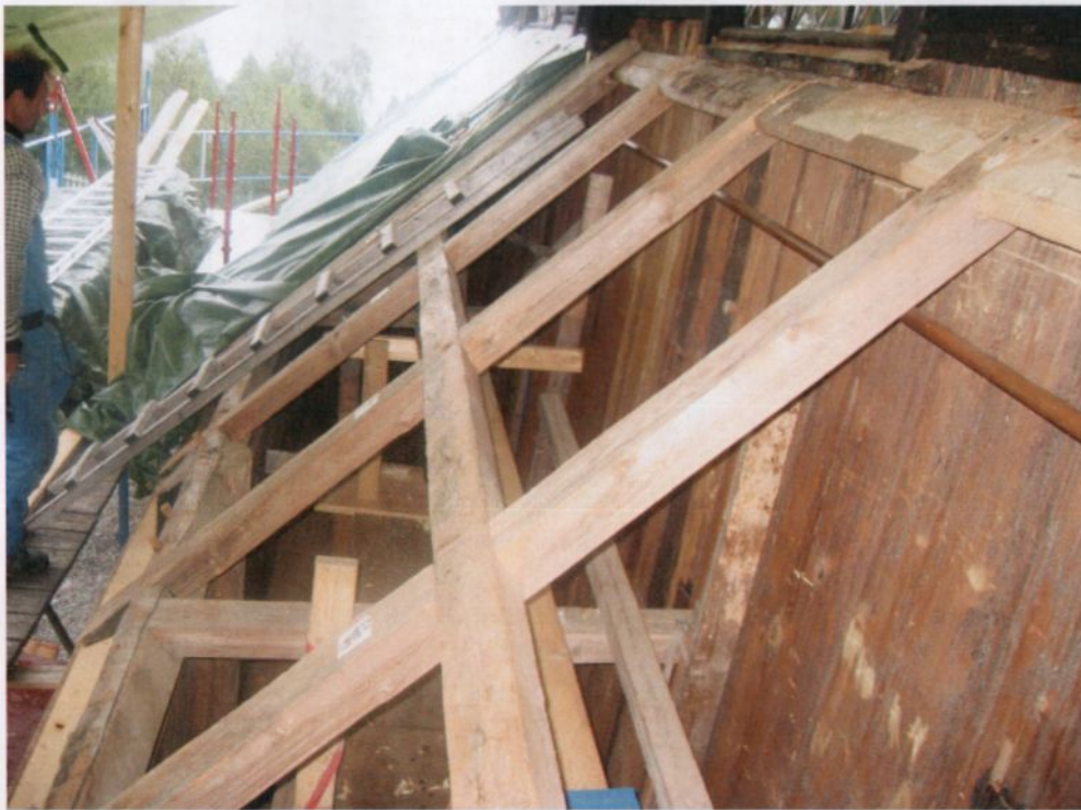
Svalgangen på nordsiden sett mot øst med sperrer og strebebjelker. Foto OS 08
