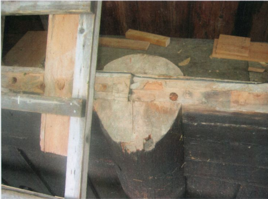
Stav med skjøt stavlegje i nordre svalgang. Foto OS 08
