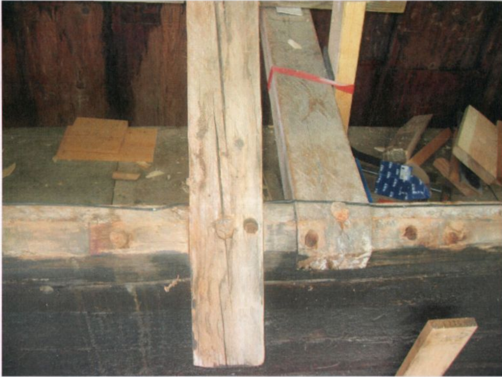
Stavlegjen i svalgangen på nordsiden med innfestet sperre og strebebjelke. Foto OS 08
