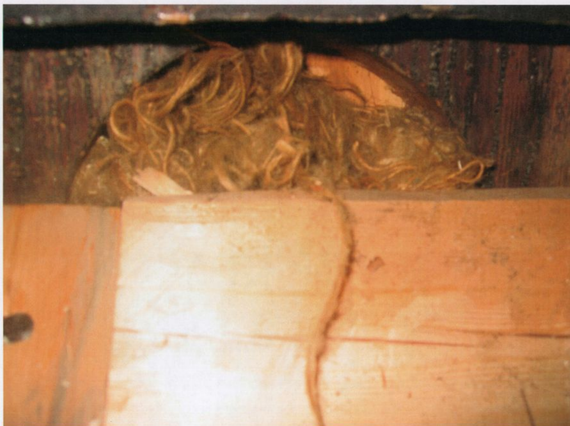
Vindusglugge som er dekket av festbejelken og fylt med hamp. Foto OS 08
