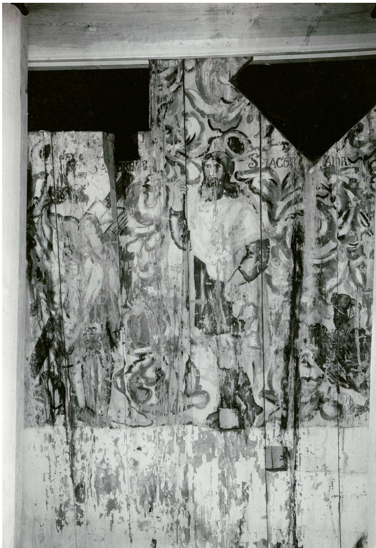
Fig. 11: Nordvegg i koret. Nebelungs panel, vindu og søyler samt innkubbing i tidligere vindusåpning er fjernet. Foto: Væring
