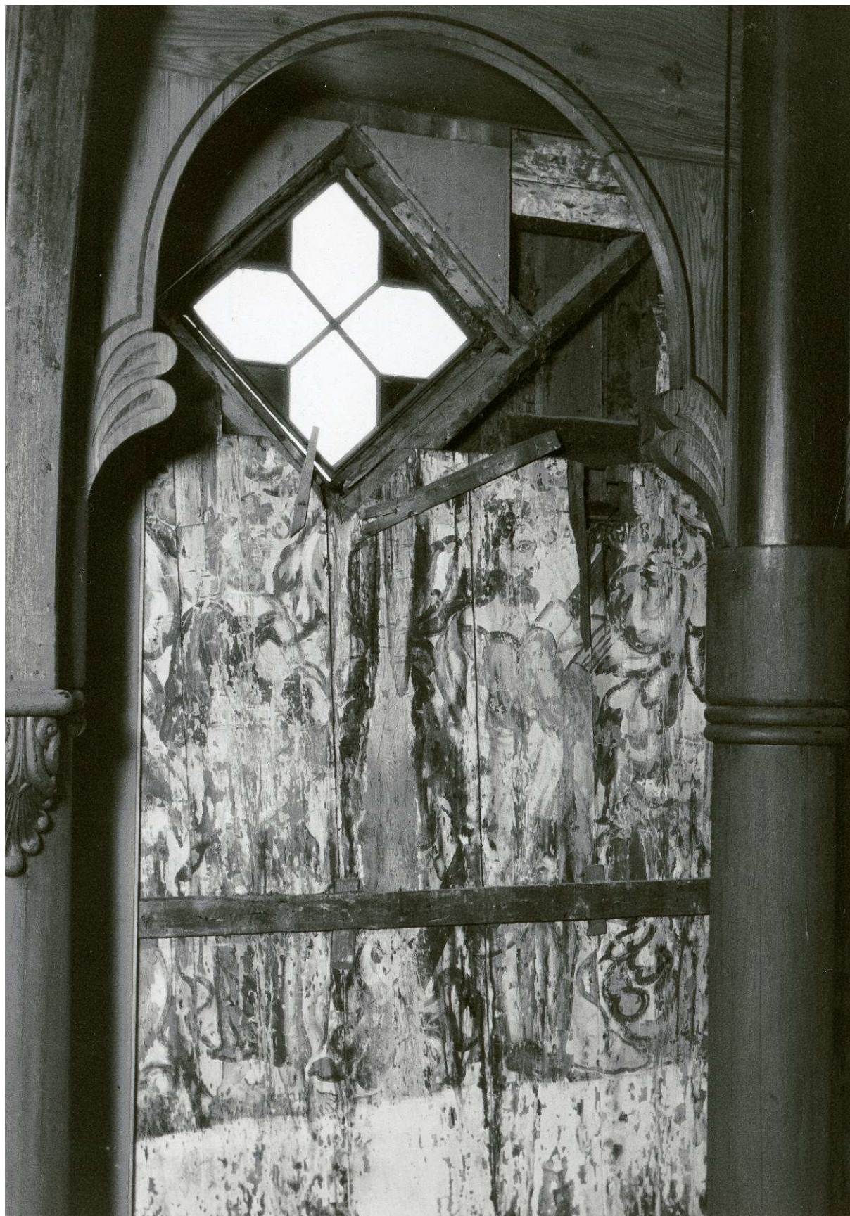
Fig. 10: Nordvegg i koret. Nebelungs panel er revet. Vindu og søyler er fremdeles på plass. Foto: Væring
