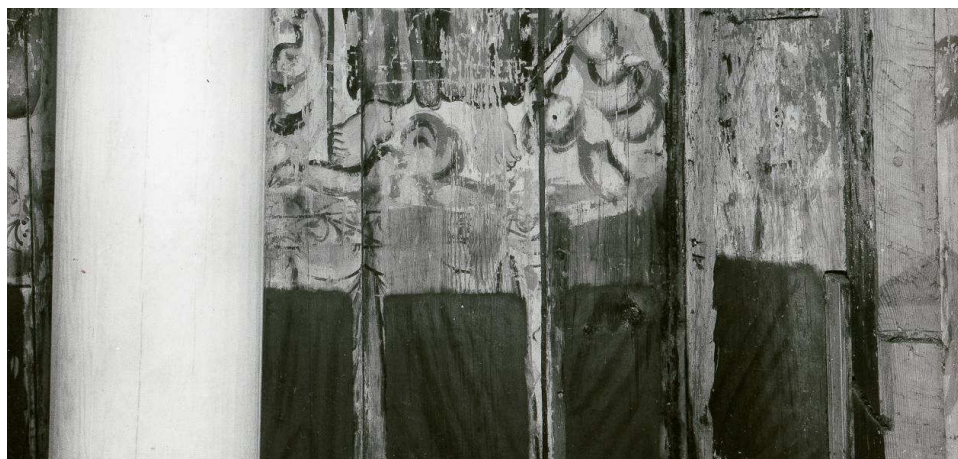
Fig. 6: Nedre del av korvegg som ikke var dekket av veggfast interiør hadde malt treimitasjon. Foto: Væring
