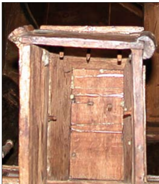
Figur 12a. Et av skipene i kirkemodellen i Hedalen, sett fra undersiden. Bildet viser at den er laget av eik og holdt sammen med tretapper. Foto: Mille Stein, NIKU, 2007.
