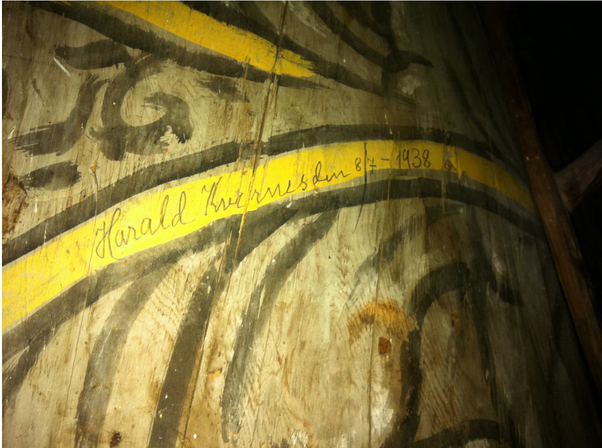
Figur 46. Den gule fargen i limfargedekoren i skipet er oppsiktsvekkende klar og sterk i fargen. Den må være eldre enn 1938.
