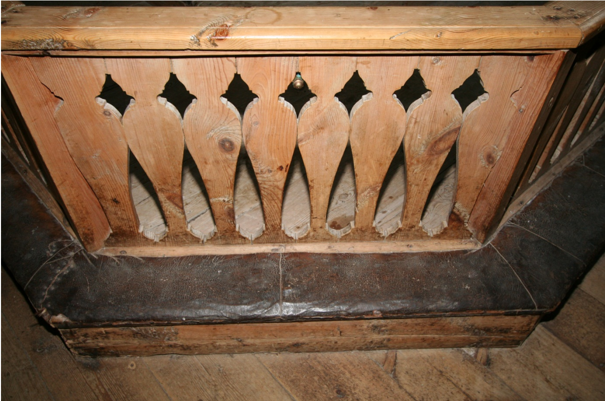
Figur 9. Skinnet på knefallet er i dårlig stand. Knefallet bør ikke brukes før det er reparert.
