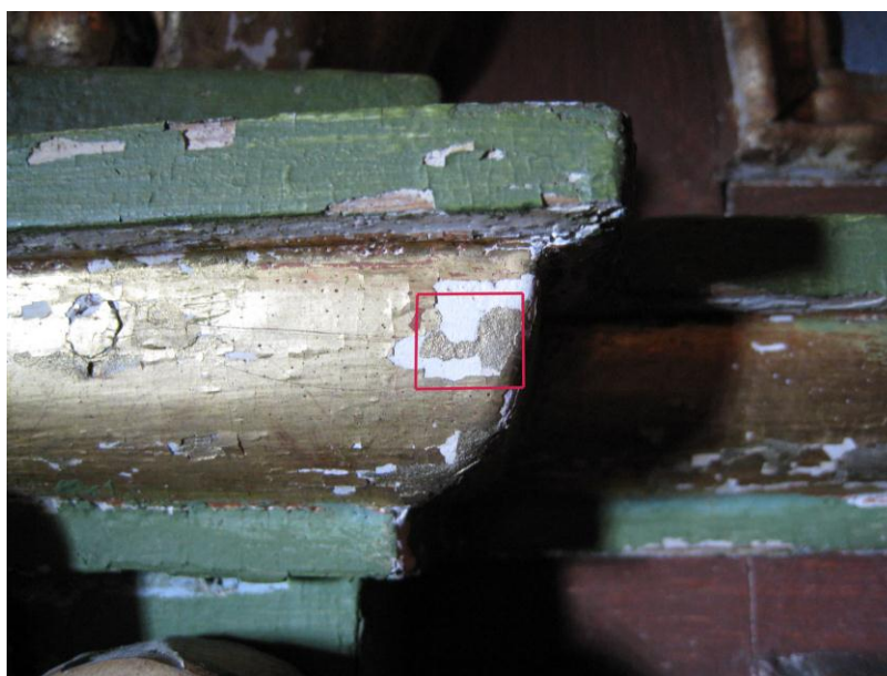
Figur 11. Rød avmerking viser retusj (sannsynligvis fra 1982) med hvite områder som viser avskallinger etter forrige konserveringsbehandling.
