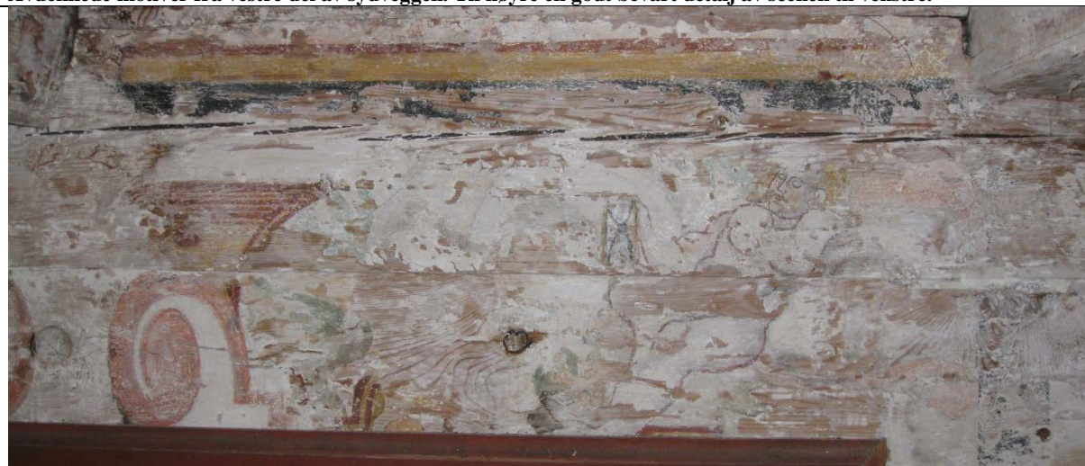
Felt over vestre vindu på sydveggen. Noen områder er meget godt bevart.
