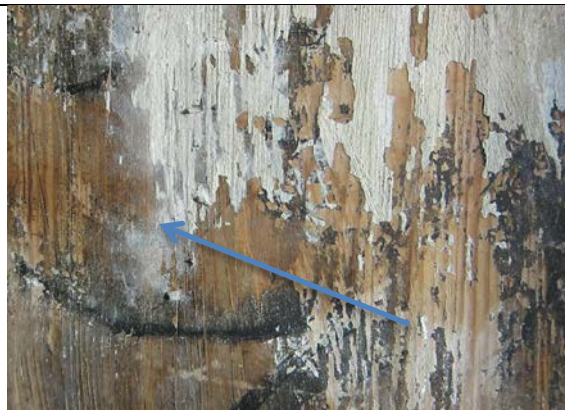
Detalj fra midtre del av dør, med papirrester fra tidligere konsolidering og avdekking på malingen.
