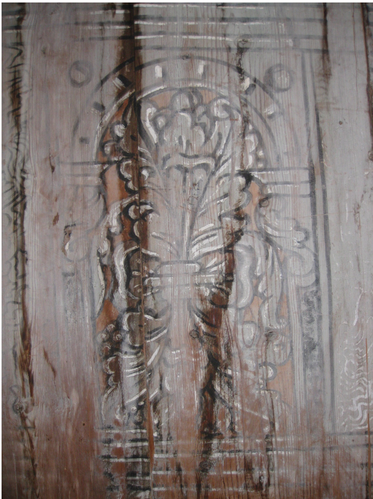
Fig. 4. Veggdekor i skip, skadet av fukt og vann som har medført vannskjolder og sløret maling.
