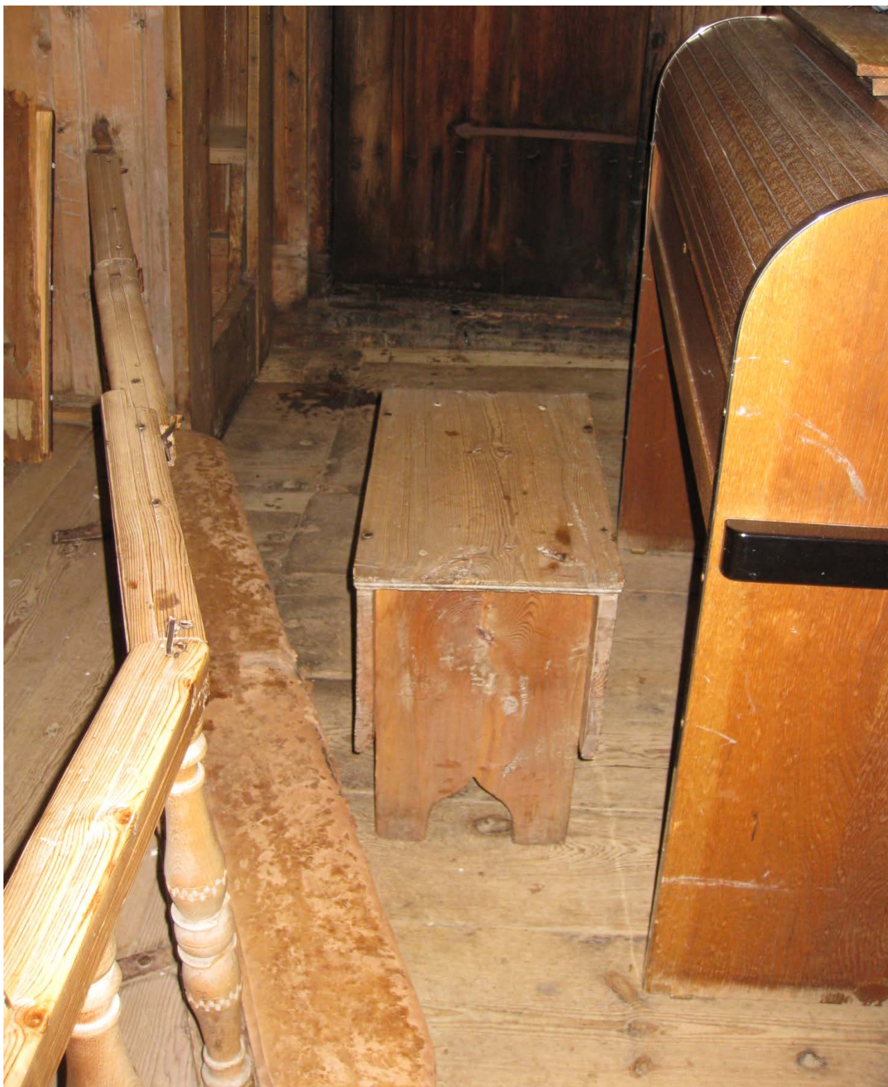
Fig. 12. Orgelkrakken står så nær skinnet på knefallet at det lett kan skades, og døren inn til alteret siger ned mot skinnet og belaster det.
