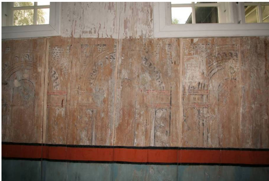
Fig.9 Arkaderekken/portalmotivet under vinduene på nordveggen etter avdekking og konsolidering. Foto: NIKU 2008.
