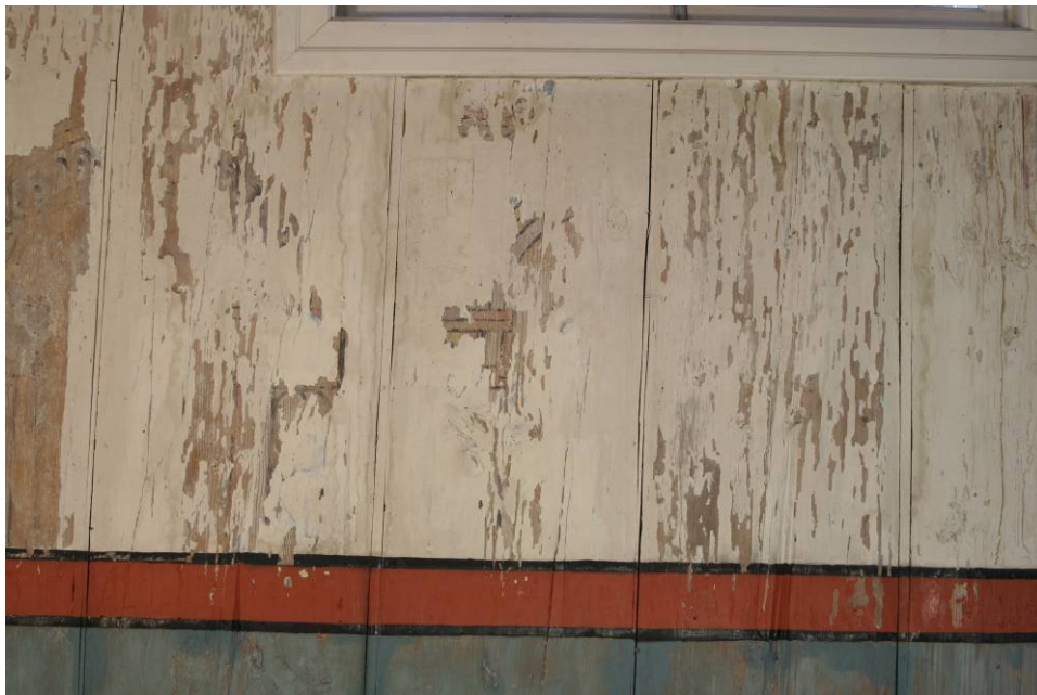
Fig. 2: Detalj av feltet under vinduene på nordveggen i vestre korsarm. Store områder med avskallinger og løs maling er fremtredende. Legg merke til 1600-tallsdekoren i de avskallede områdene. Foto: NIKU 2006.
