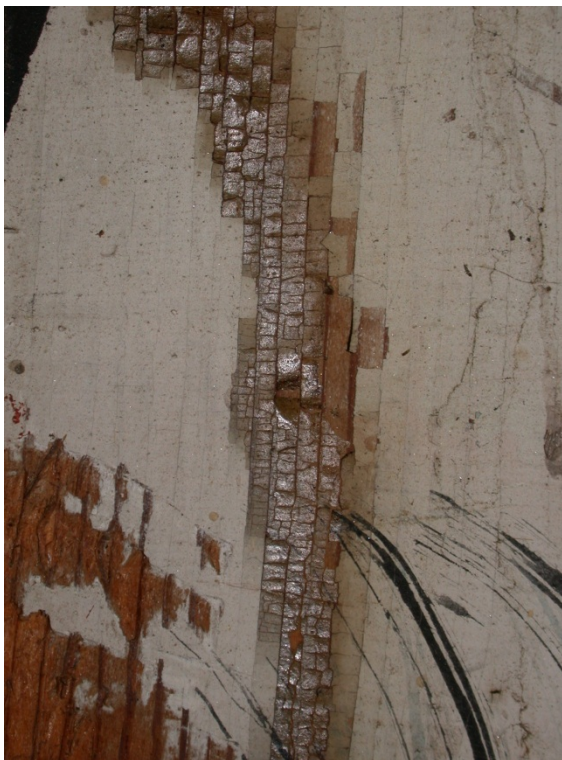
Fig. 26. Løs og oppskallet maling på veggdekor i skip. Foto: Merete Winness, NIKU, 2010. Fig. 27. Fuktskjolder på veggdekor, eldre enn 1950. Foto: Merete Winness, NIKU, 2010.
