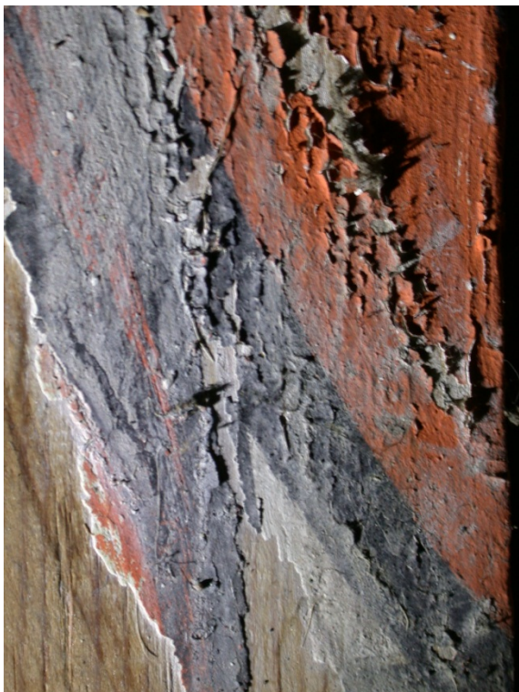
Fig. 26. Løs og oppskallet maling på veggdekor i skip. Foto: Merete Winness, NIKU, 2010. Fig. 27. Fuktskjolder på veggdekor, eldre enn 1950. Foto: Merete Winness, NIKU, 2010.
