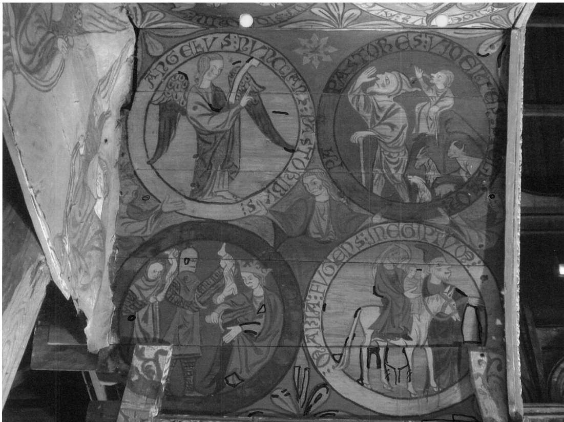
Fig. 8. Områder på sydveggen i ciboriets hvelv som er registrert med oppskallet maling, løs maling eller avskallet maling er merket med sort strek. NIKU 17.6.2010.
