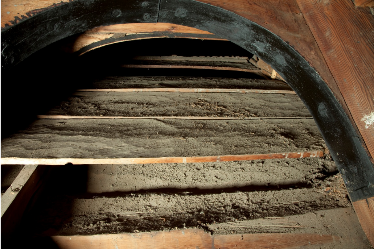
Fig. 17. Taket over ciboriet, nordsiden. To planker mangler, slik at ciborietaket er eksponert. Fuglerede til høyre på bildet. Foto: Birger Lindstad, 2011.
