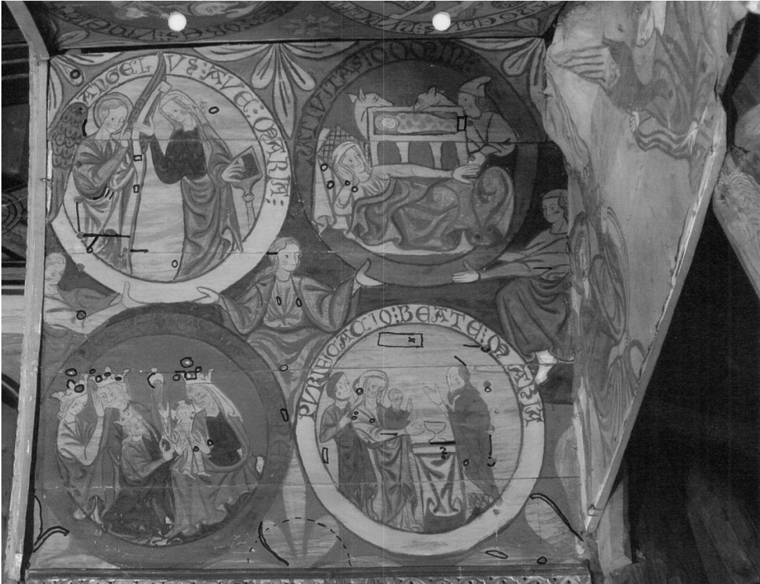
Fig. 9. Områder på nordveggen i ciboriets hvelv som er registrert med oppskallet maling, løs maling eller avskallet maling er merket med sort strek. NIKU, 17.6. 2010.
