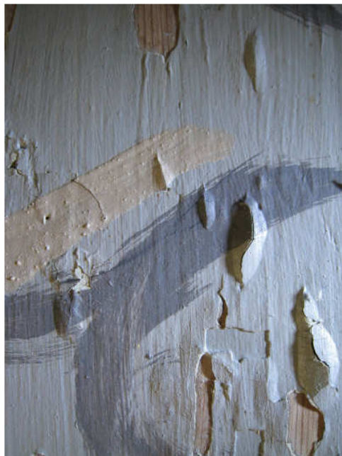
Figur 2. Oppskalling til høyre for altertavle.
