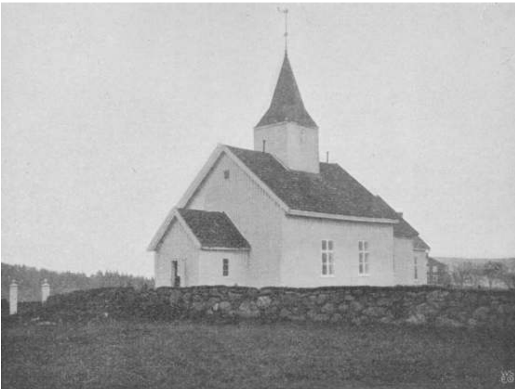
Høyjord stavkirke før restaureringen, F.Pettersen 1905
