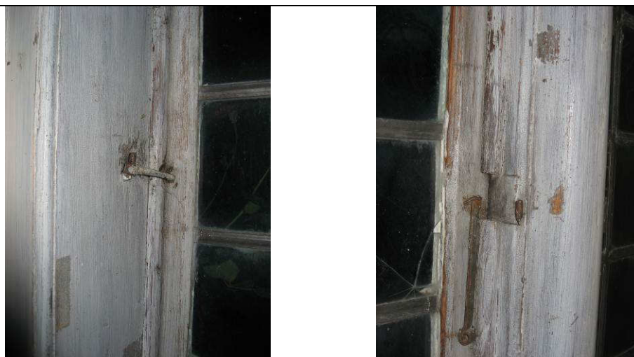
Bildene ovenfor er fra vinduet mot vest. Til venstre krok i sidekarm, til høyre krok på midtpost.
