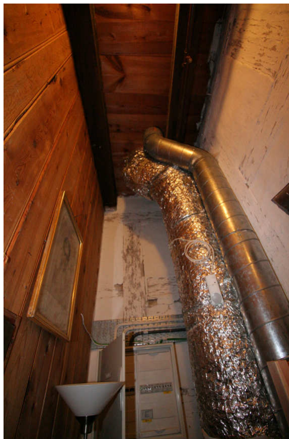
Figur 12. Baroniet Rosendal. Rom 204. Sett mot nord. Foto. JBr. 2009.
