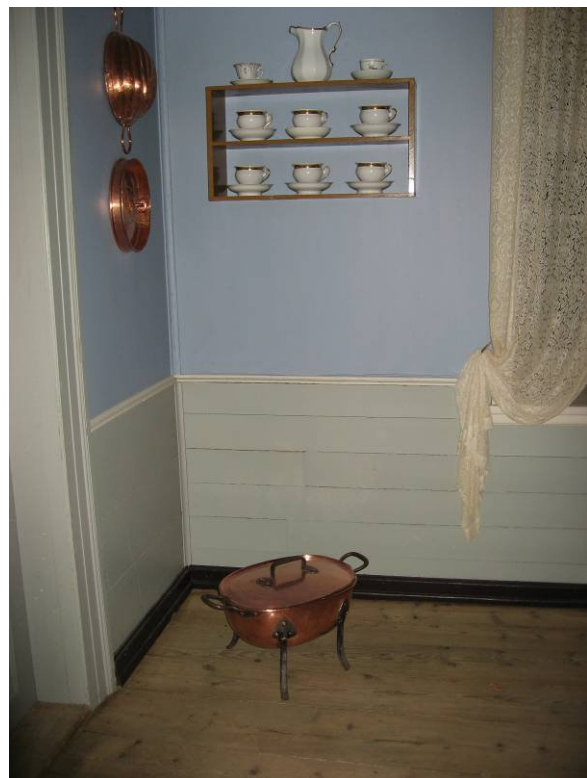
Fig. 7. Brystning, østvegg, 207 B. Panel fra 1902
