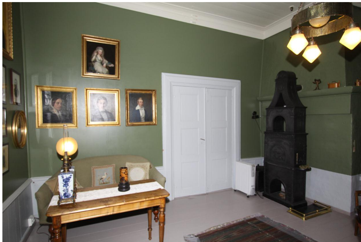
Grønnstuen sett mot nordøst. Dør og dørgerikter er nymalt med linoljemaling. Hele rommet er nå gjennomtørt. Ingen påviselige skader i veggtrekk og maling. Foto: JB. 26.10.11
