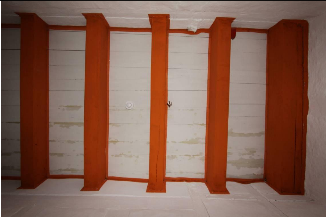
Takets norddel inn mot rom 220, Gulsalen. Over hele gangen er det kun et enkelt bordtak, som også fungerer som loftsgulv. Takbordene er malt med limfarge med kritt som pigment. Bjelkene er malt med limfarge med mønje og sinober som pigment. Gulvet på loftet ble kraftig nedfuktet, men på grunn av at gulvbordene var pløyd, og at gulvet trutnet raskt ble skadene i den vannløselige malingen begrenset til en rekke vannskjolder, misfarget og løs maling. Foto: JB. 3.1.2011
