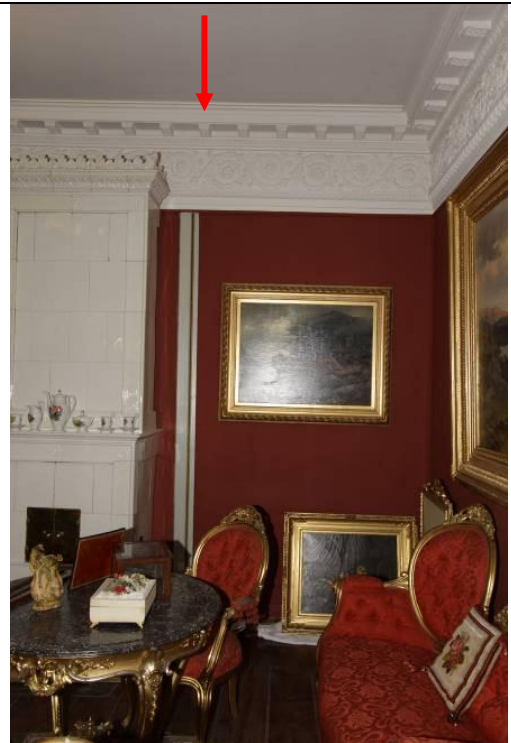
Det var nedfukning under gesimsen, langs brannmuren og på gulvet på begge sider av kakkelovnen. Rester av leire, sand og fint støv ligger igjen på gulvet etter at vannet er tørket bort. Området var fremdeles fuktig. Foto: JB. 3.1.2011
