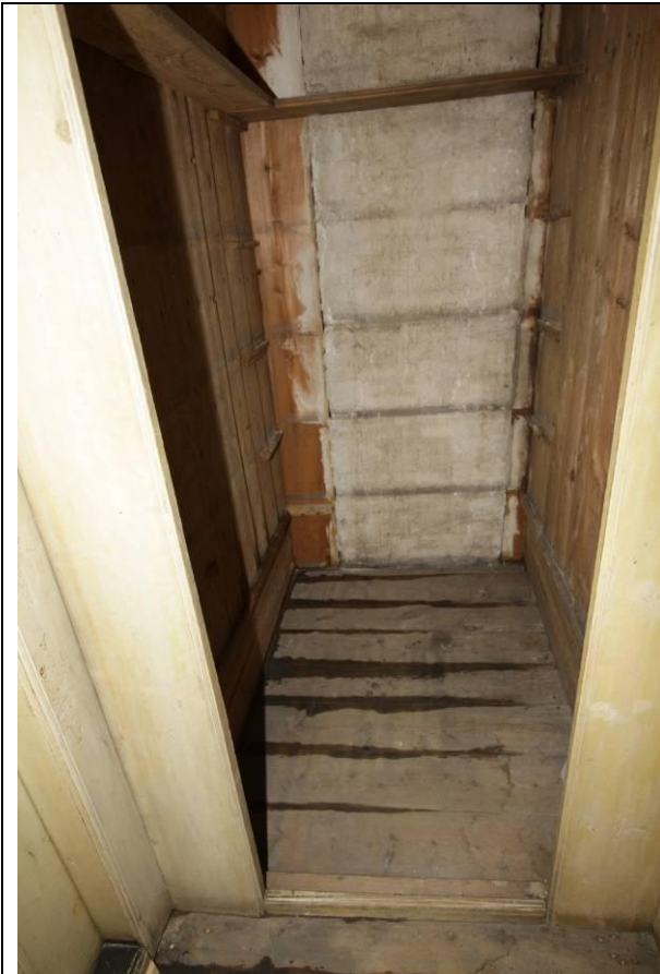
Sett mot øst. Rommet var fullstendig nedfuktet, med ca. 5 cm vann på gulvet. Tak, vegger, pipeløp og gulv var fremdeles vått. Loftstrommet over kottet var fremdeles meget vått. Foto: JB. 3.1.2011
