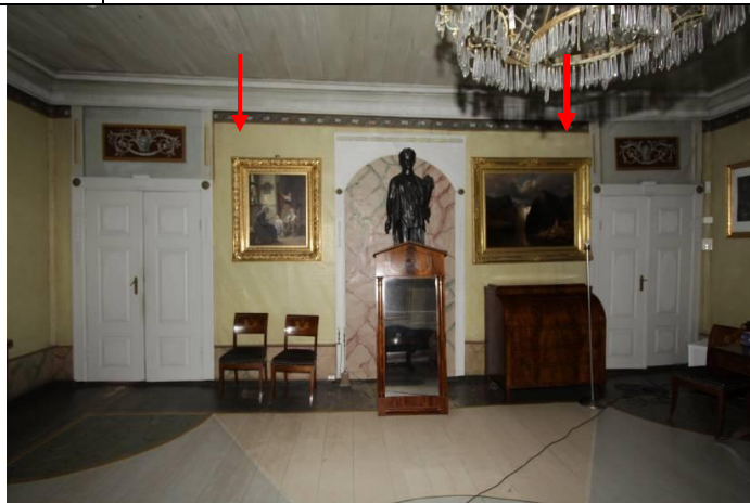
Sydveggen med trukne, malte vegger og malt dekor på undersiden av gesimsen. Det var fremdeles høy fuktighet i området mellom de to røde pilene. Hele rommet ble konservert og restaurert i årene 2002 – 2004. Det er skader i den retusjerte malingen på gesimsen der hvor nedfuktingen var størst, mellom pilene. Videre er det stor sannsynlighet for at det kan bli senskader i den malte dekoren på undersiden av gesimsen. Marmoreringen på brannmuren ble utført som en kopi av den opprinnelige i 2002-2004. Brannmuren var også nedfuktet, men det er usikkert om den har fått skader. Sydveggen må holdes under oppsyn for å kontrollere om det oppstår opp- og avskallinger i malinglag eller malt dekor. Foto: JB. 3.1.2011
