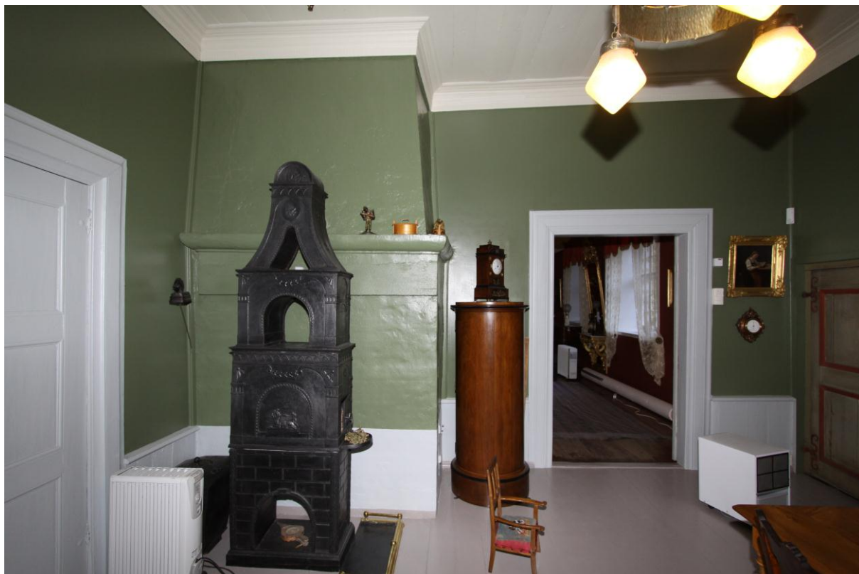
Grønnstuen sett mot øst. Dør og dørgerikter mot nord til venstre, er nymalt med linoljemaling. Hele rommet er nå gjennomtørt. Ingen påviselige skader i veggtrekk og maling. Foto: JB. 26.10.11
