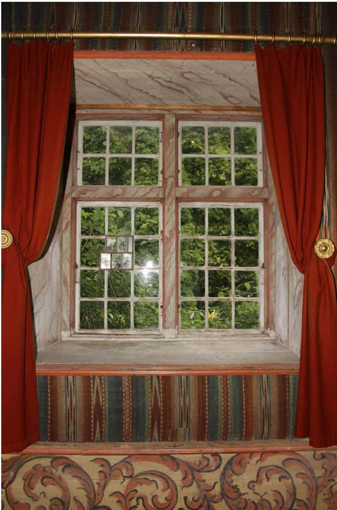
Figur 16. Vinduskarmer, vindussmyg og vindusgerikter er opprinnelige. Vindusrammene er skiftet, trolig i 1770- årene. Karmer, smyg og gerikter har marmorering utført i oljebasert maling. Trolig er denne samtidig med marmoreringen på dører og dørgerikter, ca. 1680- 1700. Maling og dekor er svært nedbrutt, avslitt og delvis overmalt.
