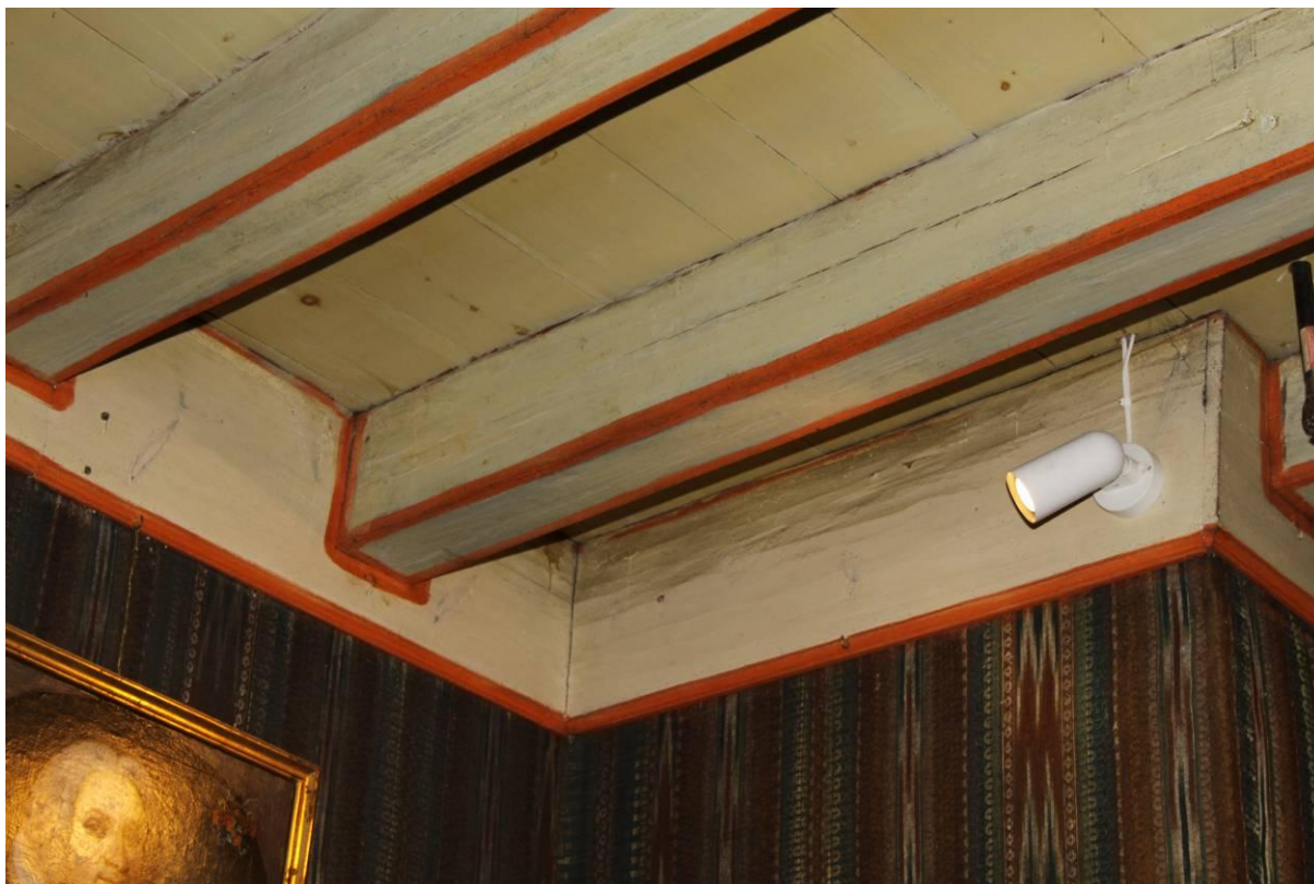
Figur 5. Detalj av taket i sydvestre hjørne.
