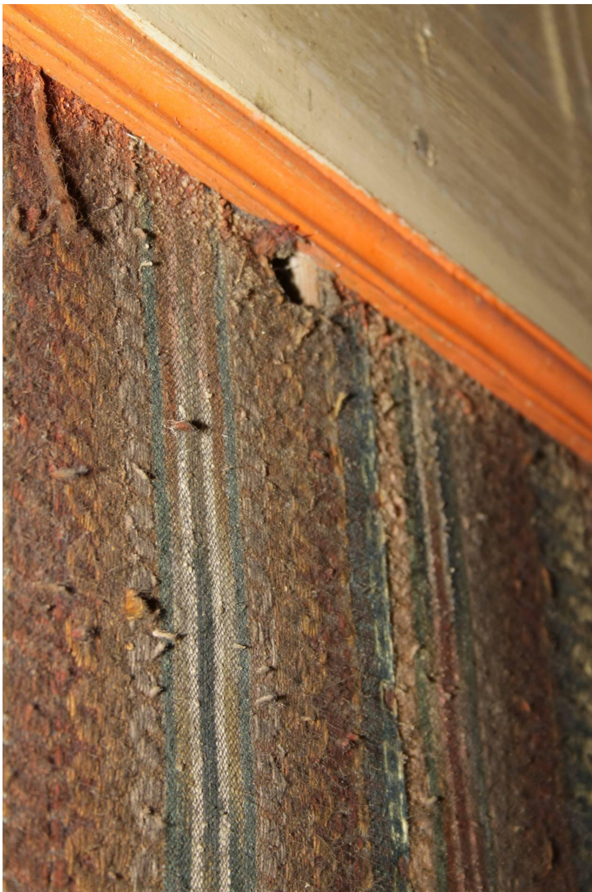
Figur 10. Detalj av tapetet undertaklisten. Mekaniske skader, tråder i renning og innslag er røket og overflaten er meget skitten.
