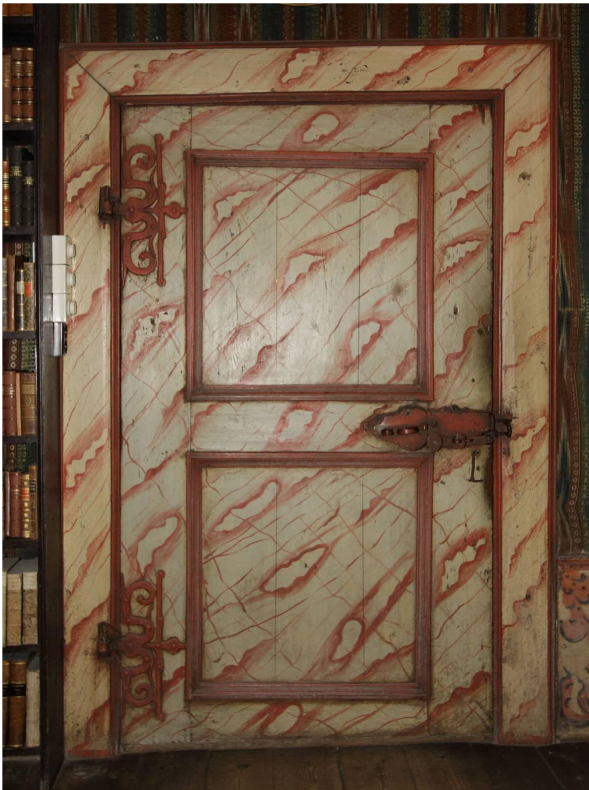
Figur 13. Dør 206/201. Begge dørene i rommet med hengsler og beslag er opprinnelige fra 1665. Dørene er malt og dekorert med oljebasert maling i en fantasimarmor. Maling og dekor kan være noe senere enn den øvrige innredningen i rommet. Trolig er dekoren malt i perioden 1680 – 1700. Dekoren er skitten og har skader etter overmaling som tidligere er fjernet. Se fig 14 og fig. 15 for detaljer.
