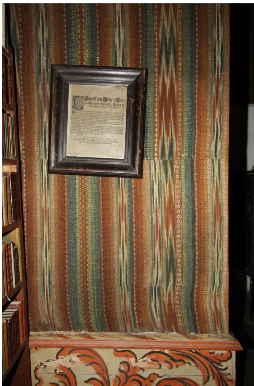
Figur 7. Tekstiltapetet. Detalj fra vestveggenes søndre del. De vevde banene er sydd sammen og ligger horisontalt i rommet, til dels i svært lange lengder.
