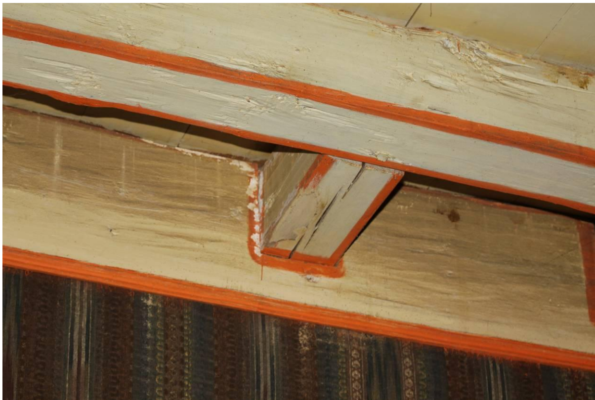
Figur 6. Detalj av takbjelker og stussbrett på østveggen.
