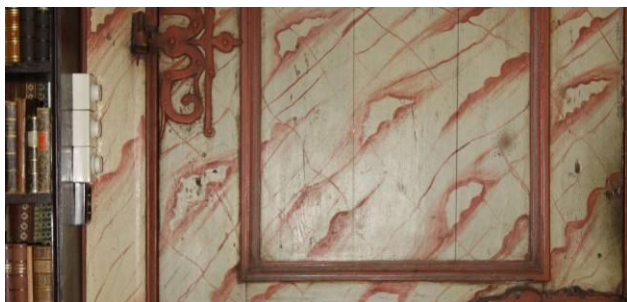
Figur 28. Lysbrytere for lampene i rommet. Alle lampene er koblet til dimmere. Installasjonen er festet til bokhyllen bak dør 206/201 og ikke til deler av den opprinnelige innredningen. Denne døra står alltid åpen, og bryterne er derfor ikke synlige.
