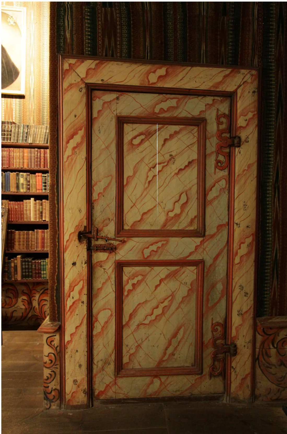
Figur 12. Dør 206/205. Begge dørene i rommet med hengsler og beslag er opprinnelige fra 1665. Dørene er malt og dekorert med oljebasert maling i en fantasimarmor. Maling og dekor kan være noe senere enn den øvrige innredningen i rommet. Trolig er dekoren malt i perioden 1680 – 1700. Dekoren er skitten og har skader etter overmaling som tidligere er fjernet. Se fig 14 og fig. 15 for detaljer.
