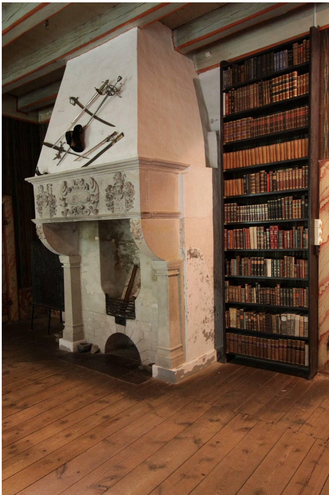
Figur 23. Opprinnelig kamin, datert 1665. Kaminen er utført i pusset tegl, og sandstein/kalkstein. Sidevangerens kapiteler og "arkitraven/gesimsen" over brennkammeret har hugne relieffer i brukbarokk. Brennkammeret er en senere ombygging, det har trolig opprinnelig vært helt åpent inn til \frac{3}{4} dybde av kaminen. Kaminen har flere reparasjoner, både i tegldelen og steindelen. Overflaten er meget skitten, og har diverse mekaniske skader.
