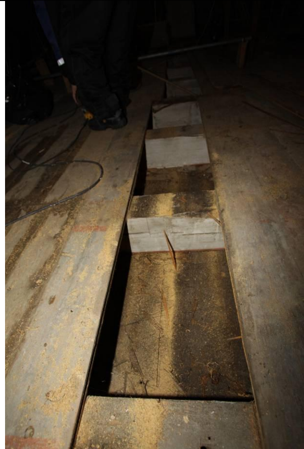
Loftsgulvet ble åpnet langs vestfløyens østvegg, for å gi gjennomlufting i bjelkelaget. Bortsett fra litt rusk og rask var det ikke stubbloftsfill over rom 217 Nystuen.
