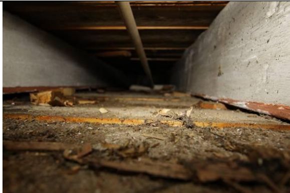
Foto tatt fra vest møt øst inne mellom bjelkelaget. På begge sider sees opprinnelig bjelkelag i rom 217 Nystuen, med hvit limfarge med mønjedekor på nedre sidekanter. De sekundære takbordene i rom 217 har et lite lag med rusk og rask på overflaten. Dette ble fjernet ved støvsuging, for å oppnå raskere og jevnere tørk.
