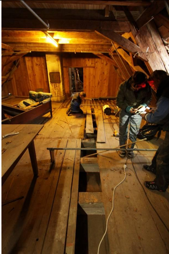
Loftsgulvet ble åpnet langs vestfløyens østvegg, over rom 217 Nystuen, for å gi gjennomlufting i bjelkelaget.
