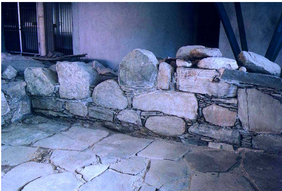
Den innvendige nordmuren av rom 18, Katarinahospitalets ruin i sentrum av Bergen (se også foto side 36). Det tidlige gotiske murverket bærer preg av mye pinning. Ved oppsett av budsjett må det tas hensyn den enkelte ruins størrelse, karakter og skader. Foto: Alf Tore Hommedal
