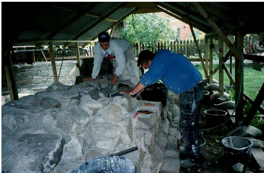
Reetablering av murkronen på søndre kormur, St. Nikolas kirkeruin i Sarpsborg. Kronen utformes som en avbrutt kistemur uten tekking. Murere: Kai Hasle (t.v.) og Jonny Skarpnor. Foto: Anne-Sophie Hygen
