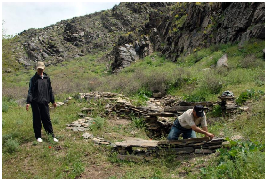
Работа над реконструкцией древней водяной мельницы (маршрут 2, пункт 7).
