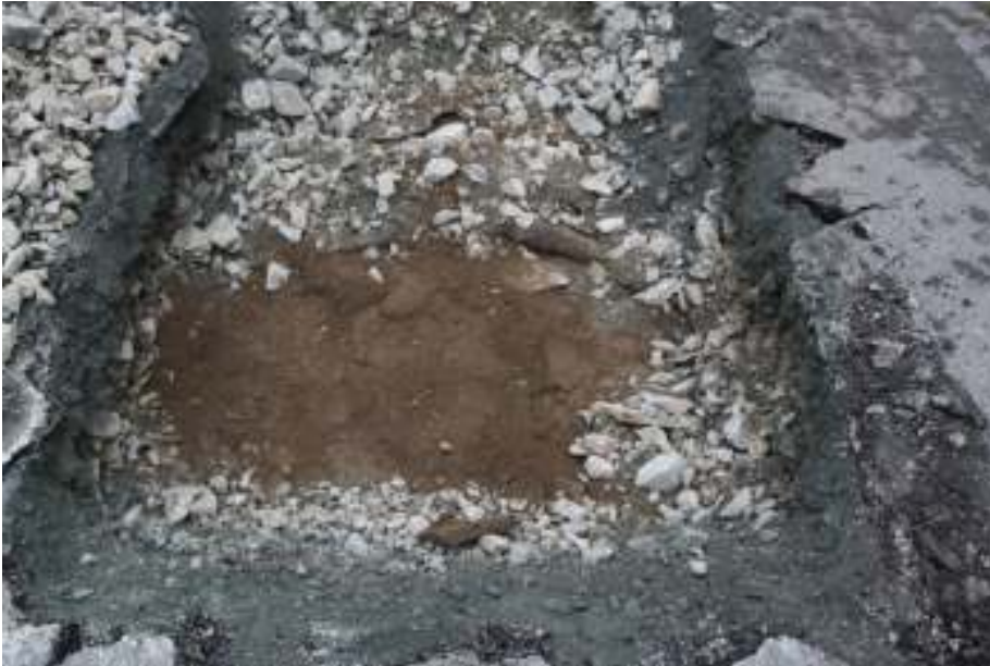
Fig. 28. Nytt bærelag for gatedekket kan ha fjernet kulturlagene i flere av de undersøkte grøftene, som her utenfor Holbergs gate 38A.
