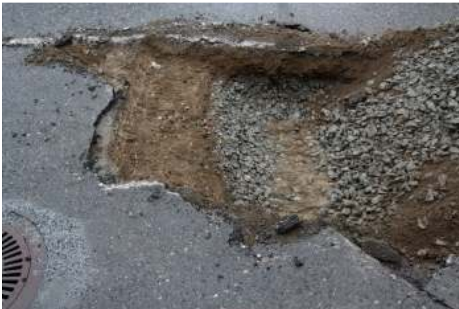
Fig. 38. Nytt bærelag for gatedekket kan ha fjernet kulturlagene i flere av grøftene, som her utenfor Jernbanegata 33.
