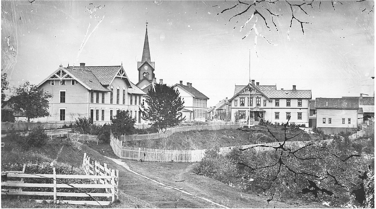
Fig. 11. Innfarten til Levanger fra sør på 1880-tallet. Bygningen bak flaggstanga huset da Levanger og Skogn Sparebank. Det store bygget til venstre er den gamle Borger- eller Middelskolen. Den tidligere elveskråningen foran flaggstangen er muligens området der bygården Skeggia brekko lå på 1430-tallet.
