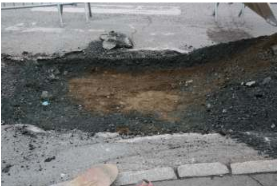
Fig. 32. Nytt bærelag for gatedekket kan ha fjernet kulturlagene i flere av de undersøkte grøftene, som her i/inntil krysset Jernbanegata/Brugata.
