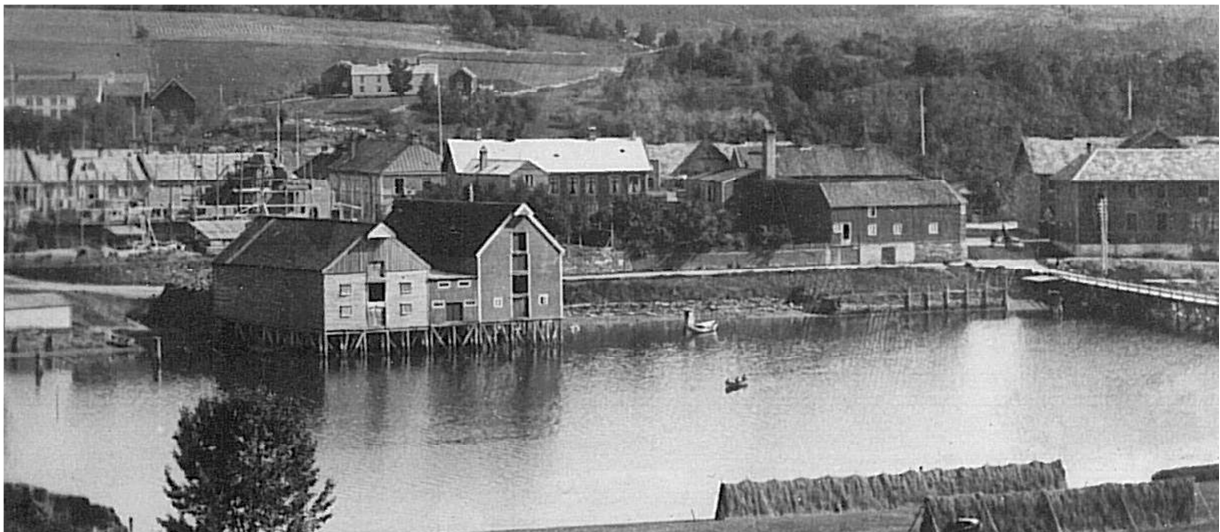
Fig. 15. Sundet 1901. Midt på fotoet til venstre ses de pågående arbeidene for den nåværende kirken, til høyre for dette Apotekerkvartalet. Nåværende kirkegårdsmur mot Sundet er synlig på hver side av de to sjøbodene, samt den smale veien mellom muren og sjøbodene/sjøen. Til høyre den gamle brua over Sundet. Grøft 1 ble tatt opp rett ut for muren foran hagen med trær, trolig i eller i ytterkanten av skråningen ned mot sjøen.
