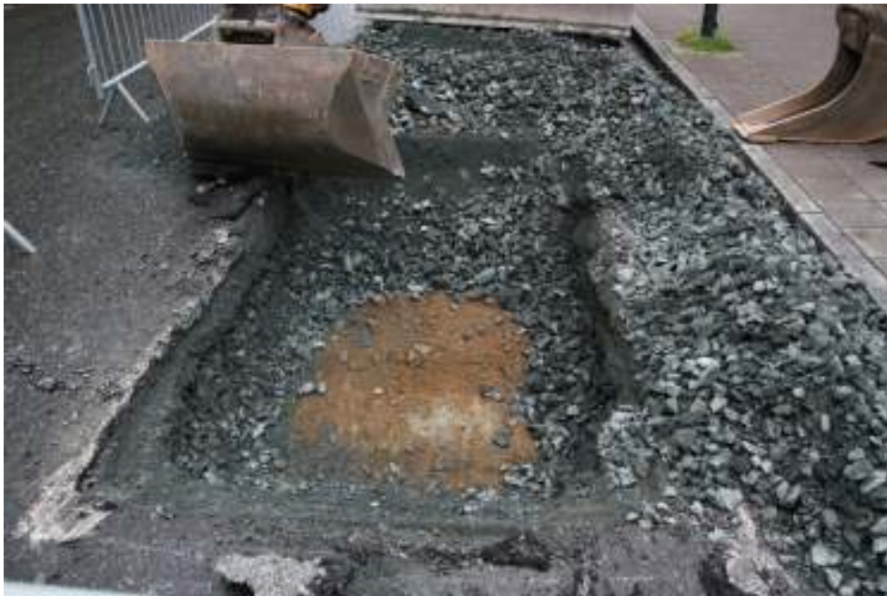
Fig. 27. Nytt bærelag for gatedekket kan ha fjernet kulturlagene i flere av de undersøkte grøftene, som her utenfor Kirkegata 50.
