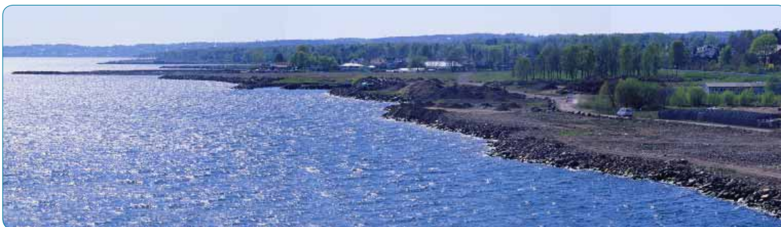
Fig 30: Lange kyststrekninger er påvirket av store utfyllinger i sjø. Hele kyststrekningen mellom Horten og Borre i Vestfold fremstår nå som en sammenhengende fyllingsfront etter at kystlinjen er fylt ut mellom 50-100 meter ut i fjorden. Foto: Dag Nævestad.
