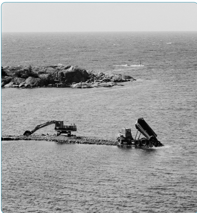
Fig 23: Gravemaskin og dumper etablerer ny småbåthavn i Korshavn, Lyngdal kommune. Foto: Dag Nævestad.
