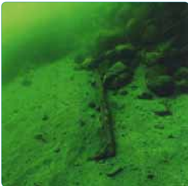
Fig 49: Kong Øysteins havn ved Agdenes. 10 år etter at havneanlegget ble oppmålt og dokumentert har alle de synlige restene av kaianlegget blitt erodert bort, mest sannsynlig som følge av strøm og bølgeerosjon. Foto: David Tuddenham 2002.
