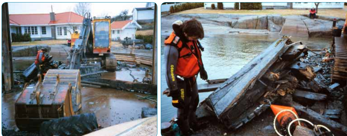
Fig 34 (til venstre): Fra bygging av sandstrand foran en villa i Vibeveien, Sandefjord, Vestfold 2001. Mudringen omfattet ca 1000 kubikkmeter masse og var godkjent av kommunen, uten høringsrunde. Museet fikk melding om arbeidene da entreprenør varslet om funn av "mulig skipsvrak". Foto: Pål Nymoen
