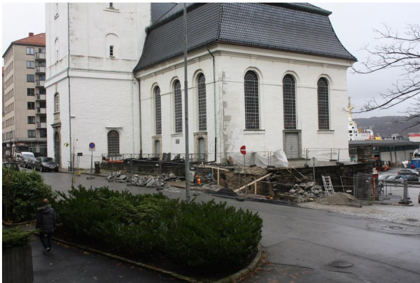
Fig. 4 Nykirken og Strandgaten sett mot nord. Bak sikringen sees murlivet like under plattformen til sørportalen.
