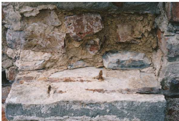
Fig. 8. Dørvang under demontering. Stein med gangjern avdekket. Jernnagler for feste.
