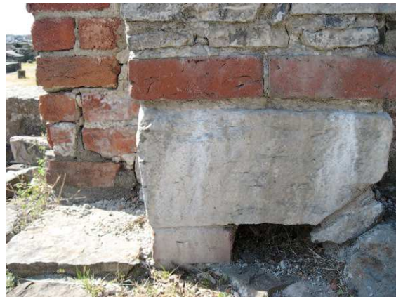
Fig. 5. Fundamentering av V dørvinge etter konservering
