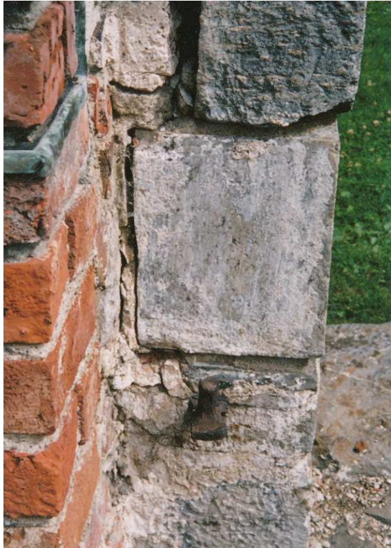
Fig. 6. Vestre dørvang før konservering, sett fra syd.
