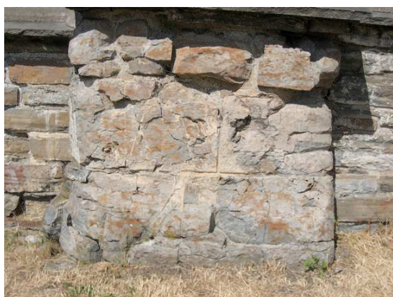
Fig. 1. Lisene i nordmuren etter fjerning av løse steiner.
