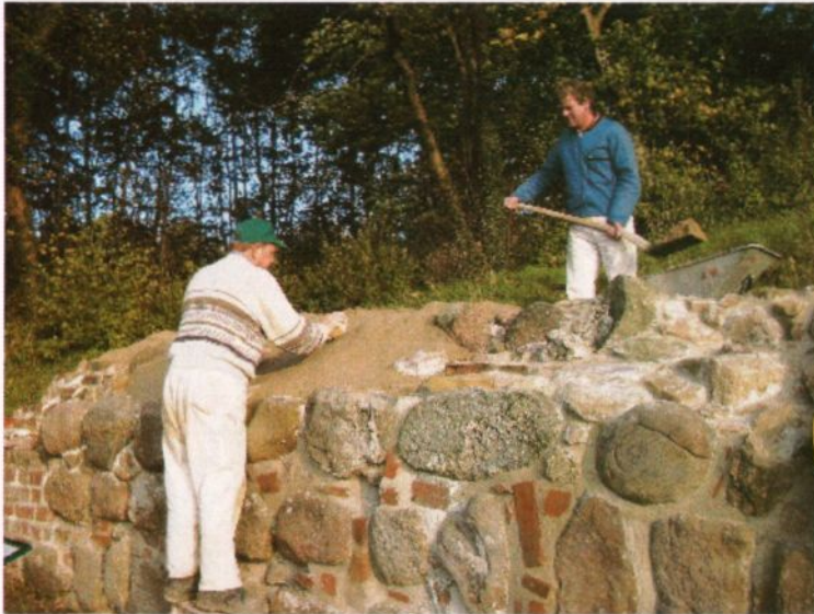
Bilde 1. Påføring av bentonitt-grus-blanding som toppdekke på murkroner.
