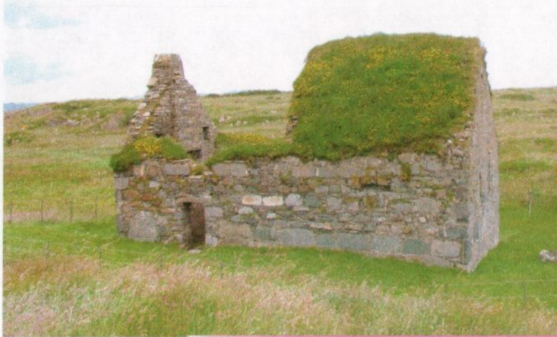
Bilde 5. Eilean Mor, Skottland. Toppdekke med leire og torv. Foto: Historic Scotland.
