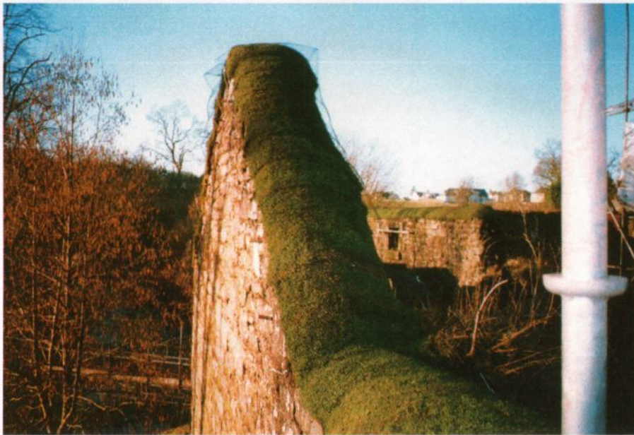
Bilde 7. Doune Mill, Skottland. Langs kantene på toppen skimtes nettingen, her av ikke-nedbrytbar type. Foto: Historic Scotland.
