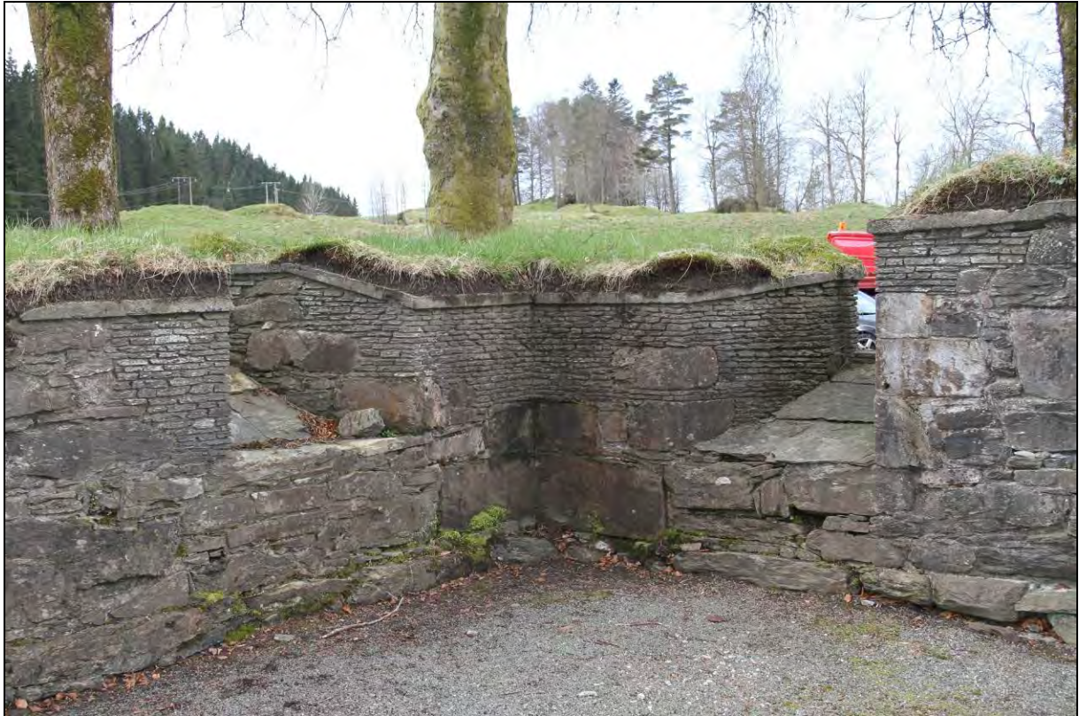
Figur 163. Murverket i innerlivet omkring vindusåpningene i sør-vestlig hjørne i dagrommet (foto: Byantikvaren 2011).
