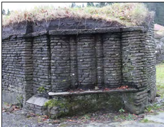
Figur 10. Bildet viser rekonstruerte profiler i vestportalen i kirken (foto: Byantikvaren 2010).
