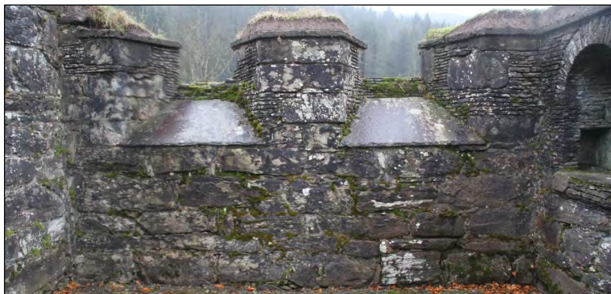
Figur 94: Østveggen i søndre kapell med opprinnelig murverk opp til vinduenes sålbenk. Vinduene er i sin helhet rekonstruert ved hjelp av opprinnelig stein i kombinasjon med småsteinsteknikk (foto: Byantikvaren 2012).
