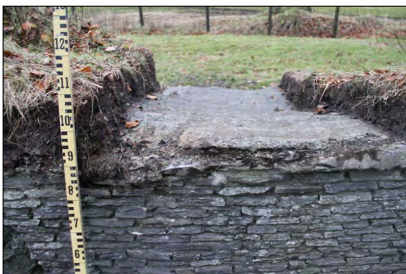
Figur 20. Oppløsningstendenser langs kanten av sementoverdekningen. Fra innerlivet midt på østmuren i dagrommet - Rom 7 (foto: Byantikvaren 2011).
