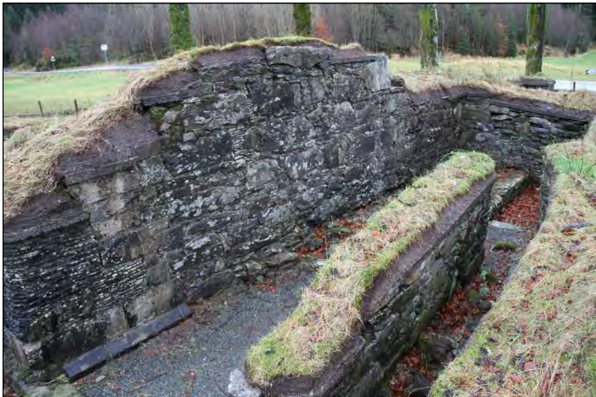
Figur 230: M8 er i dag et frittstående murstykke som trolig hatt en funksjon i forbindelse med en trapp i rommet. Den smale gangen til venstre har trolig ledet inn til en fengselscelle under trappen (foto: Byantikvaren 2012).
