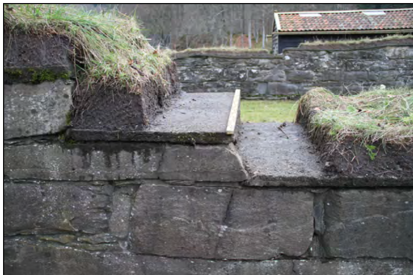
Figur 18. Avtrappinger i murkronen. Torvdekket på kronene ble beskåret slik at overgangen mellom toppdekning og murverk ble tilgjengelig for analyse. Bildet viser midtre del av ytre murliv i kirkens langmur mot sør (foto: Byantikvaren 2011).
