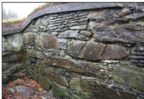
Figur 225: Vestsiden av M6 består av tilsynelatende intakt murverk, med enkelte partier i småsteinteknikk (foto: Byantikvaren 2012).
