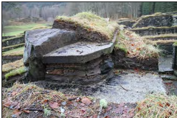
Figur 146. Langsgående avtrapping i murkronen på vestmuren. Foto mot N (foto: Byantikvaren 2011).
