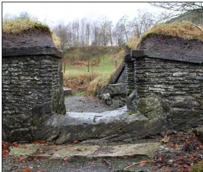
Figur 214: Portal lengst nord i M4 mellom rom 10 og 11 (foto: Byantikvaren 2012).
