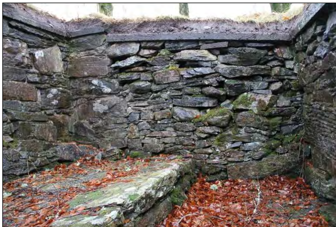
Figur 201: Innerlivet til sørsmuren i rom 8. Lengst til venstre i muren er det bevart opprinnelige murverk, mens resten er rekonstruert som tørrmur. Nivåforskjellen i gulvet har sammenheng med rominndeling(foto: Byantikvaren 2012).
