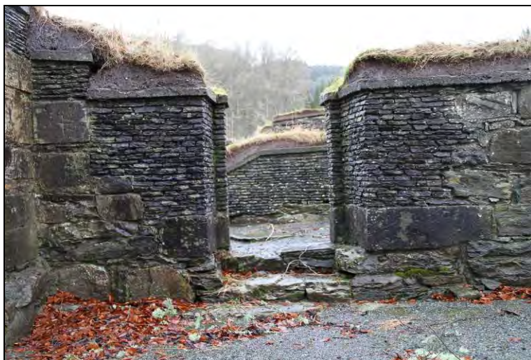
Figur 150. Portalen i dagrommet sett fra innsiden (foto: Byantikvaren 2012).
