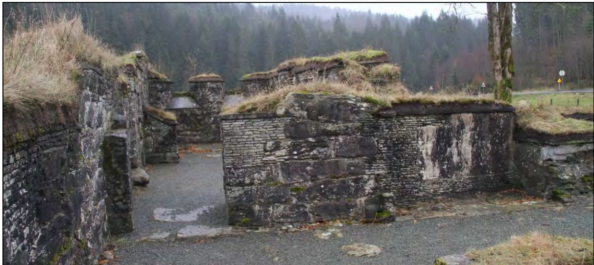
Figur 86: Vestmurens ytterliv består av opprinnelig murverk, rekonstruerte områder i småsteinsteknikk, portal og en stor nisje (foto: Byantikvaren 2011)
