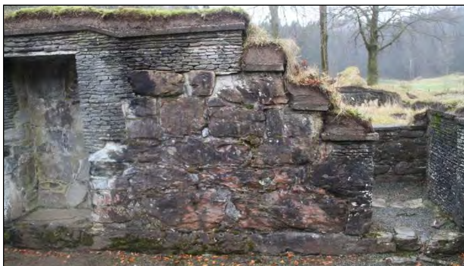
Figur 101: Parti med opprinnelig murverk mellom sittenisjen og døråpningen i sørveggen (foto: Byantikvaren 2012).
