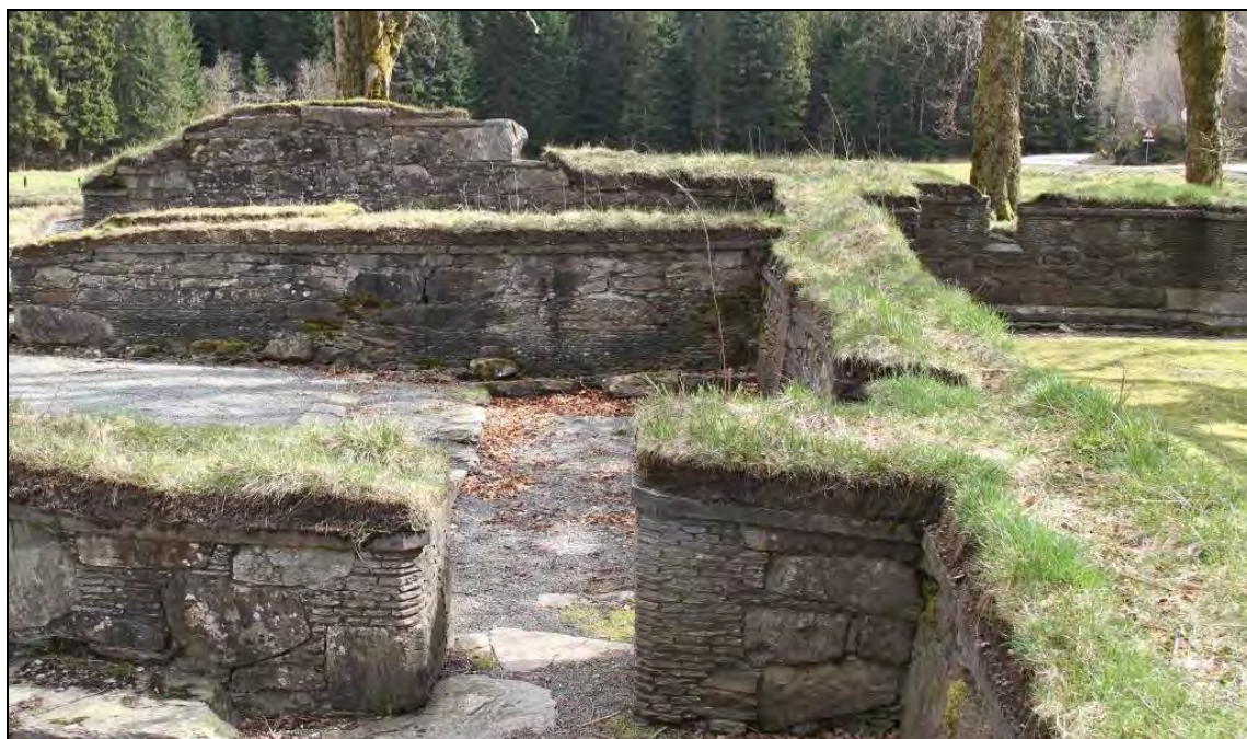
Figur 197: Samme situasjon som forrige bilde i dag (foto: Byantikvaren 2012).
