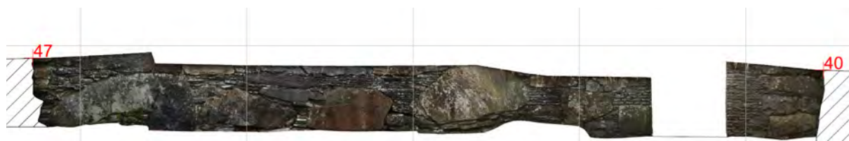
Figur 219: M5 sett fra vest i rom 10. Lengst mot sør er muren delt opp av portalen inn til rom 9. Muren er delvis rekonstruert i småsteinsteknikk (Illustrasjon: Marcin Gladki 2008).
