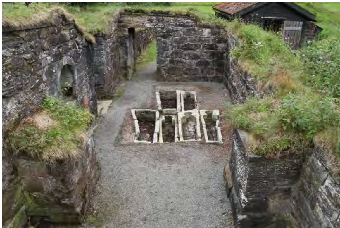
Figur 80: Gravene i nordre kapell ble eksponert i forbindelse med oppføring av nytt vernebygg i 2011 (foto: Byantikvaren 2012).
