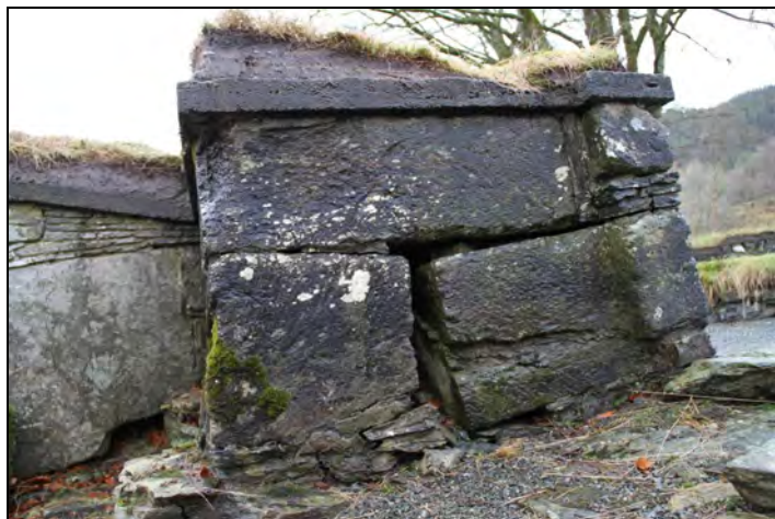
Figur 209: Skade og utsiging av kleberkvadere i døråpning mellom klostergården og rom 9 (foto: Byantikvaren 2012).
