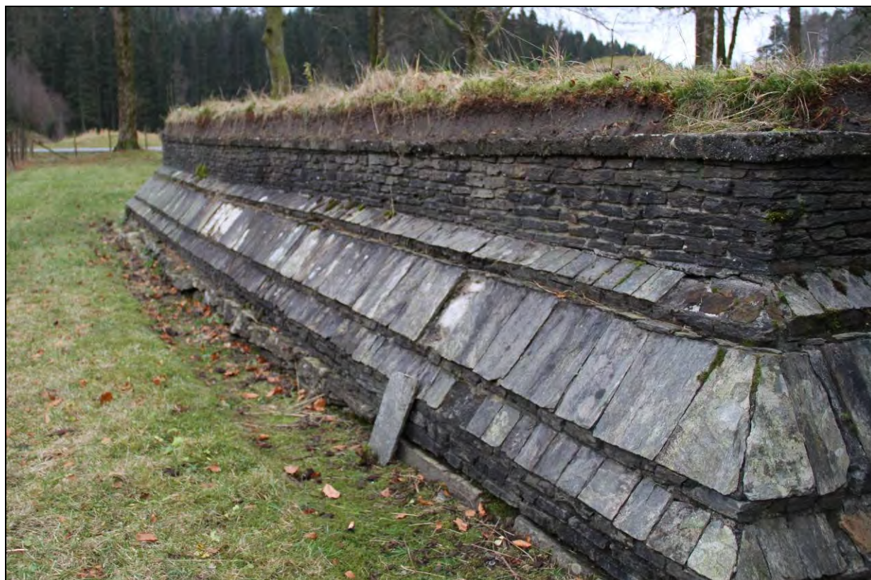
Figur 115. Østmuren i kapittelsalen er i sin helhet rekonstruert over fundamentnivå ved hjelp av småsteinteknikk. Sokkelen langs ytterlivet er rekonstruert ved hjelp av småsteinteknikk og skiferplater (foto: Byantikvaren 2011).
