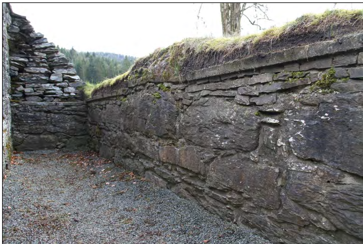
Figur 108: Innerlivet i sørmuren i trapperommet består av bygningsstein i varierende størrelse (foto: Byantikvaren 2012).
