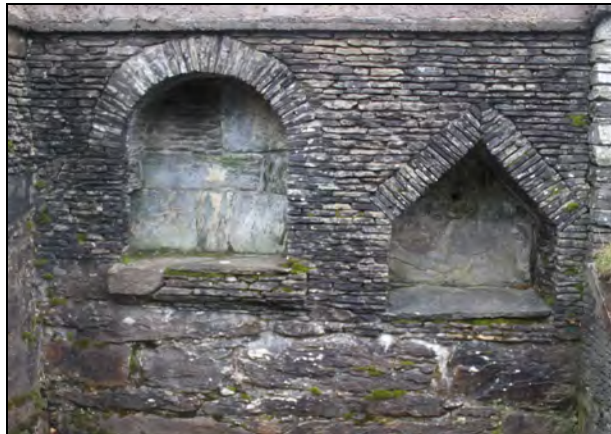
Figur 11. Småsteinsteknikk i rekonstruere nisjer i søndre kapell (foto: Byantikvaren 2011).
