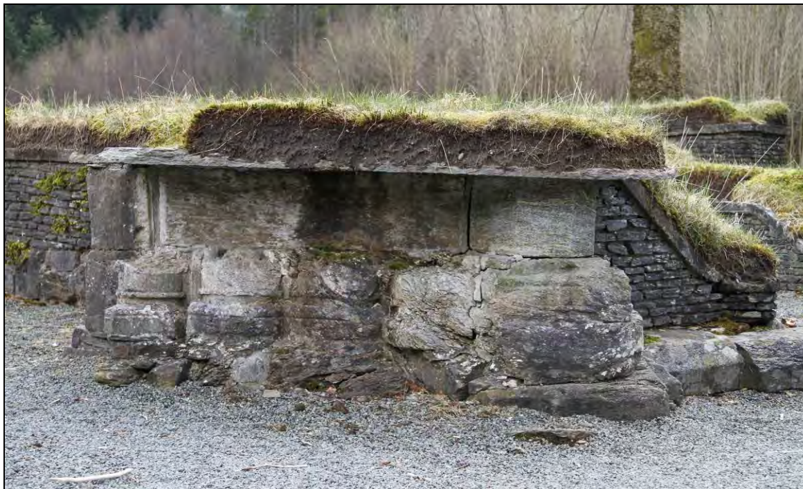
Figur 132. Søndre vange i sørportalen fotografert mot SØ. Enkelte steiner er i total oppøsning (foto: Byantikvaren 2011).
