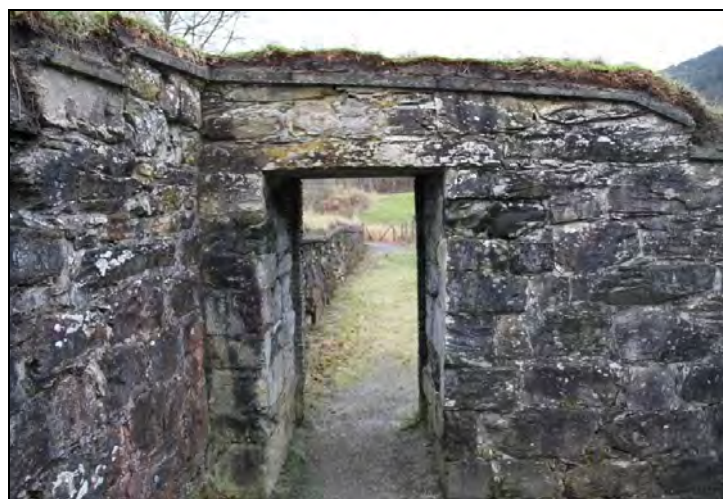
Figur 68: Portalen som fører ut i det fri mot vest (foto: Byantikvaren 2011).
