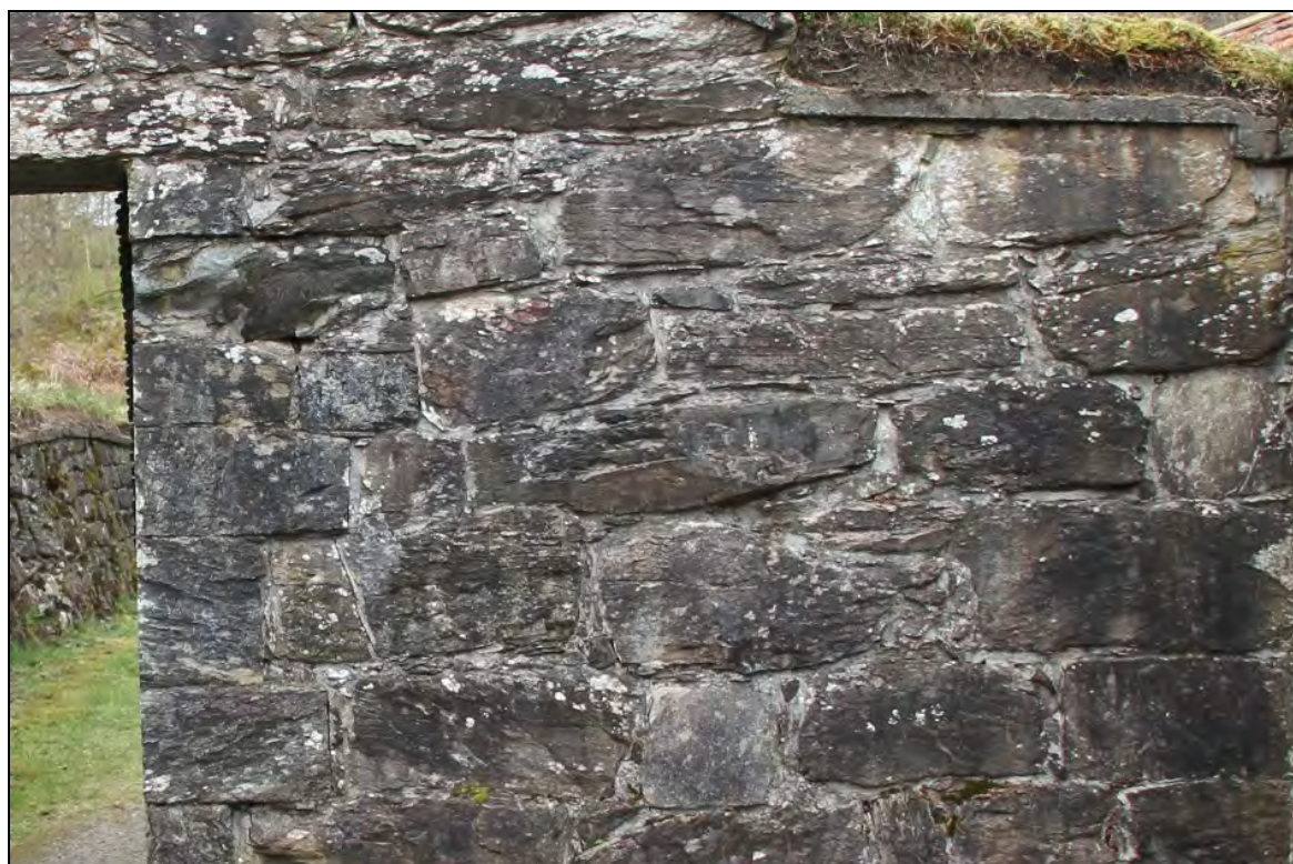
Figur 13. Bruddstein i jevne skift. Fra innerlivet til vestmuren i nordlig kapell (foto: Byantikvaren 2011).
