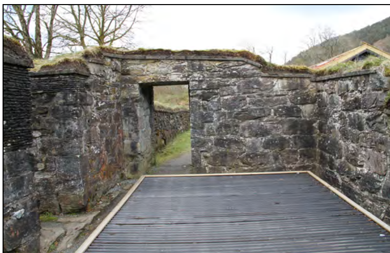
Figur 84: Dagens situasjon i nordre kapell. Et midlertidig vernebygg er lagt over gravene (foto: Byantikvaren 2012).
