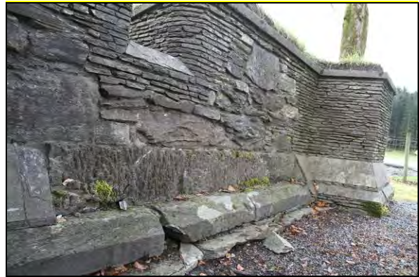
Figur 168. Skader i sokkelsteinen i sørlik del av ytterlivet til vestmuren i dagrommet (foto: Byantikvaren 2011).
