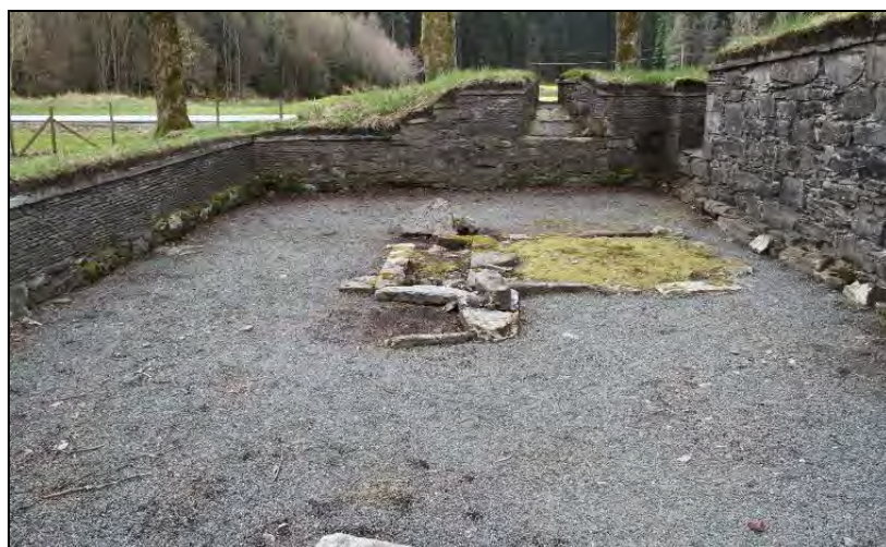
Figur 143. Innsiden av dagrommet mot sør (foto: Byantikvaren 2012).
