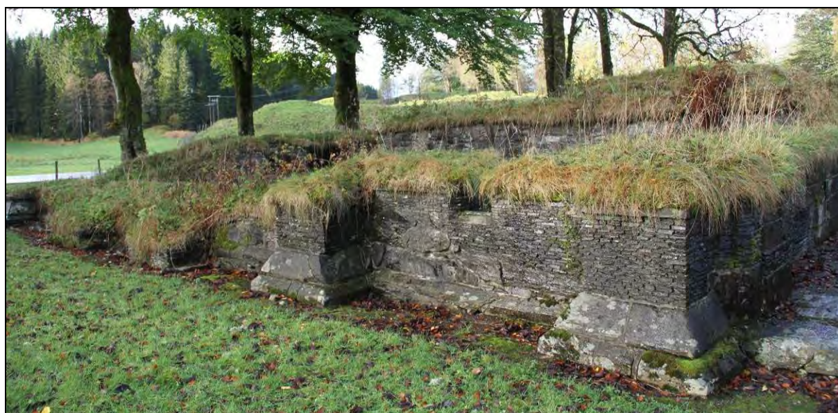
Figur 154. Ytre murliv i østmuren i dagrommet (foto: Byantikvaren 2011).
