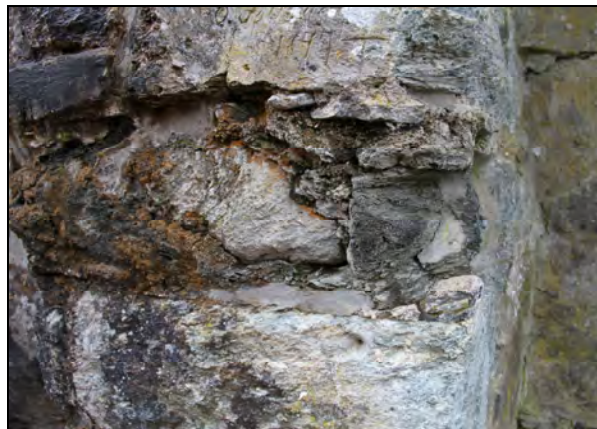
Figur 92: Forvitret og oppsprukket kleberstein i vestvangen i sittenisjen i nordveggen (foto: Byantikvaren 2012)
