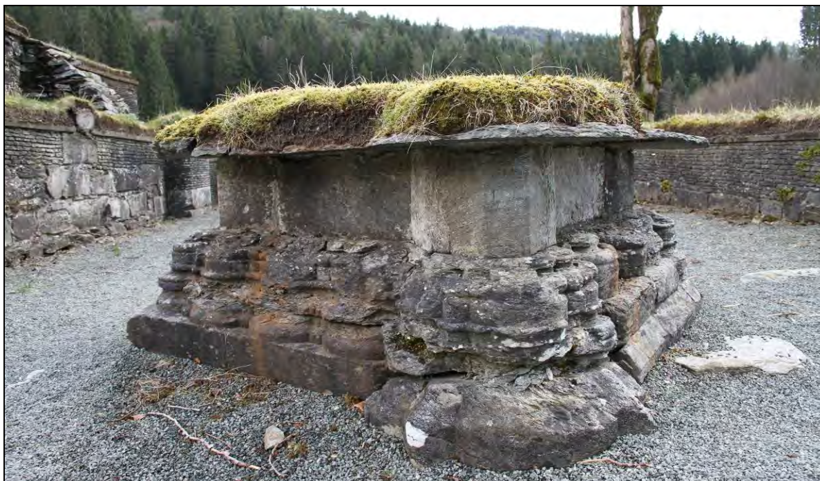
Figur 128. Baseprofilene i portalene til kapittelsalen har store forvitringsskader (foto: Byantikvaren 2011).
