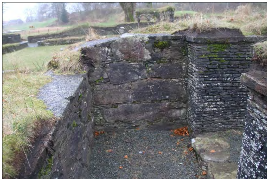
Figur 105: Innerlivet i vestmuren i trapperommet består av opprinnelig murverk. Til høyre den rekonstruerte vestvangen i portalen som leder inn til søndre kapell (foto: Byantikvaren 2012).
