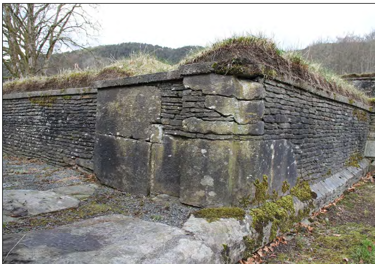
Figur 142. Nordvangen i østlig portal i passasjen består av opprinnelig kleberkvadere og småsteinsteknikk (foto: Byantikvaren 2011).
