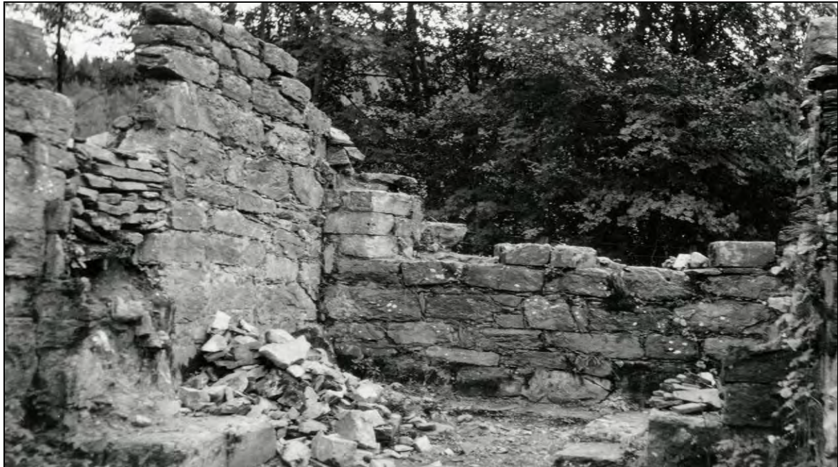
Figur 95: Nord- og østveggen i søndre kapell under istandsettingsarbeidene i 1920-årene (kilde: Riksantikvarens arkiv).
