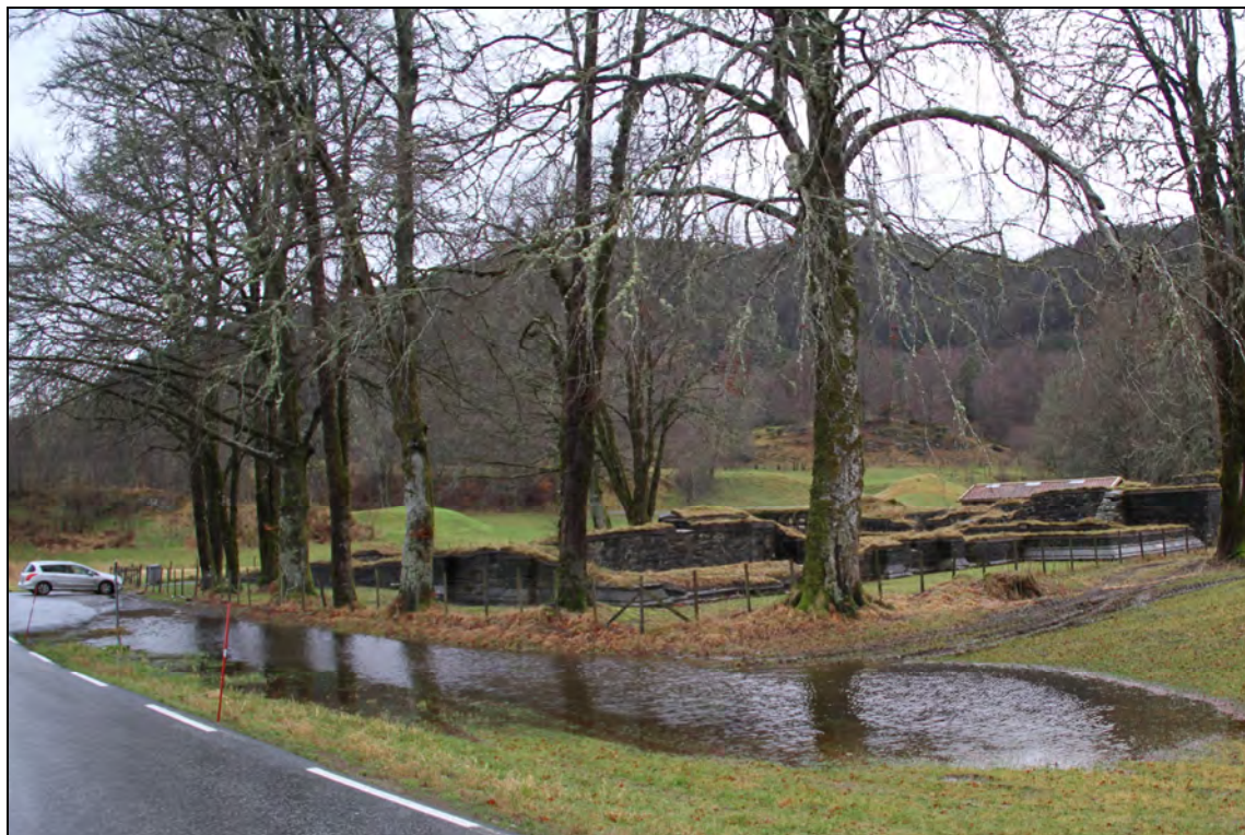
Figur 27. Ved biloppstillingsplassen langs sørsiden av ruinanlegget, dannes en dam ved nedbør. Dette bidrar til fuktige grunnforhold inne i klosterfirkanten (foto: Byantikvaren 2011).
