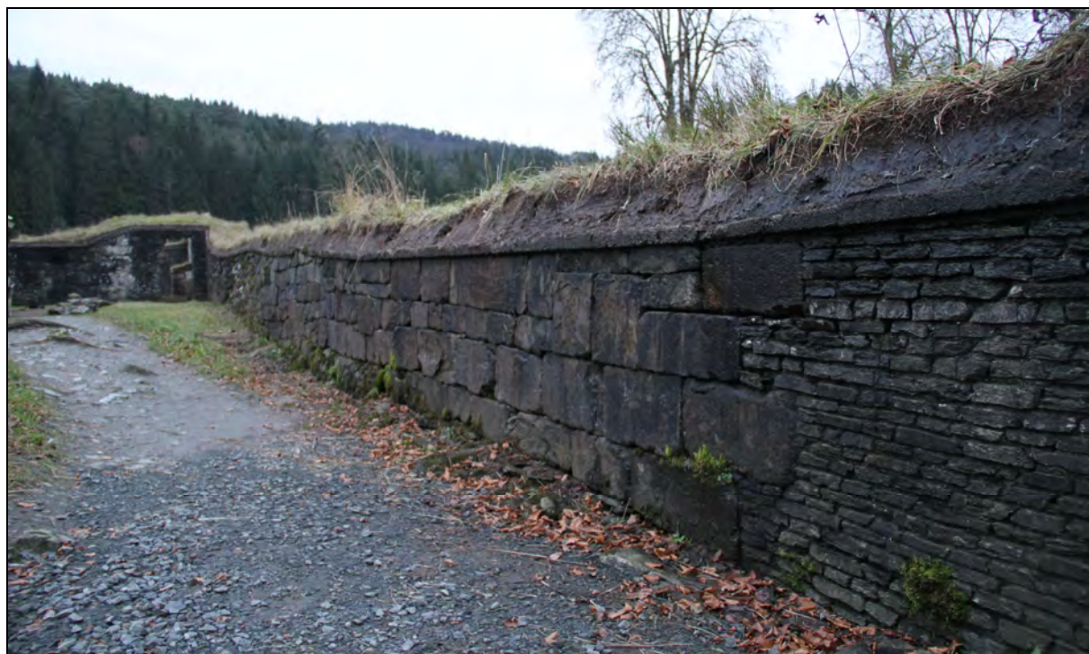
Figur 40: Ytterlivet i nordre langmur i kirken består av tørrmurte kvadere. Fotografert mot øst (foto: Byantikvaren 2012).
