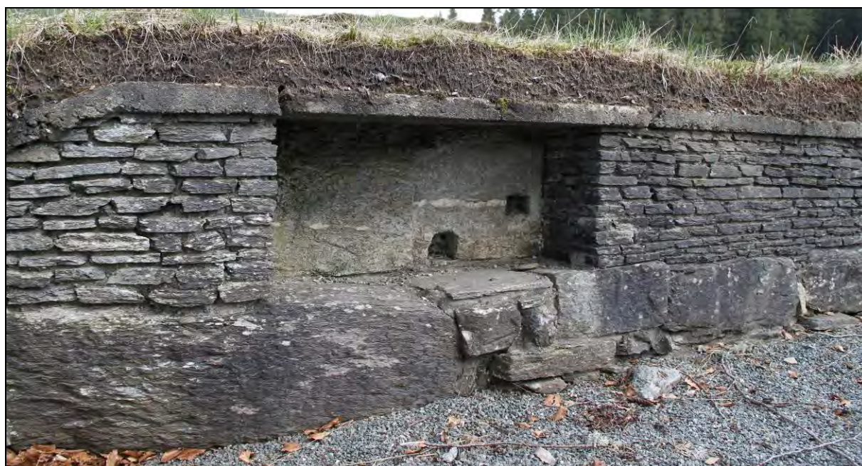
Figur 136. Nisjen i nordmuren i samtalerommet (foto: Byantikvaren 2011).
