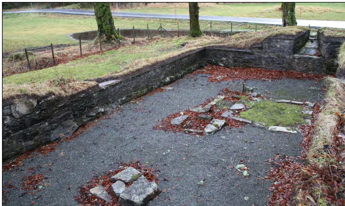
Figur 170. I gulvet i dagrommet ligger fundamenter til tre hvelvpilarer og en kvadratisk steinsetting som er tolket som grue. Foto mot SØ (foto: Byantikvaren 2011).
