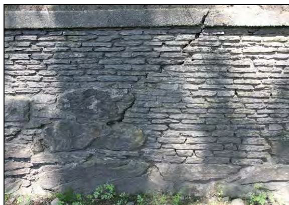
Figur 199: Skråriss i sørmurens ytterliv (foto: Byantikvaren 2012).
