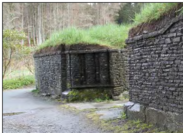
Figur 35: Vestportalen i kirken fotografert mot NØ (foto: Byantikvaren 2012).
