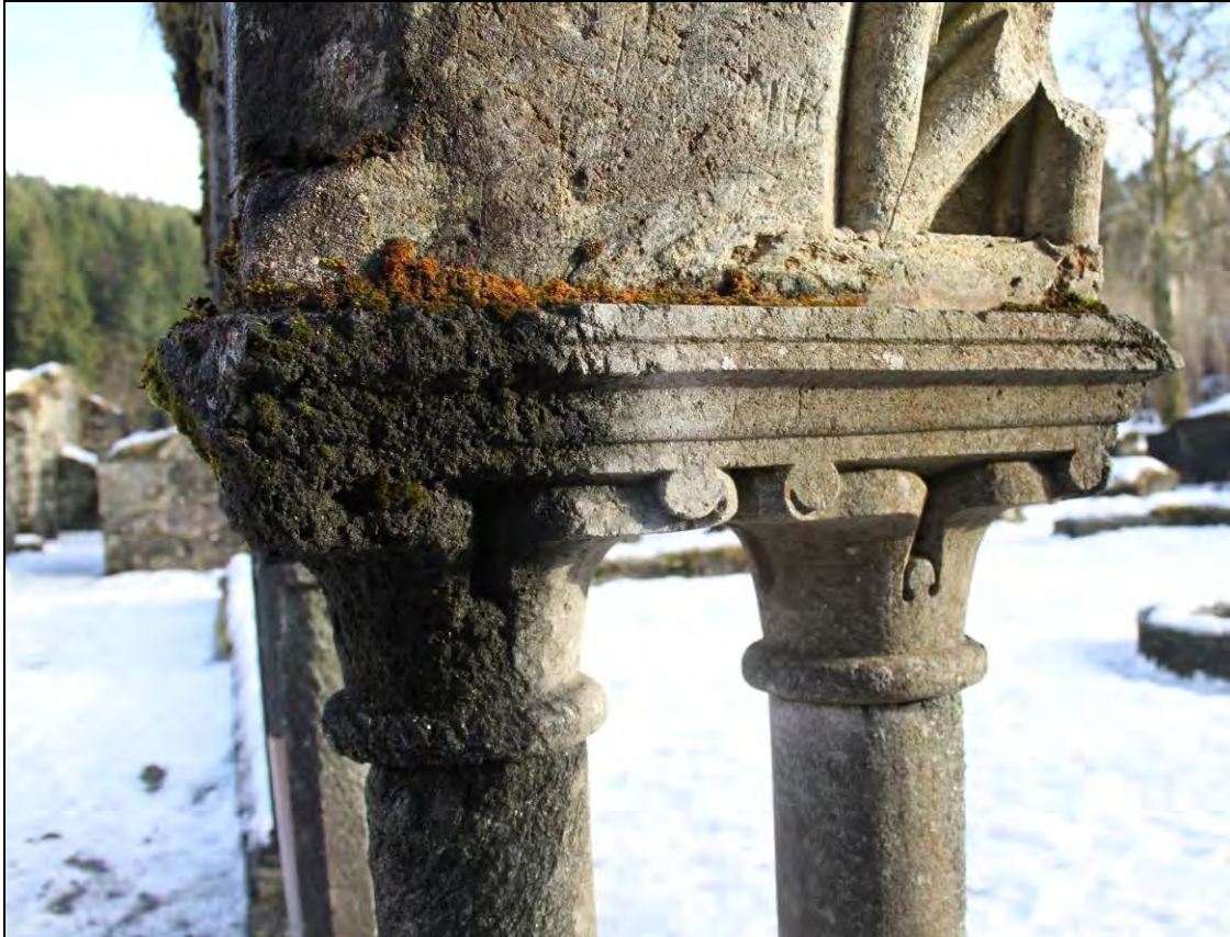
Figur 179. Kritisk forvitring på østlig side av kapitel og klebersteinssøyle i arkaderekken (foto: Byantikvaren 2008).
