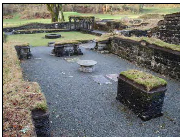
Figur 109. Kapittelsalen med en rektangulær pilar rekonstruert i småsteinteknikk nærmest i bildet (foto: Byantikvaren 2011).
