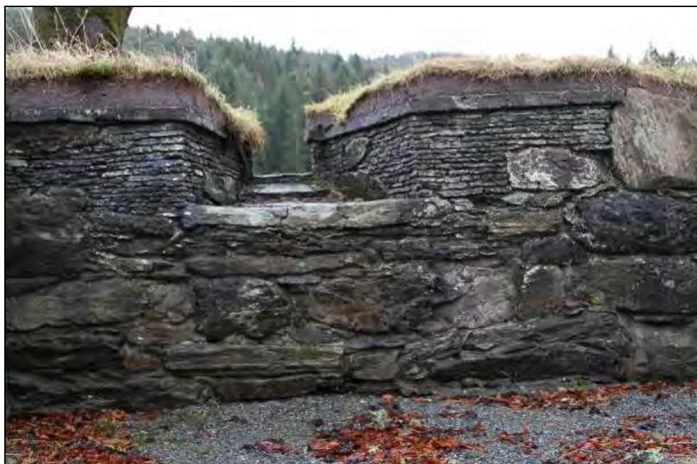
Figur 152. Rekonstruert vindussmyg i østmuren sett fra innsiden av dagrommet (foto: Byantikvaren 2011).
