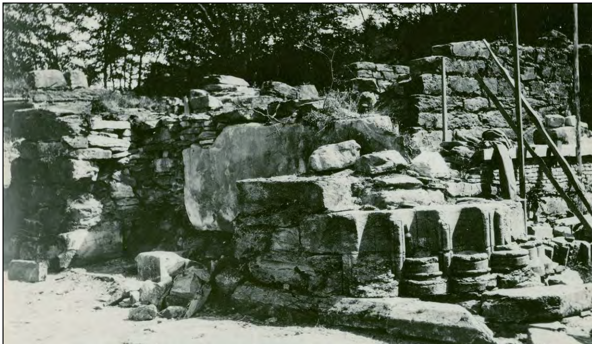
Figur 127. Nordre portalvange mot NØ, under restaureringene på 1920-tallet (Kilde: Riksantikvarens arkiv).
