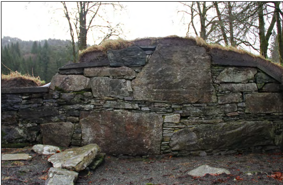
Figur 16. Gotisk murverk i innerlivet i østmuren, rom 11 i sørfløyen (foto: Byantikvaren 2011).
