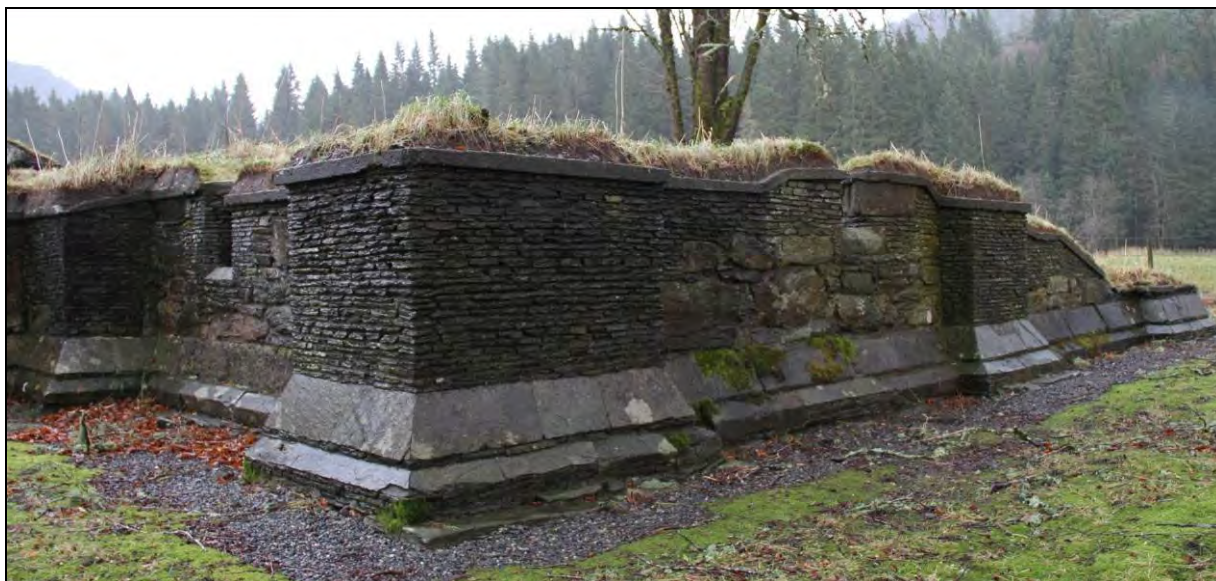
Figur 159. Sørvestlig hjørne i ytterlivet i sørmuren i dagrommet (foto: Byantikvaren 2011).
