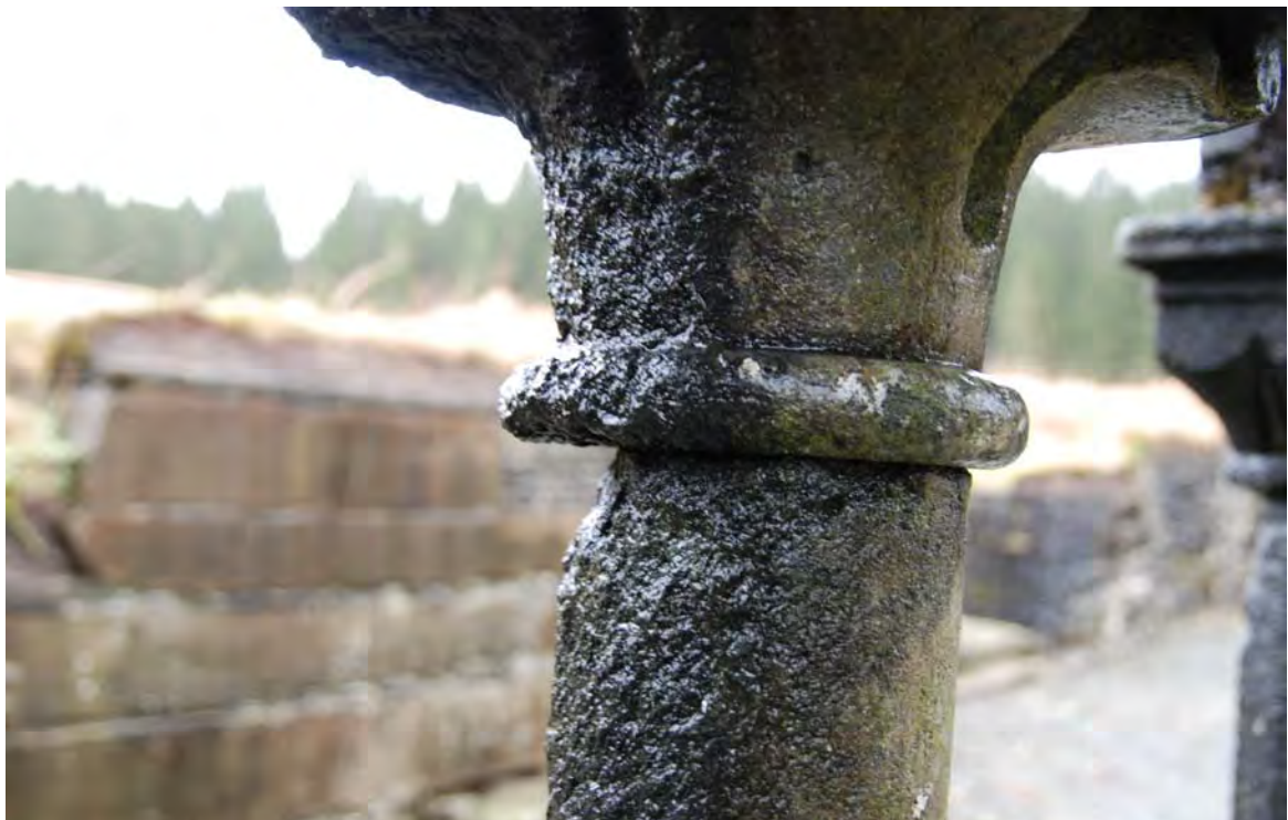
2005/22.04-049: Overgang mellom kapitel og søyle der høyre side av søyle og kapitel er mer beskyttet for fukt.
