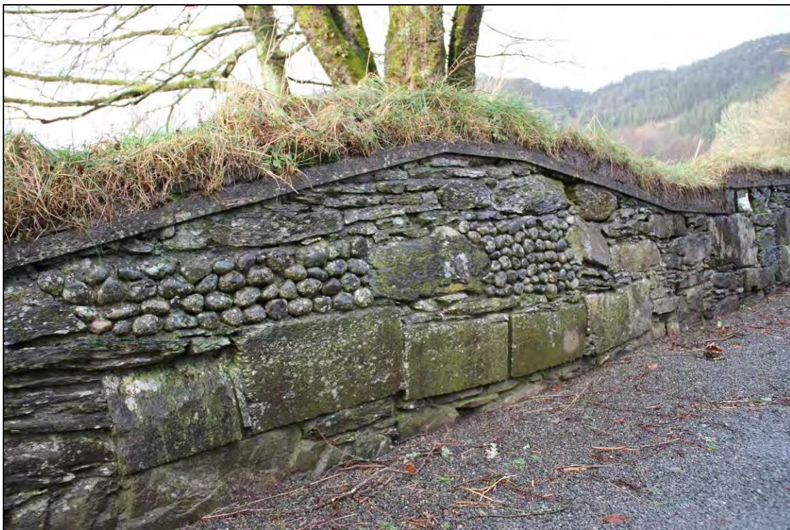
Figur 189. Innerlivet til vestmuren i klostergården består av bruddstein, enkelte kvaderstein og rekonstruert murverk med rullestein (foto: Byantikvaren 2011).
