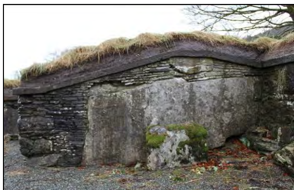
Figur 224: Østsiden av M6 består hovedsakelig av en stor steinblokk. Rundt steinen er det rekonstruksjoner av småsteinteknikk (foto: Byantikvaren 2012).
