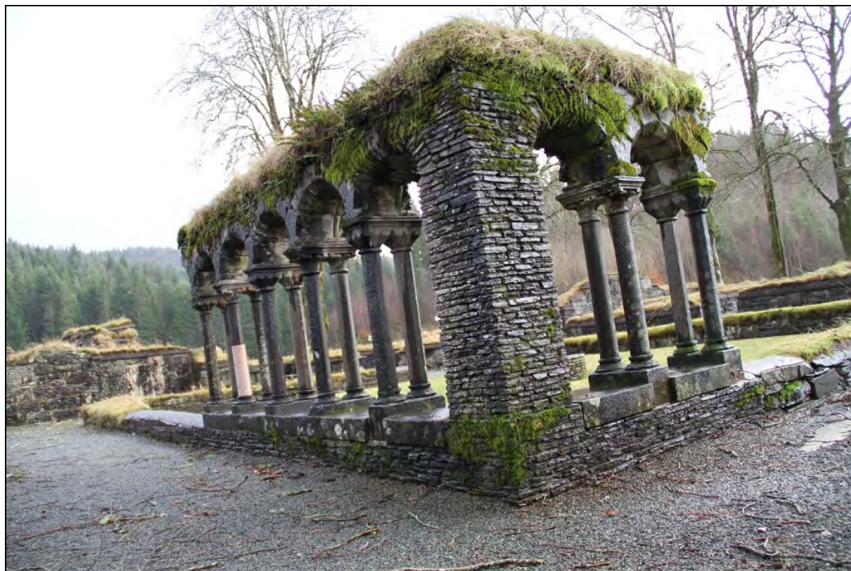
Figur 173. Arkaderekken på Lyse er rekonstruert. Den ble gjenreist med en blanding av originale bygningsdeler, tillagede kopier og småsteinteknikk i 1929 og 1931 (foto: Byantikvaren 2011).
