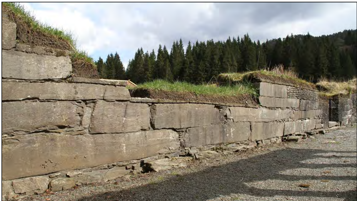
Figur 52: Murverket i ytterlivet til sørmuren, mot klostergården, skiller seg fra resten av anlegget. Her er ytterlivet murt opp av store kvaderliknende byggestein, i jevne skifte ganger og med lite bruk av pinning (foto: Byantikvaren 2012).
