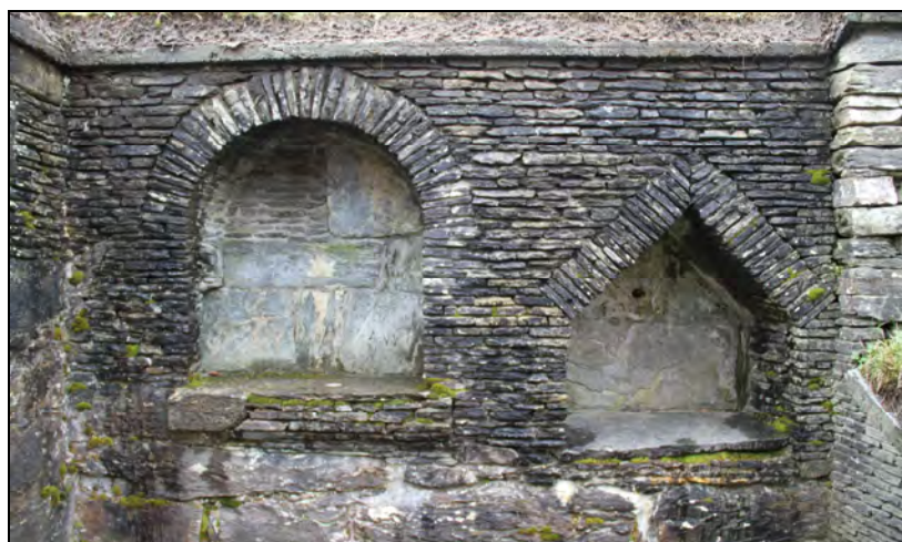
Figur 102: Dagens situasjon i sørmurens innerliv med to delvis rrekonstruerte skapnisjer (foto: Byantikvaren 2012).
