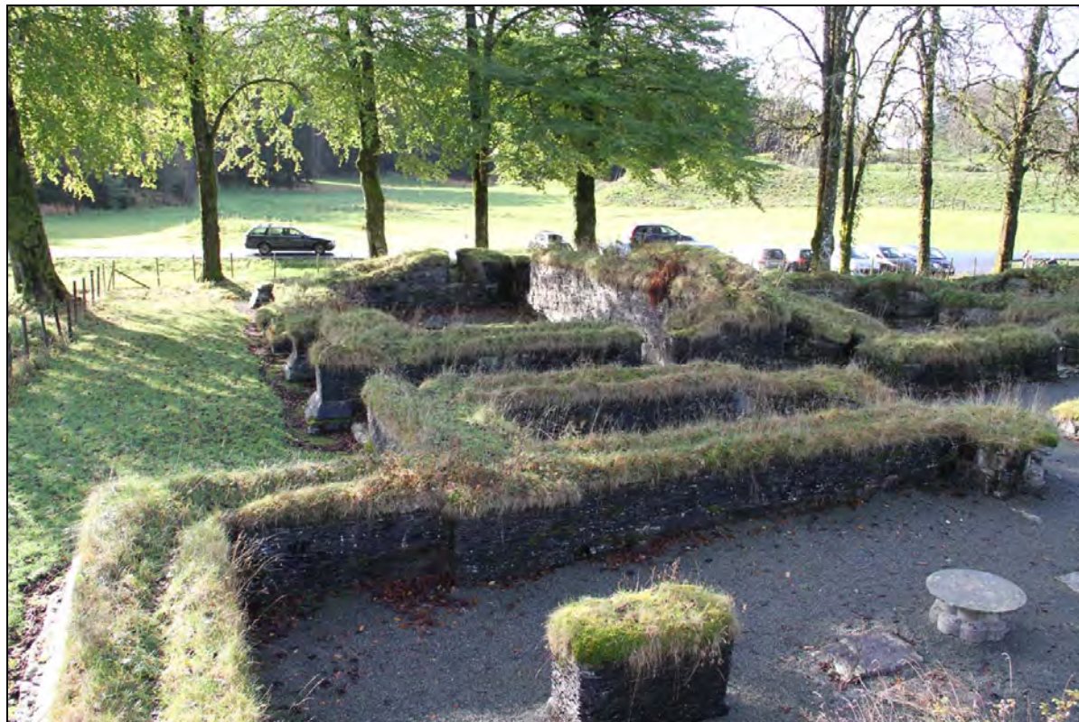
Figur 17. Toppdekningen på murene består av armert sementdekke med tykke torvlag over. Stier i torvdekket, som flere steder viser slitasje ned til sementen, forteller om mye tråkk på murkronene. Bildet viser sørøstlig del av klosterfirkanten mot sør (foto: Byantikvaren 2010).
