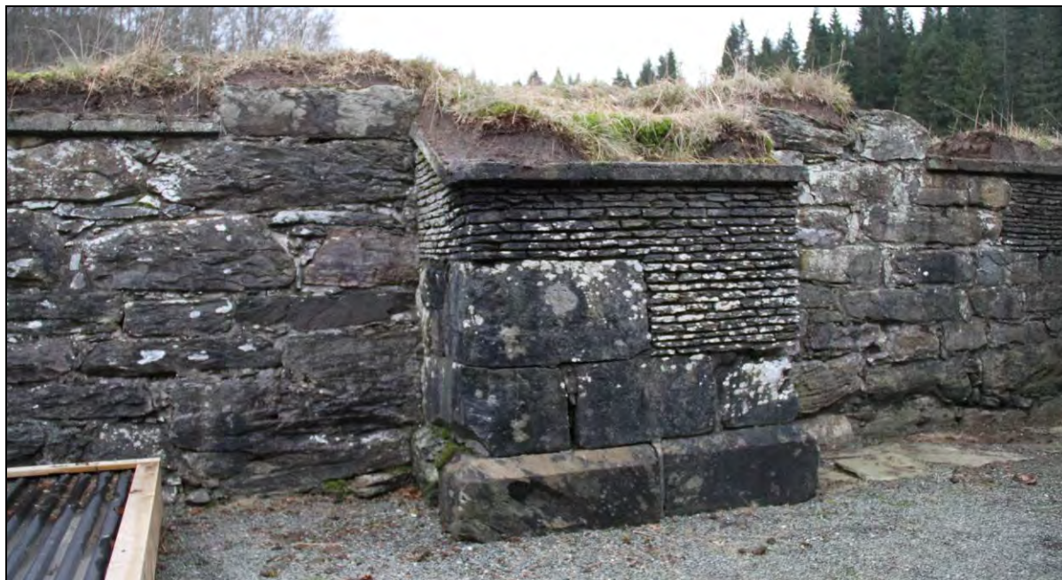
Figur 73: Nordveggen innerliv med en delvis rekonstruert pilaster (foto: Byantikvaren 2011).
