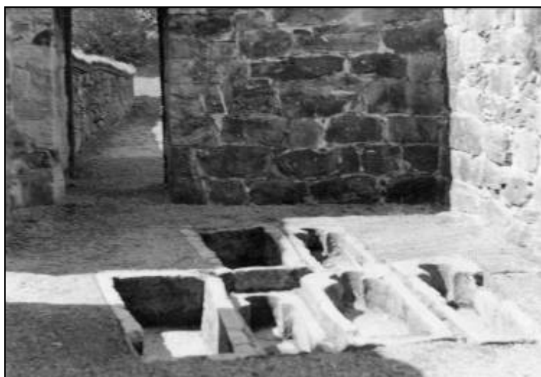
Figur 83: Gravene i nordre kapell under restaureringen i 1950-årene. Gravkistene er rettet opp og murlivene i kapellet er spekket med sementmørtel (kilde: Riksantikvarens arkiv).
