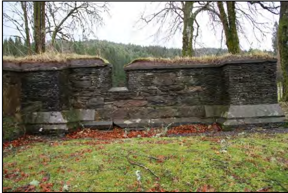
Figur 167. Sørlik del av ytterlivet til vestmuren i dagrommet (foto: Byantikvaren 2011).
