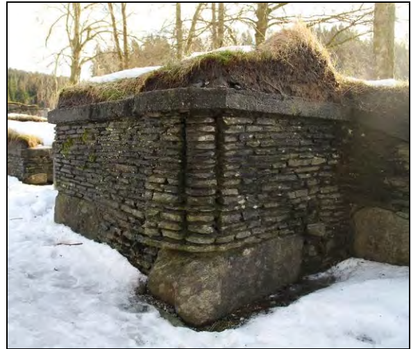
Figur 188. Bortsett fra to sokkelstein er hele sørlig vange i åpningen rekonstruert med småsteinteknikk (foto: Byantikvaren 2011).
