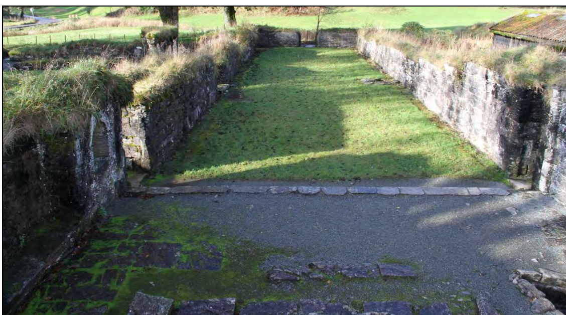
Figur 33: Innsiden av kirken fotografert mot vest (foto: Byantikvaren 2012).
