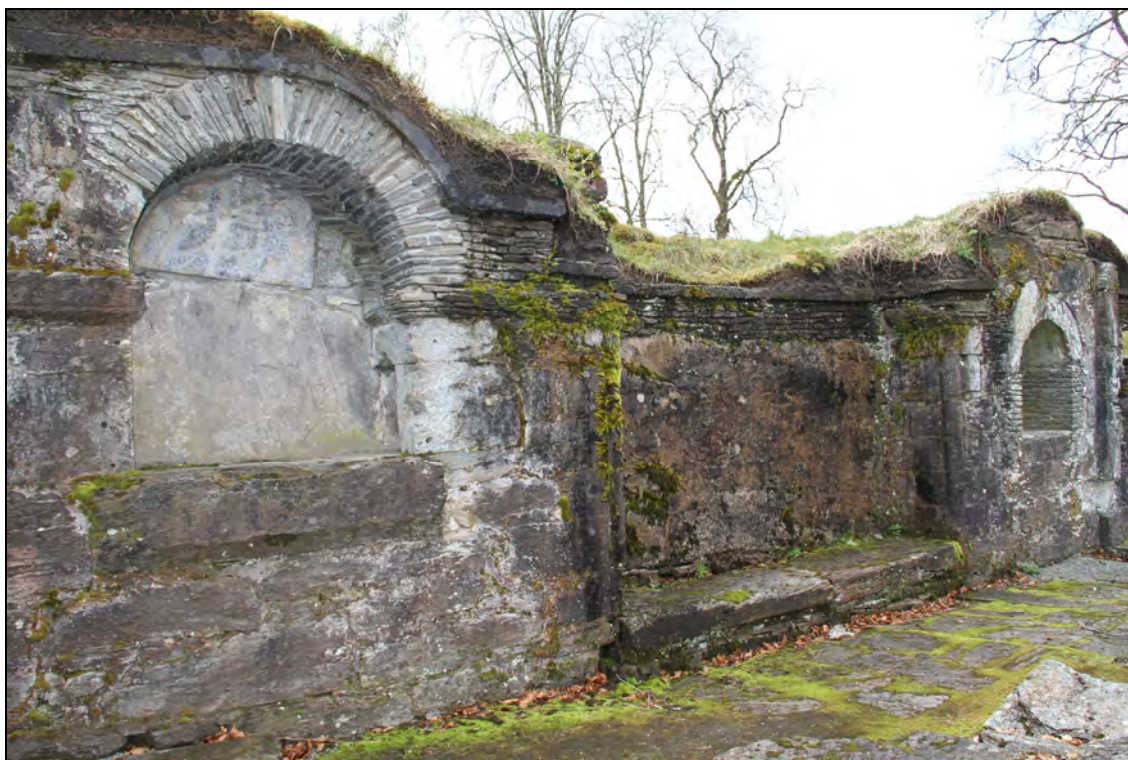
Figur 56: Sørveggen i koret i kirken med en stor sittenisje flankert av to delvis restaurerte repositorium (skap) (foto: Byantikvaren 2012).
