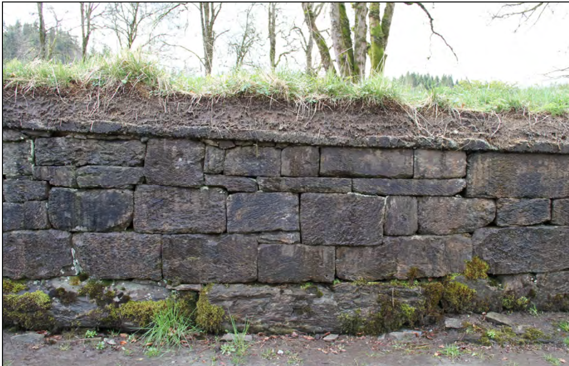
Figur 14. Rekonstruert ytterliv av gjenbrukt kvaderstein i kirkens nordlige langmur. (foto: Byantikvaren 2011).
