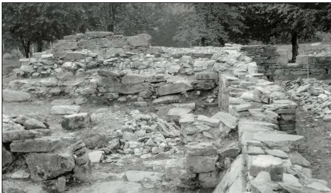
Figur 196: Sørfløyen under restaureringsarbeidene i 1920-årene, mot øst. Mye av bygningssteinen som ligger løst i hauger ble benyttet til å gjenreise murene (foto: Riksantikvarens arkiv).
