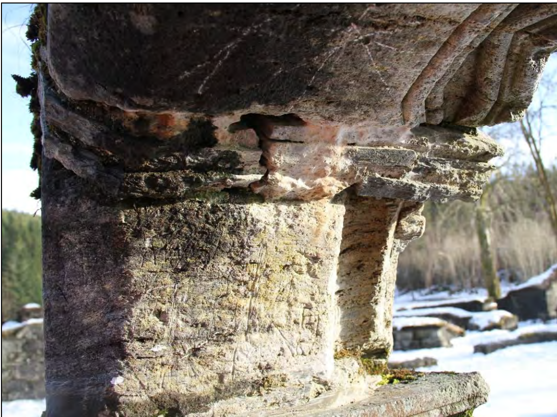
Figur 180. Kraftige kalkutfellinger under innfatningssteinene i arkadebuene (foto: Byantikvaren 2008).
