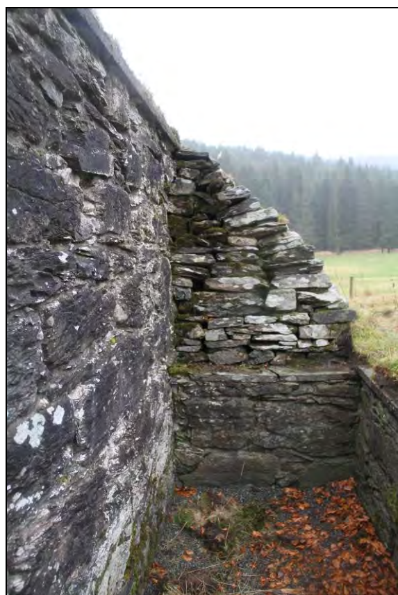
Figur 107: Østmuren i trapperommet er delvis murt av bygningsstein og delvis som tørrmur. Det er plassert skiferheller i skillet mellom de to murtypene (foto: Byantikvaren 2012).
