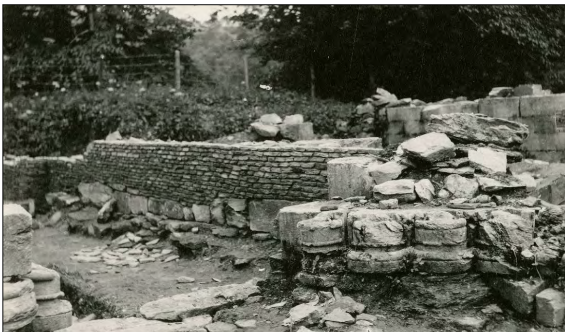
Figur 133. Søndre portalvange mot SØ, under restaureringene på 1920-tallet (Kilde: Riksantikvarens arkiv).
