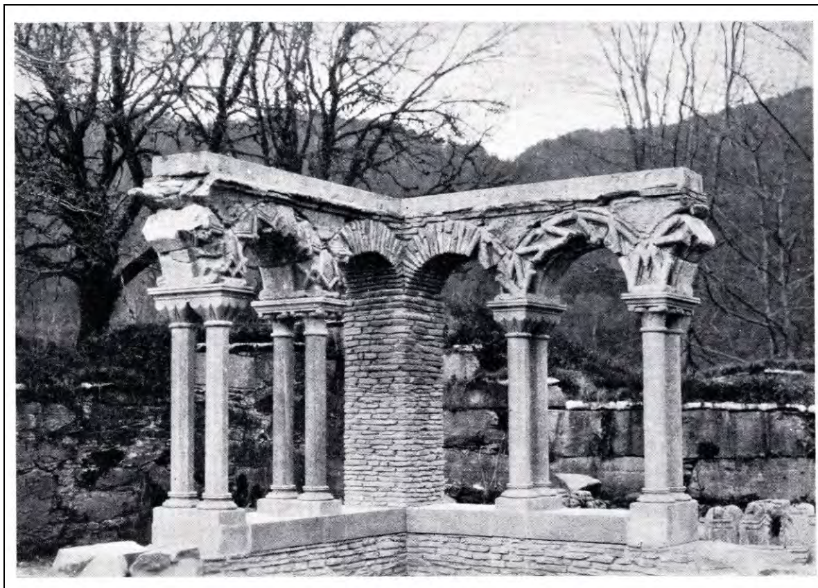
Figur 175. Buegangen ble rekonstruert i to omganger. Her fra første del av arbeidet hvor de første fire søyleparene med buer er oppført i 1929 (Kilde: Lexow 1930:17).
