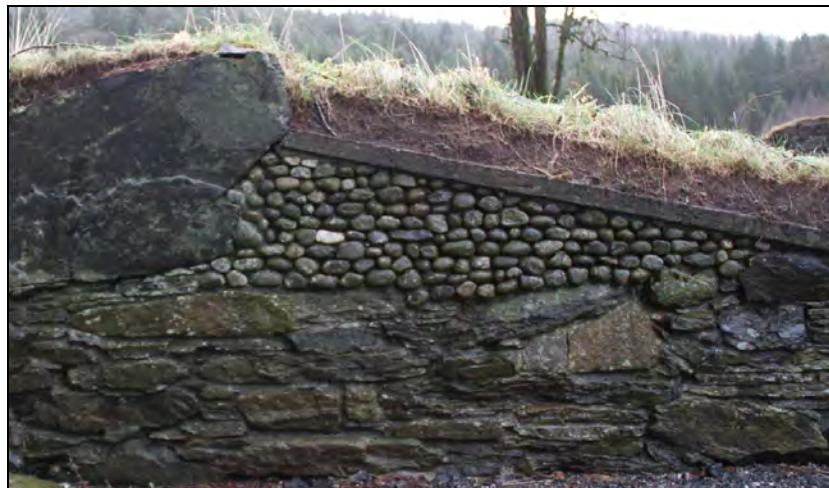
Figur 8. Bildet viser et parti i ytre murliv i vestmuren mot klostergården, som ble rekonstruert ved hjelp av rullesteinteknikk på 1920-tallet (foto: Byantikvaren 2010).
