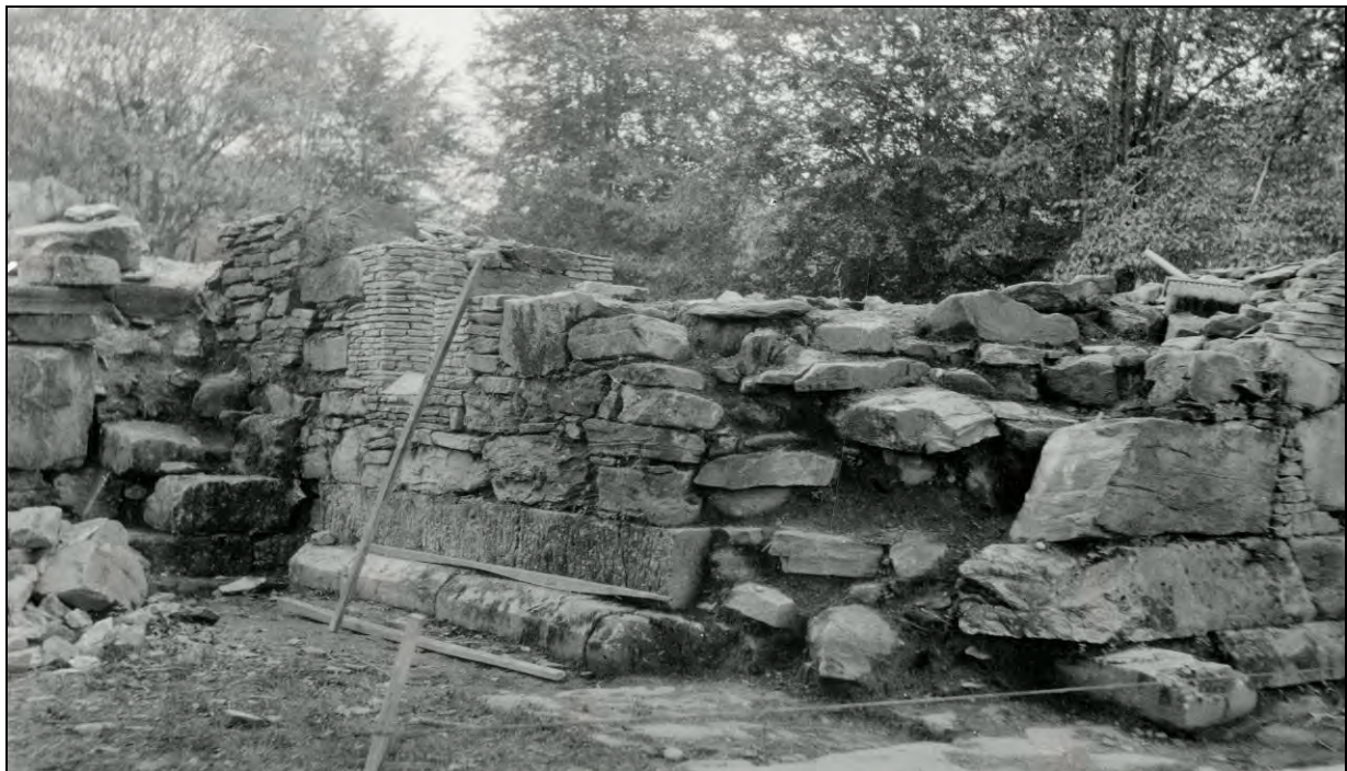
Figur 169. Murverket i ytterlivet i vestmuren under restaureringene på 1920-tallet (Kilde: Riksantikvarens arkiv).
