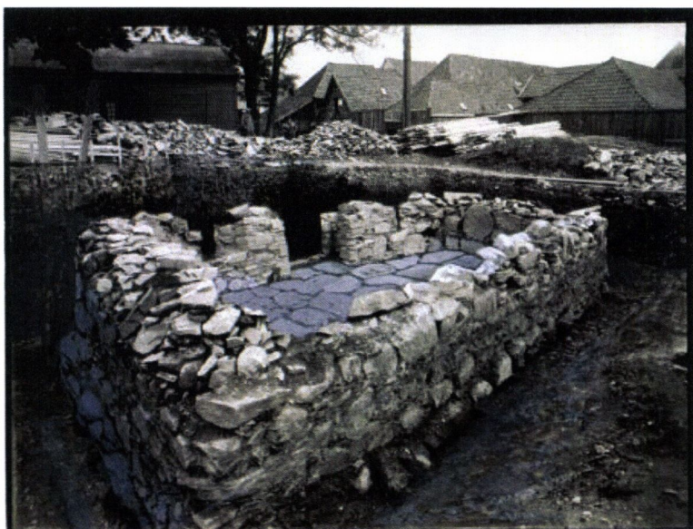
Illustrasjon 9: Foto av utgravd ruin. Arbeidet med forskalingen er i gang, og det er mulig å skimte de store søylefundamentene som utgjør mesteparten av arealet inne i ruinrommet. Bildet viser også at det er stablet mye løs stein ved portalen og på østmurens krone (Foto: Det Hanseatiske museum: HMB-F.01048 ).
