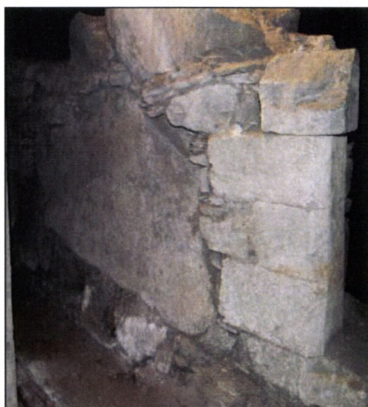
Illustrasjon 16: Utsiden av vestlig klebersteinsvange i portalen. Det står igjen fem klebersteiner på hver side (Foto: Byantikvaren 2011).
