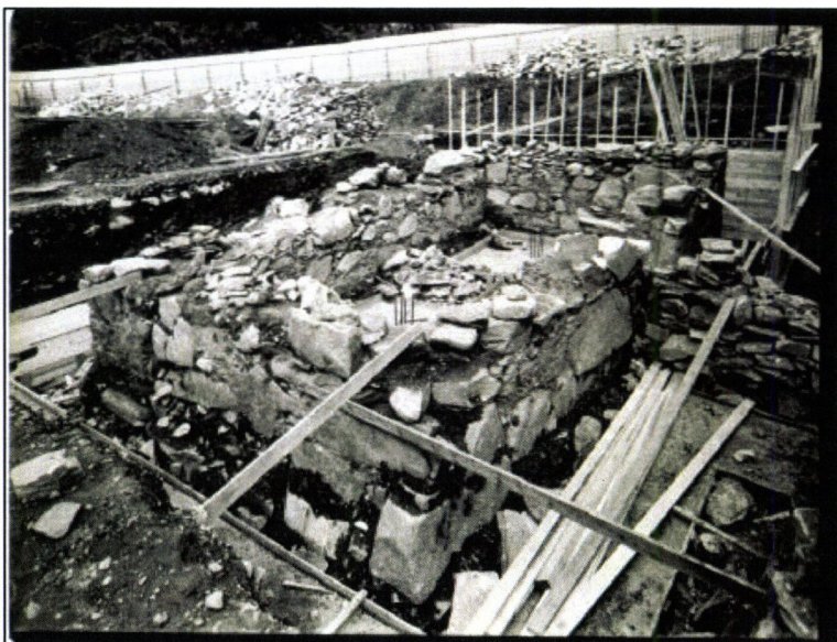
Illustrasjon 9: Foto av utgravd ruin. Arbeidet med forskalingen er i gang, og det er mulig å skimte de store søylefundamentene som utgjør mesteparten av arealet inne i ruinrommet. Bildet viser også at det er stablet mye løs stein ved portalen og på østmurens krone (Foto: Det Hanseatiske museum: HMB-F.01048 ).
