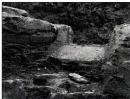
Illustrasjon 18: Utsnitt fra arkivfoto (1935) av østlig vindu, sett fra innsiden. Det er hugget ut en fals for innfestning av karm (Foto: Det Hanseatisk museum HMB-F.01053_a ).
