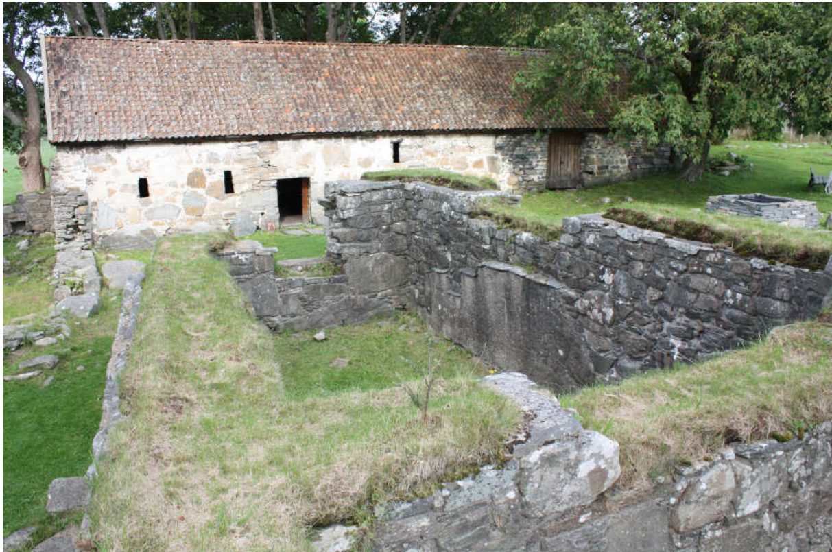
Fig.21 Foto av rom NS1 tatt fra murkronen mot nordvest. I nordmuren sees den enorme stein som er murt inn i det indre murlivet. I vestmuren er murverket brutt der hvor det har stått en vindusåpning. I bakgrunnen sees vestfløyen med rom V4 og rom V3. Foto RM, 19-20.08.09.
