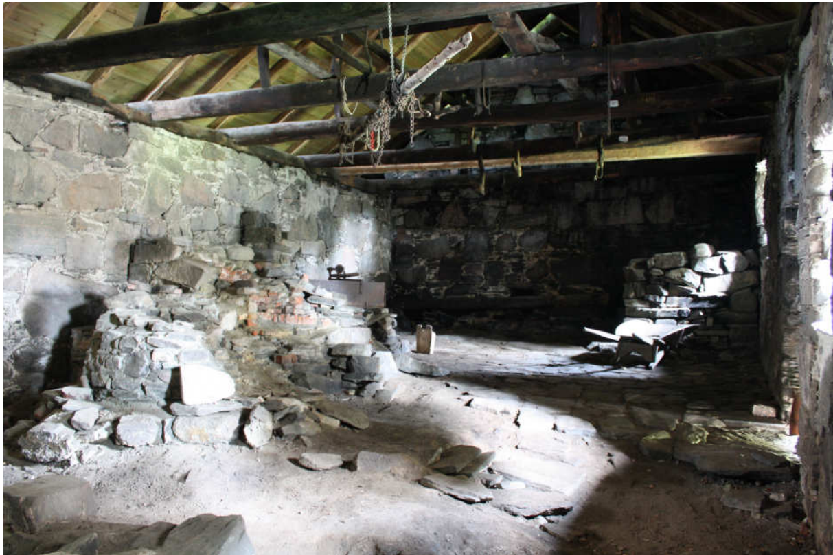
Fig.19 V4s nordre halvdel. Til venstre står de omtalte ovnene henholdsvis murt med gråstein og teglstein. Foto tatt mot nordvest av RM, 19-20.08.09.
