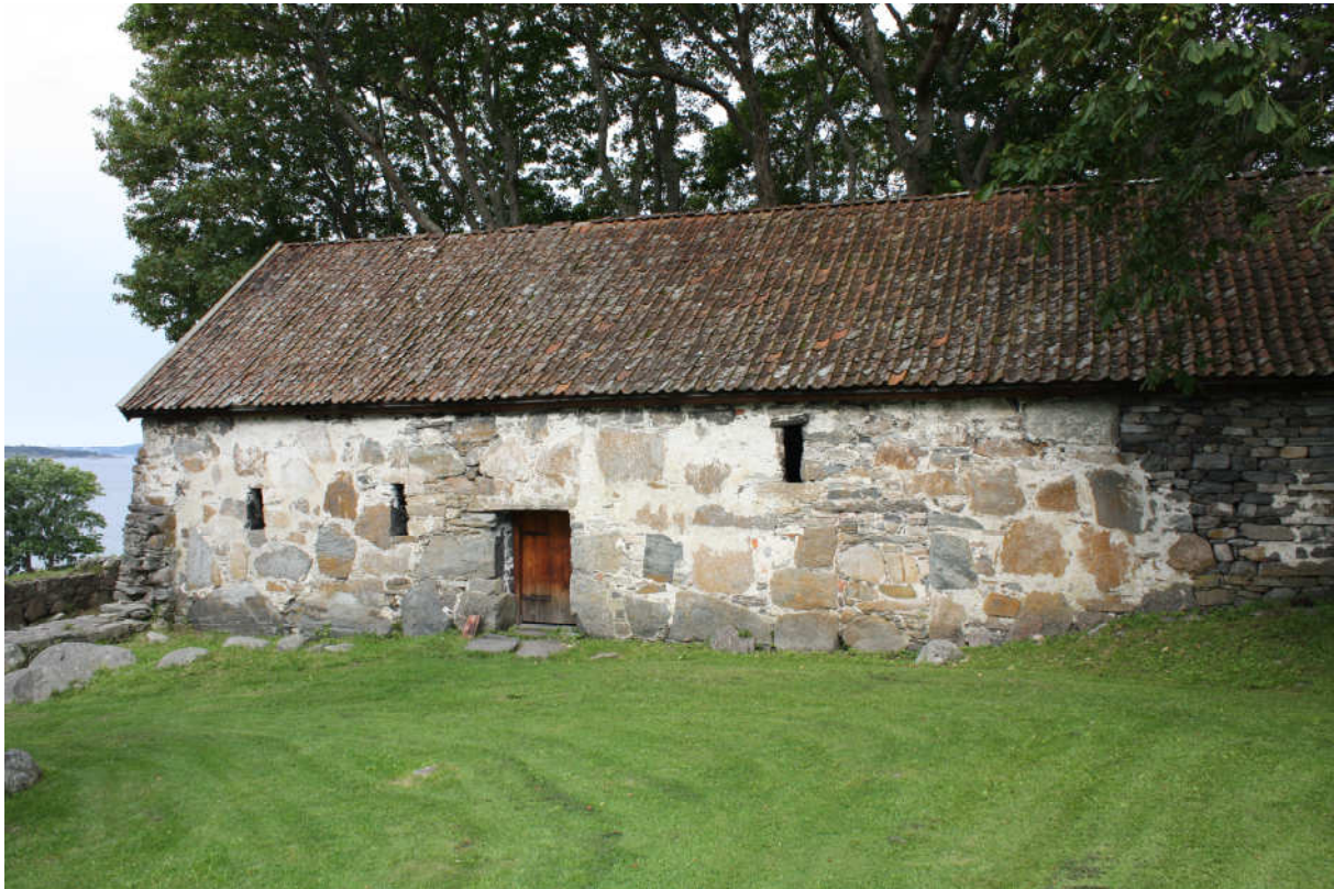
Fig. 15 Rom V4 sett fra øst mot vest med ytre murliv, døråpning og tre vinduer. Legg merke at det er bevart gammel murpuss på veggene. Foto RM, 19-20.08.09.
