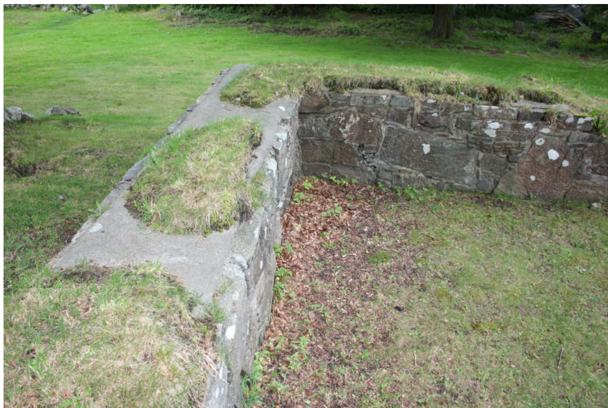
Fig.34 Foto av toppavdekningen på S3's østmur og sørmur. Den består av heldekkende sementavdekning med torv på. Foto tatt mot syd av RM, 19-20.08.09.
