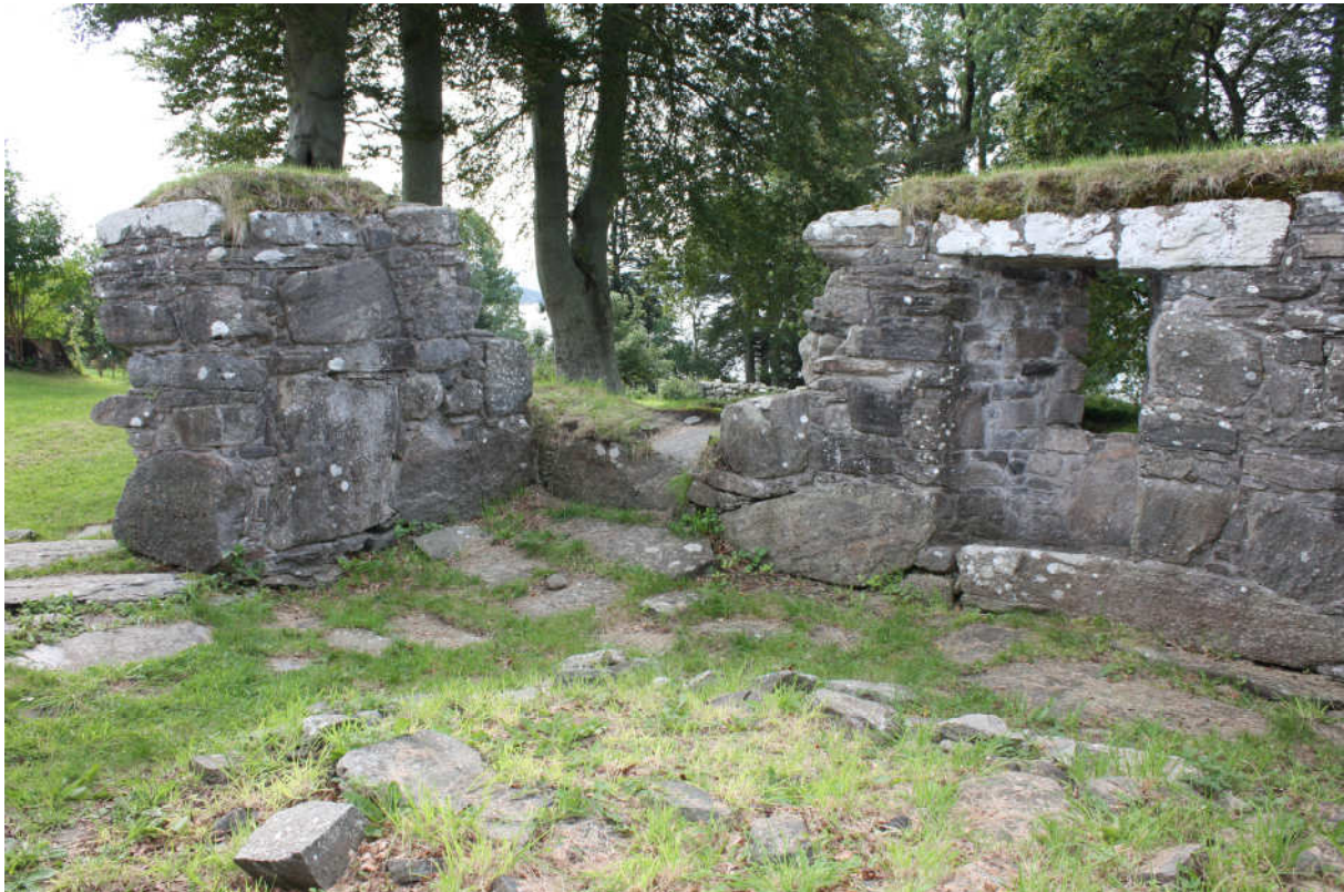
Fig.24 Sørsmuren i rom NS2 med midtre vindusåpning samt det brutte murverket i hjørnet hvor det også kan ha vært et vindu. Til venstre sees døråpningen i østmuren. Foto viser godt hvor gjengrodd gulvet er og hvor lite synlig ildstedet er (nederst på bildet). Foto RM, 19-20.08.09.
