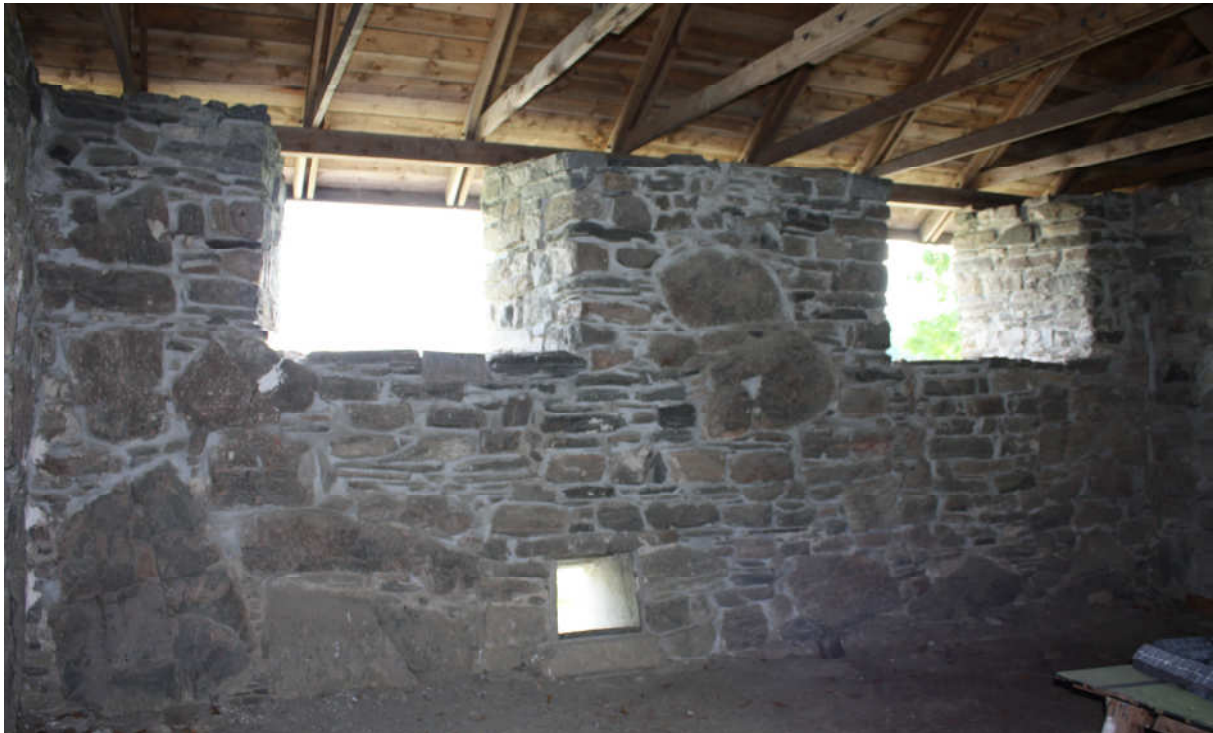
Fig.7 Nordmuren i N2, det indre murlivet. Foto RM, 19-20.08.09.
