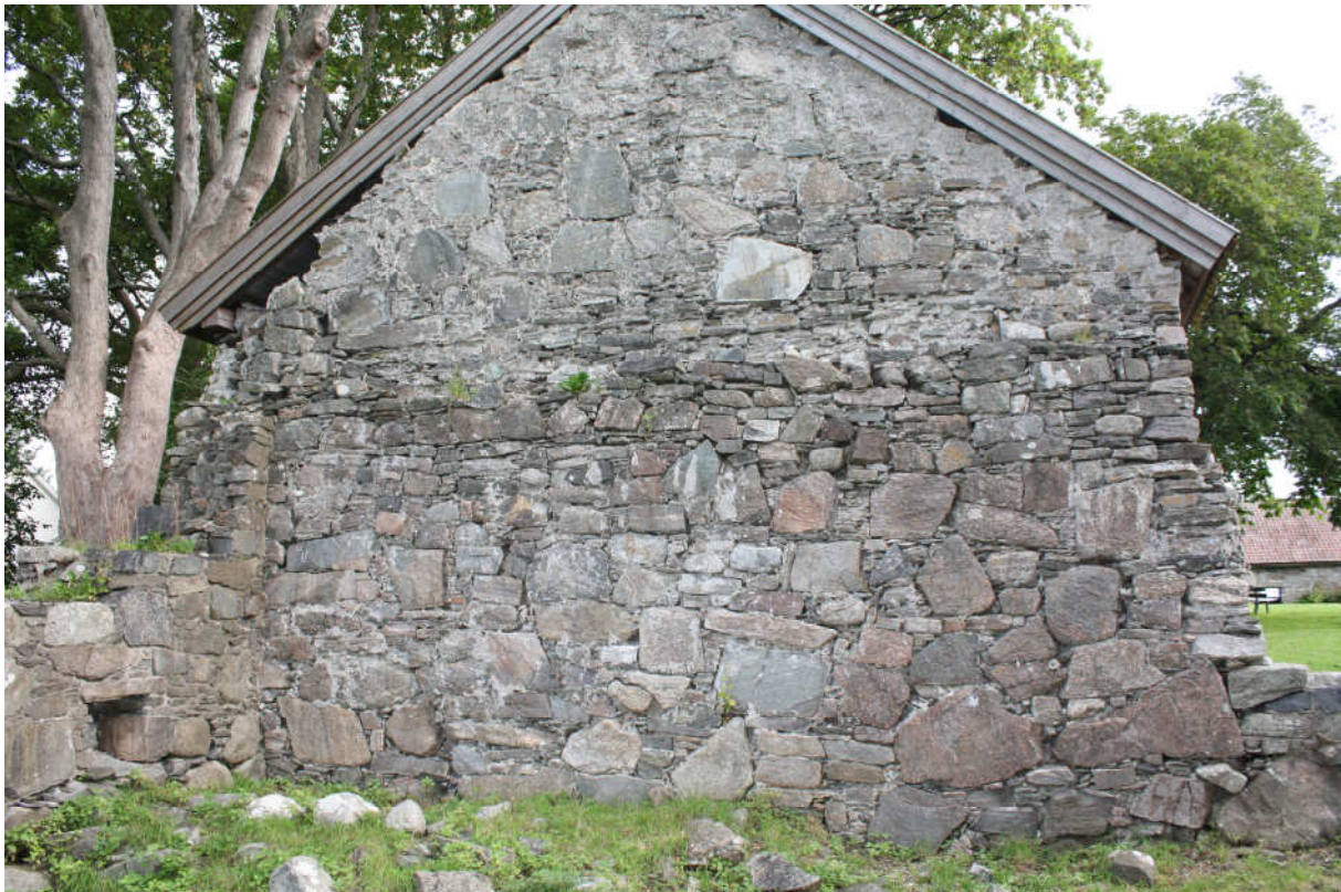
Fig.26 Nordmuren i S1 (vestre del) med mye originalt gotisk murverk. Foto tatt mot nord av Foto RM, 19-20.08.09.
