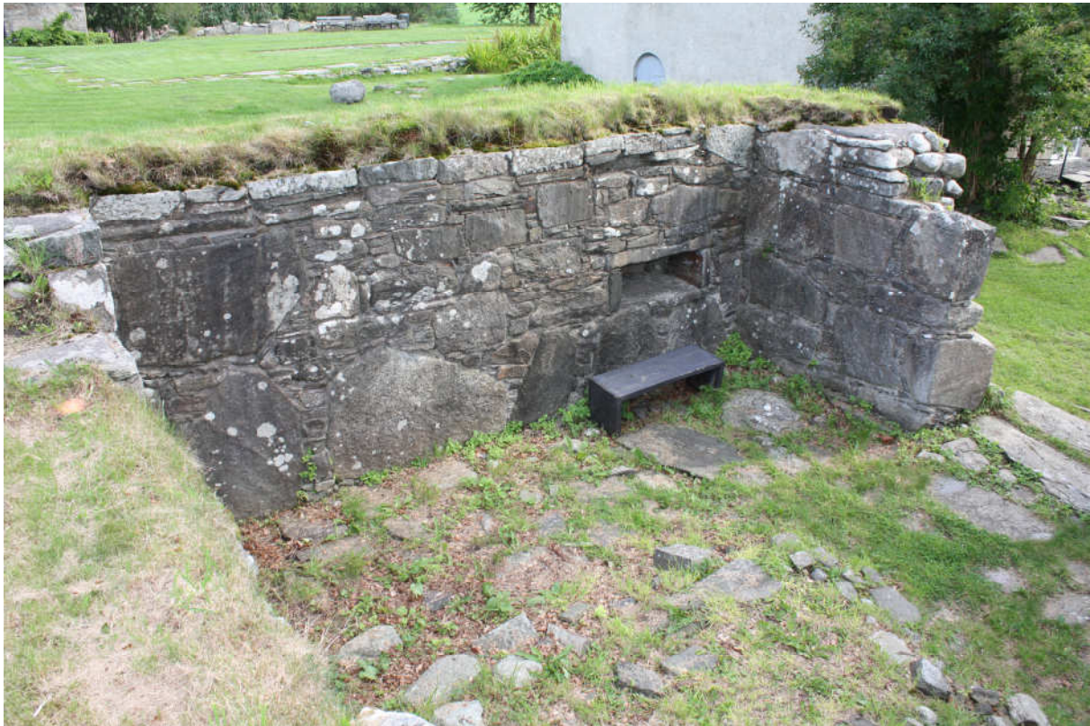
Fig.25 Nordmurens indre murliv med nisje i veggen samt nordre dørvange lengst til venstre. Foto tatt mot nordøst av Foto RM, 19-20.08.09.
