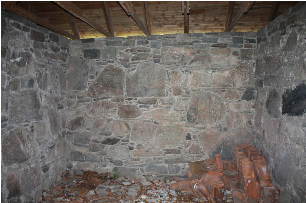
Fig.8 Nordmuren i N3, det indre murlivet. Foto RM, 19-20.08.09.
