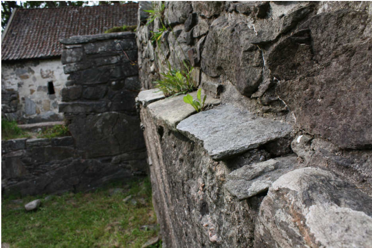
Fig. 23 Fotoet viser de små hellesteinen som ble lagt som avdekning for den store steinene i nordmurens indre murliv. Steinene har ikke overlapping og det vokser ugress i de oppsprukne skjøtene. Man kan også ane de omtalte vertikalsprekkene. Foto tatt mot vest av RM, 19-20.08.09.
