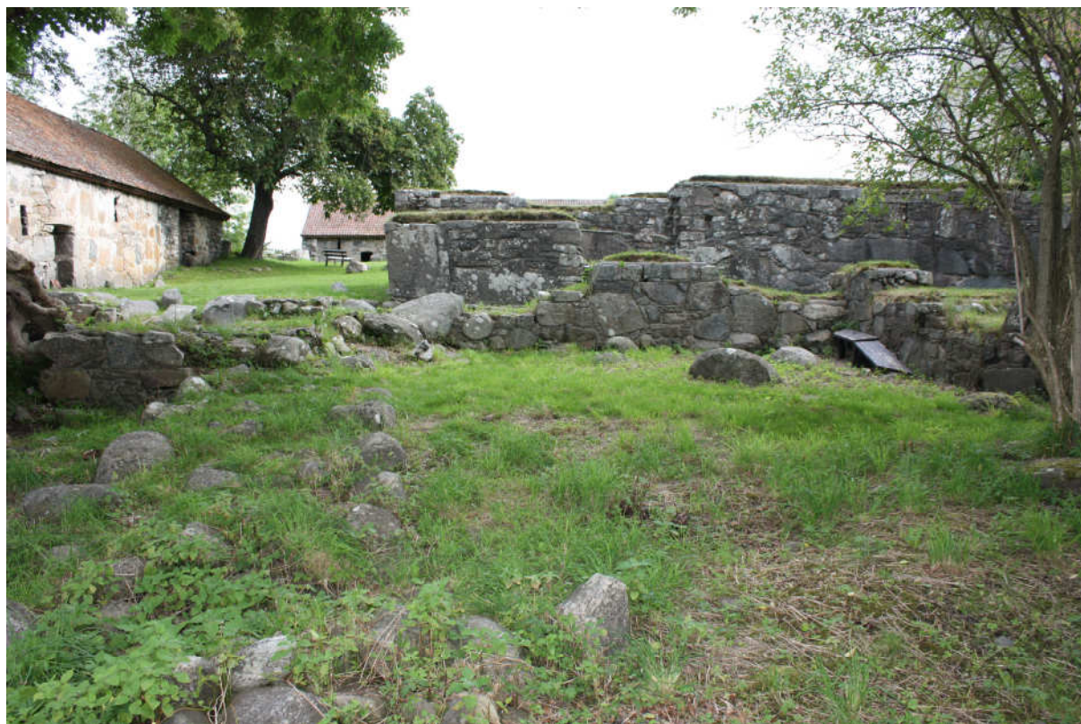
Fig.31 Fotoet viser tørrmuren (til venstre) som går fra S1/S2 og sørover. I bakgrunnen sees S1. Foto tatt mot nord av RM, 19-20.08.09.
