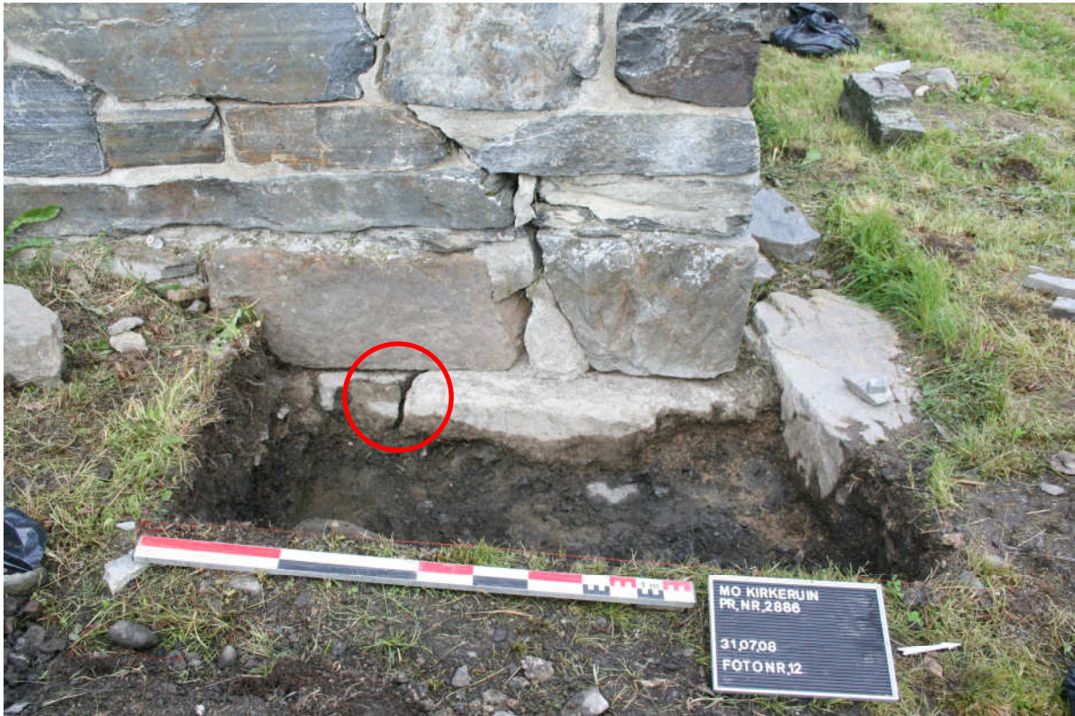
Den støpte sementsålen som ble gravd frem under østmurens nordøstre hjørne. Det går en sprekk mellom sålen og steinen som den er støpt inntil (merket med rød sirkel) Foto: NIKU, tatt mot vest.
