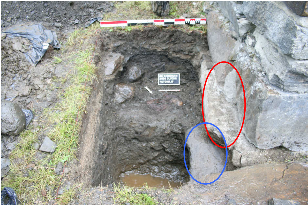
Fotoet viser hvordan sementsålen (rød sirkel) er støpt på hjørnet til en gammel fundamentstein (blå sirkel) med stor helling nedover. Foto: NIKU, tatt mot sør.
