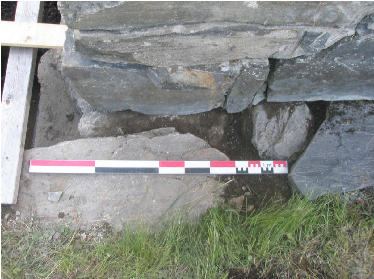
Nordvangen ved korets nordøstre hjørne. En opprensning langs med muren kan tyde på at sementsokkelen fortsetter ca. 0,60 m i retning vest. Foto: Regin Meyer, tatt mot syd, 01.08.08.
