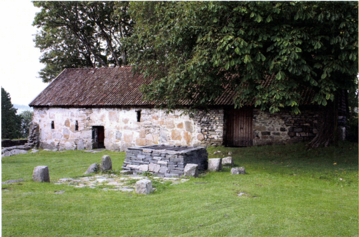
Fig.31 Brønnen og deler av rom V3 i vestfløyen består av skiferstein i tørrmur. Foto tatt 20.08.09 av RM mot sørvest. Samme type tørrmur foreslås med tanke på å formidle nord- og sørmuren i portrommet.
