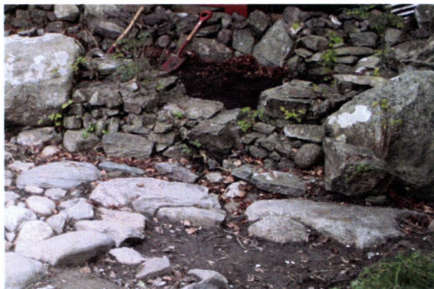
Fig.20 Det omtalte partiet som er rekonstruert med sement.
