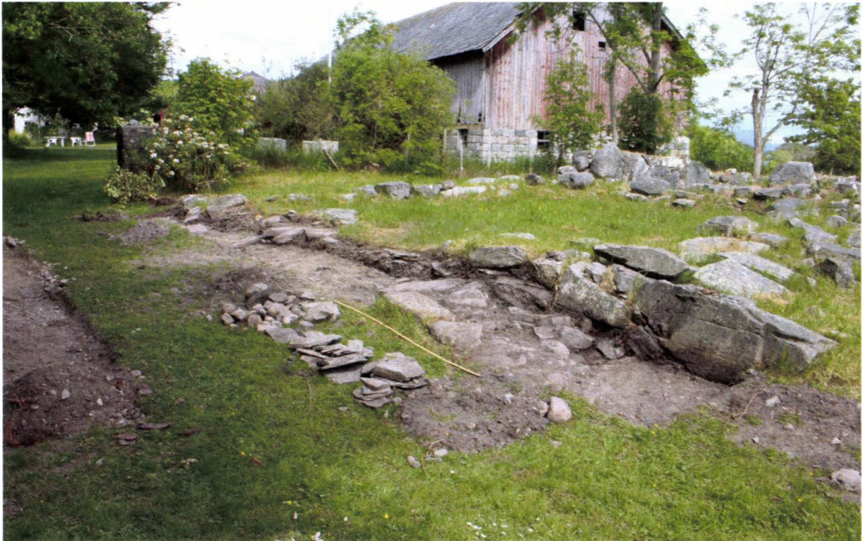
Fig.6 Etter avtorving i overgangen mellom rom V2 og portrommet ble det funnet en hel del løs stein og en steinansamling i forlengelse av østveggen i V2.
