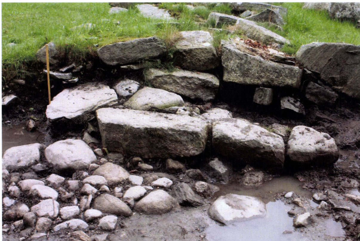
Fig.24 Foto vinkelrett på østmuren med fundamentfyllingen under. De tre steinene som er i midten av fotoet inngår ikke i den opprinnelige muren og er en senere tilføyelse.
