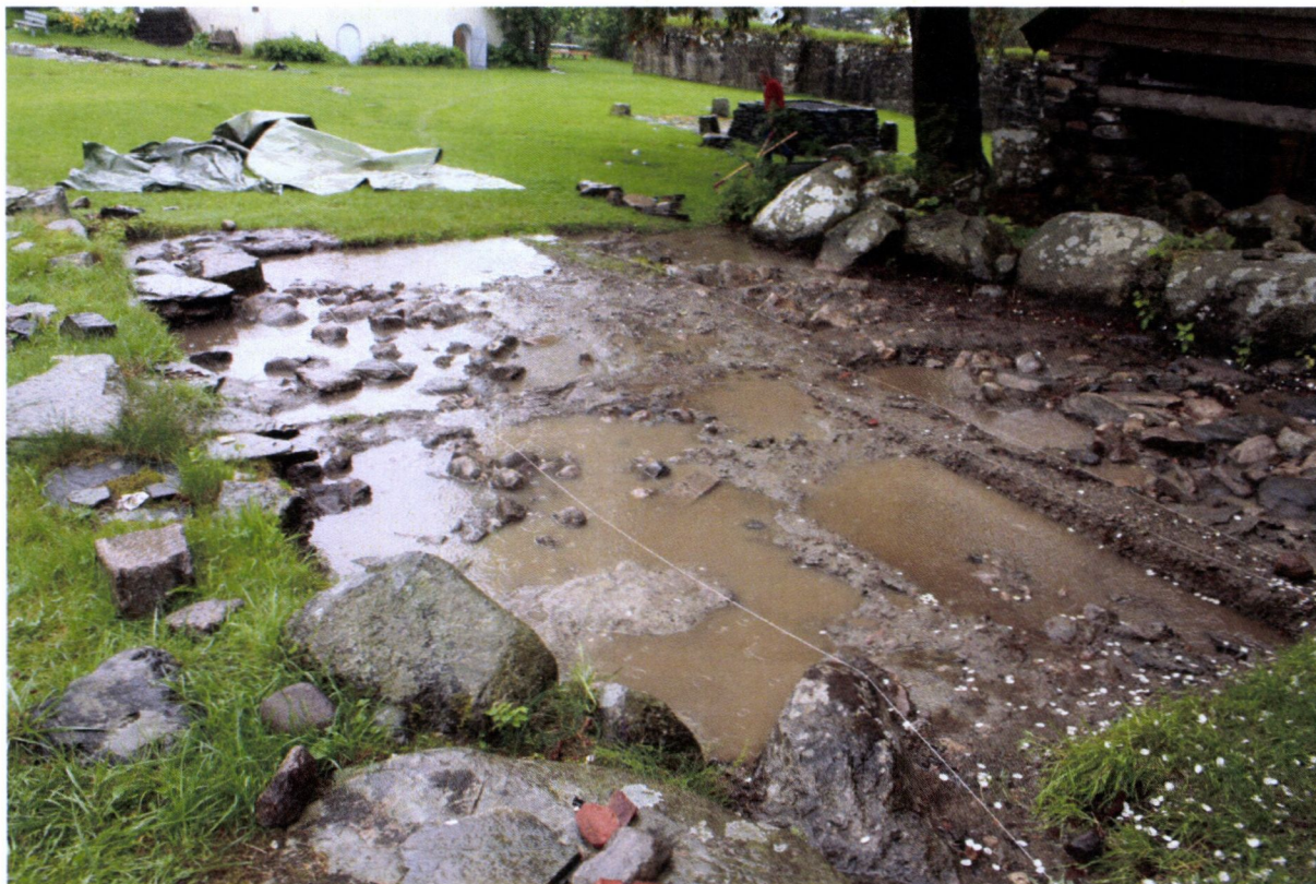
Fig.34 Foto fra feltarbeid en regnfyllt dag. Vannet samles opp særlig i nordre del av feltet hvor det er mye leire i grunnen, for å så renne mot øst hvor det oppstår pytter ved utgravingskanten. I søndre del av feltet (øverst til høyre) forsvinner vannet i jord og siltmasser. Profilbenkene står riktig nok igjen, men fotoet viser hovedtendensen. Foto tatt mot sørøst 20.07.11 av RM.
