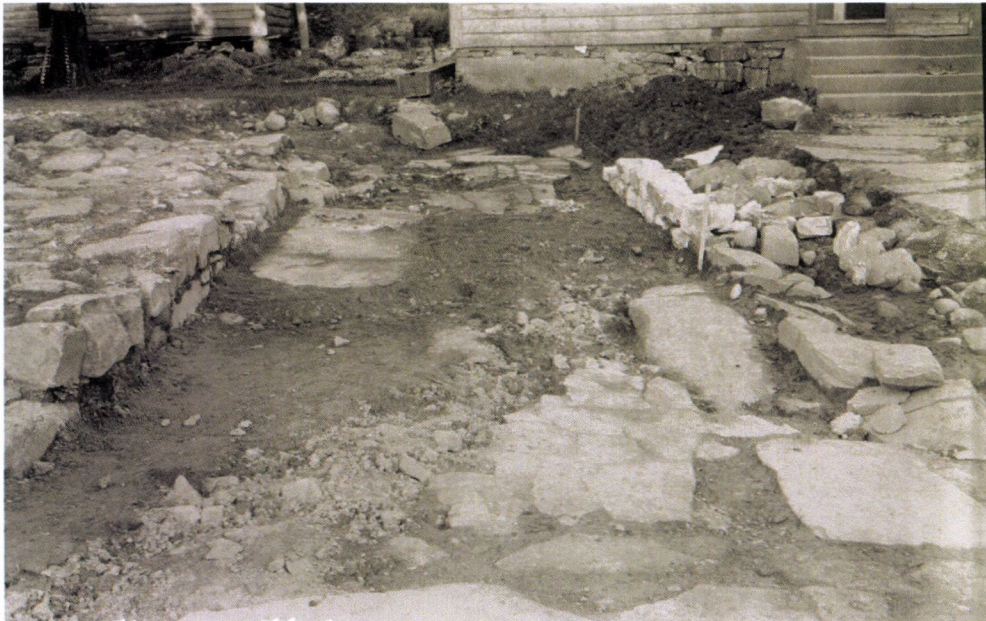
Fig.11 Fischer foto 114 (17-18 juli 1939): «N.v. hjørneparti i korsgangen – de i dag fremgravde fundamenter av østmuren i vestre korsgang osv.: fra vest, tatt 1,40 m syd for ytterflukten av kirkens sydmur og 60cm vest for vestflukt av vestre korsgangs vestmur.»
