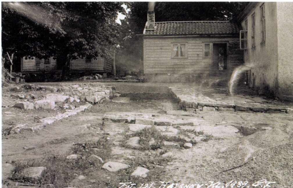
Fig.12 Fischer foto 121 (17-18 juli 1939): «(Enger fot. 25.08.1939...) Markering av korsgangsmuren osv. ved n.v.hj. (smlg. Fot .94)
