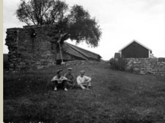
Ruinen før bygningene tett ved ble revet.
