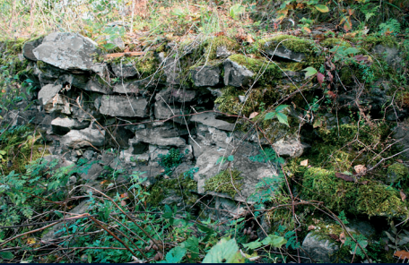
Bare rester av murverket er synlige.
