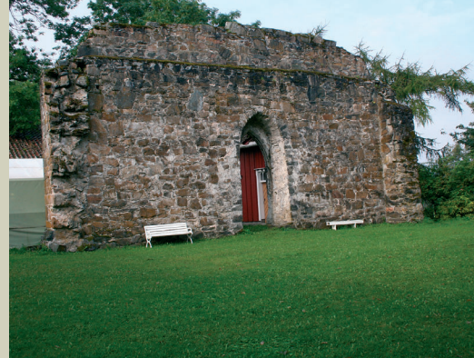
Vestveggen sett mot nordvest.
