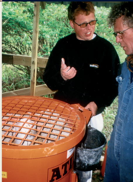
Lesking av kalk. Foto: Riksantikvaren
