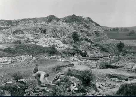
Restaureringsarbeider rundt århundreskiftet.
