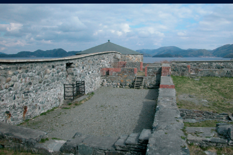
Under bakken ligger 4 hvelv. Nordre ringmur sees til venstre.
