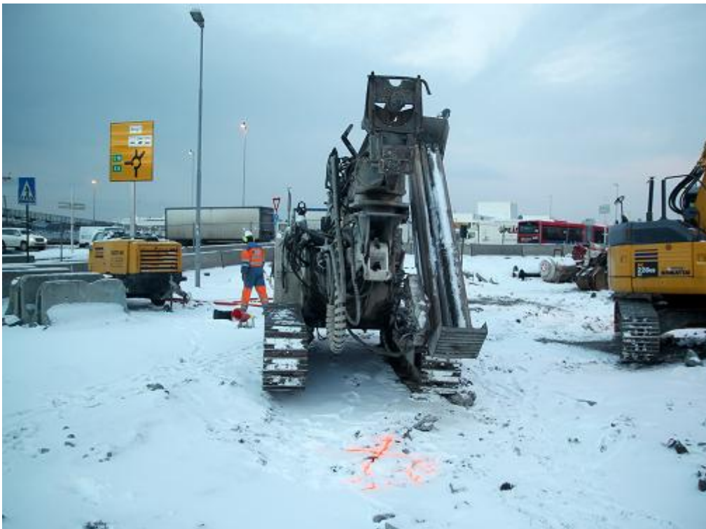
Figur 4: Borerigg i vintervær klar for boring av pelehull 42-15 sørøst i feltet. NIKU_ARK_NR_ 309431. Foto: NIKU 20.12.2010.
