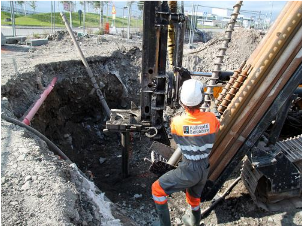
Figur 2: Skovelbor monteres for boring av miljøbrønn 7. NIKU_ARK_NR_ 309531. Foto: NIKU 08.09.2010.
