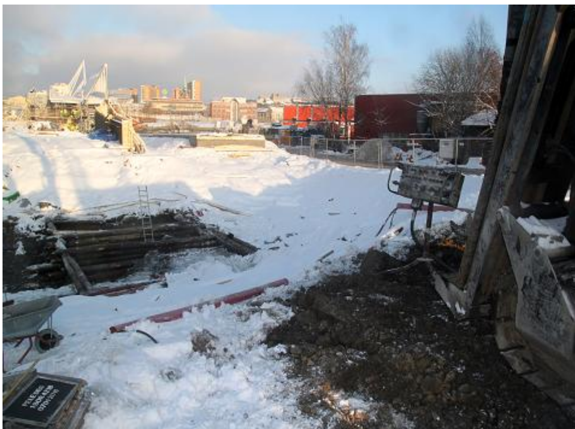
Figur 16: Pelehull 42-18 bores i kanten til bryggekonstruksjon i hovedgrøft 2. Sannsynligvis fortsetter trestrukturene videre sørøst i et område der det er utført borer for miljøbrønner og pelehull (SØ-del av feltet). Se også figur 17 under. NIKU_ARK_NR_309563. Foto: NIKU 07.01.2011.
