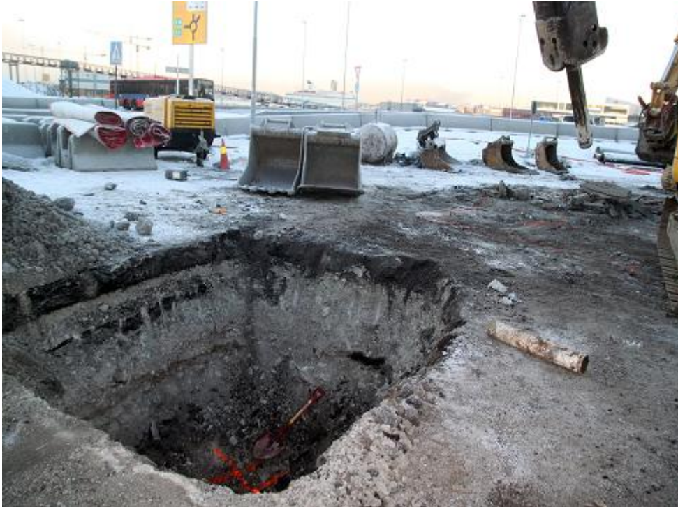
Figur 9: Graving kabelpåvisning gjennom moderne fyllmasser, bla. asfaltlag i eldre veianlegg. NIKU_ARK_NR_309419. Foto: NIKU 15.12.2010.
