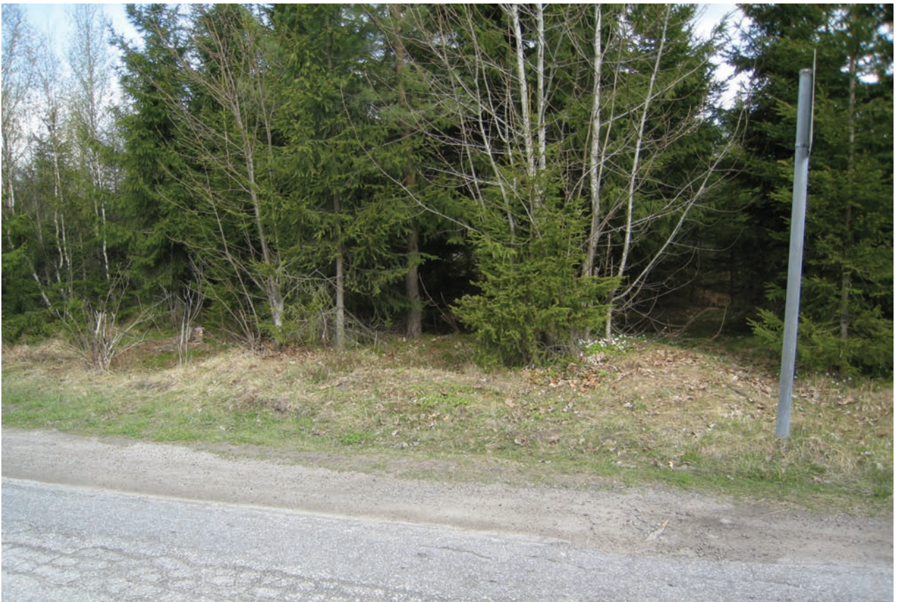
Figur 21. Gravhaugen id 71227-3 er tidligere skadet av veien til Solum kirke og veiskulderen går langt inn i haugen. Det er dype kjørespor utenfor veien og i haugen. Brukes som parkeringssted? Foto: Jan Brendalsmo NIKU 2010.
