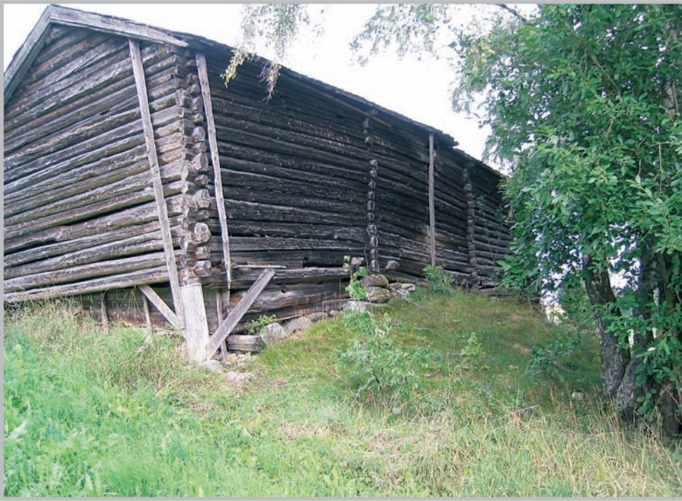
Figur 8. Gravhaug som det er bygd en laftet lœ på. Id-nr: 43079-1. Foto: Jan Brendalsmo, NIKU 2006.
