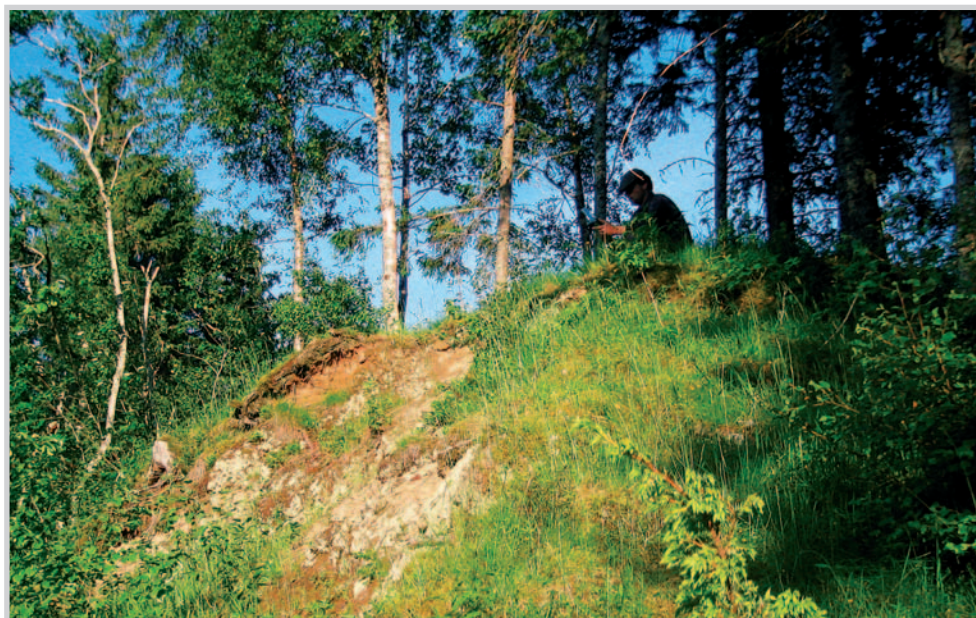
Figur 3b. Id 60022. Gravhaugen er skadet i forbindelse med vegbygging. Den er svært utsatt for erodering på grunn av beliggenheten. Foto: May-Liss Bøe Sollund, NIKU 2005.
