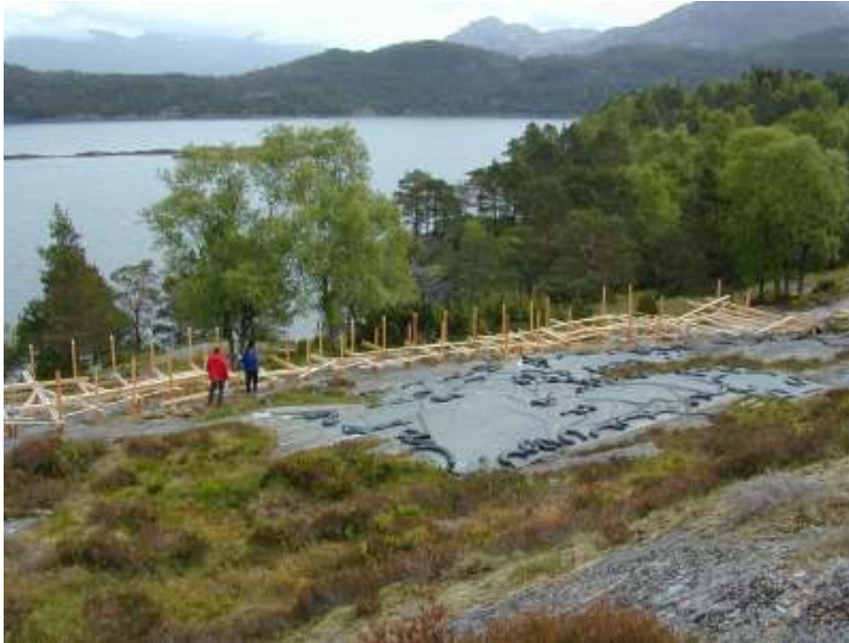
Plattformen på Ausevik under bygging i 2006. I anleggsfasen er helleristningsfeltet tildekket. Foto: Valborg Leivestad.
