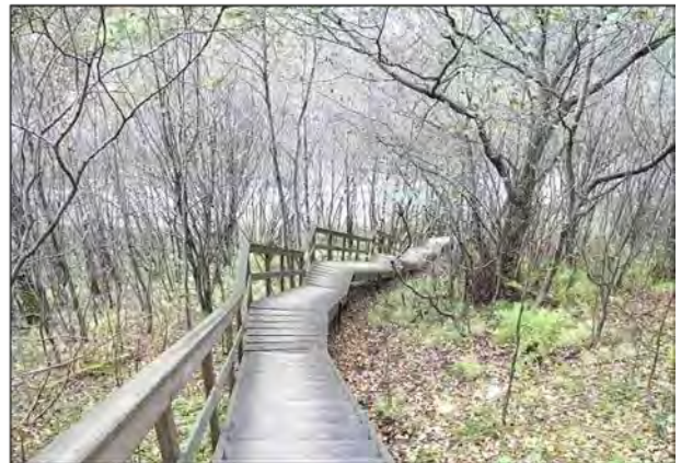
Fig. 6. Trapp sett ovanfrå.
