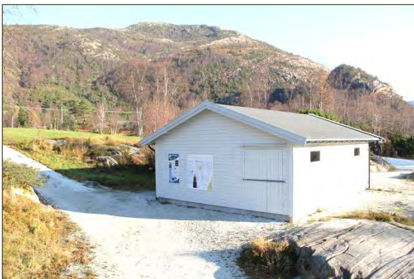
Fig. 51. Servicebygg med informasjonsskilt.
