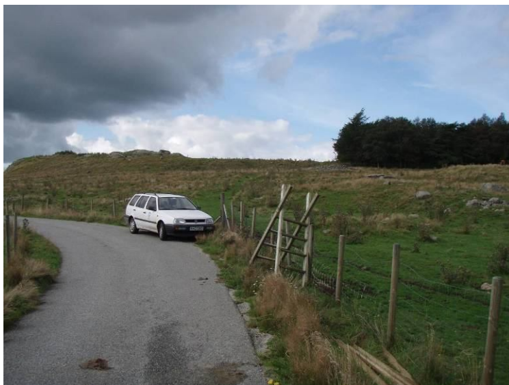
Lite P-mulighet. Gjerdeklyver må repareres/på plass
