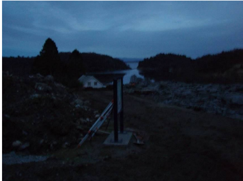
Byggeaktivitet ved oversiktsskilt i 2009
