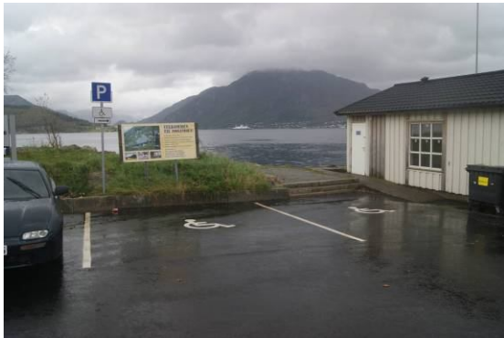
Dobygg med rampe.
