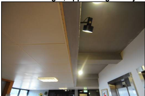
Himlinger og langsgående dragere i sengefloy. Skrudd himlingsplater, dels malt.
