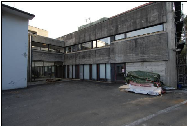
Fasade mot nord, vestfløyen
