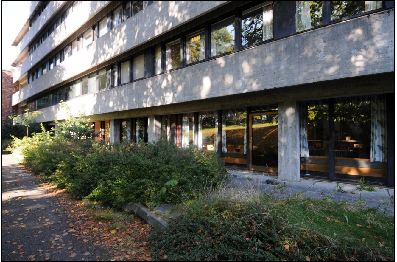
Fasade mot sør, østfløyen sett fra sørøst
