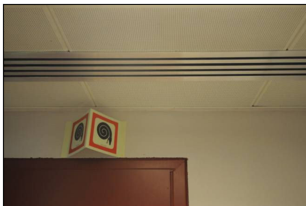
Detalj himling med ventilasjonsrist
