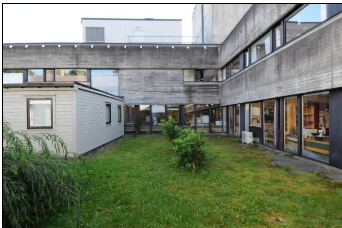
Fasade mot nord og lavblokkens vestfasade
