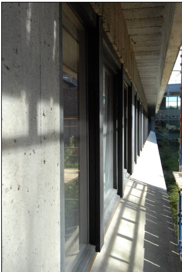
Utførelse sørfasade, lettklinkerstein over vindu
