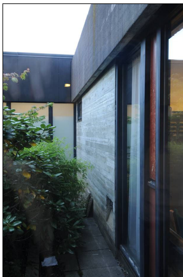
Vindu i atriets med eksempel på opprinnelige beisete rødbrune lufteluker
