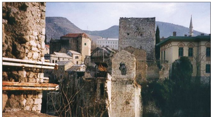
Den sprenge broen i Mostar etter 1993. Foto: Jon Roar Strandenes
