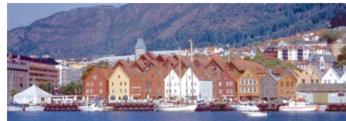
Fig. 16. SAS-hotellet på Bryggen i Bergen er nybygg plassert inn i ein eldre bygnadsstruktur. Hotellet er høgare en dei eldre bygningane, men følgjer volumorganiseringa i den eldre bygnadsstrukturen.
