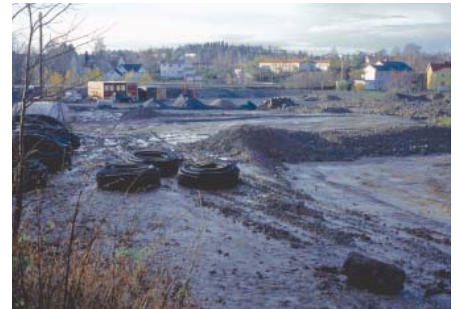
Fig. 29. Etablering av golfbane krev inngrep i grunnen. Bærum, Akershus
