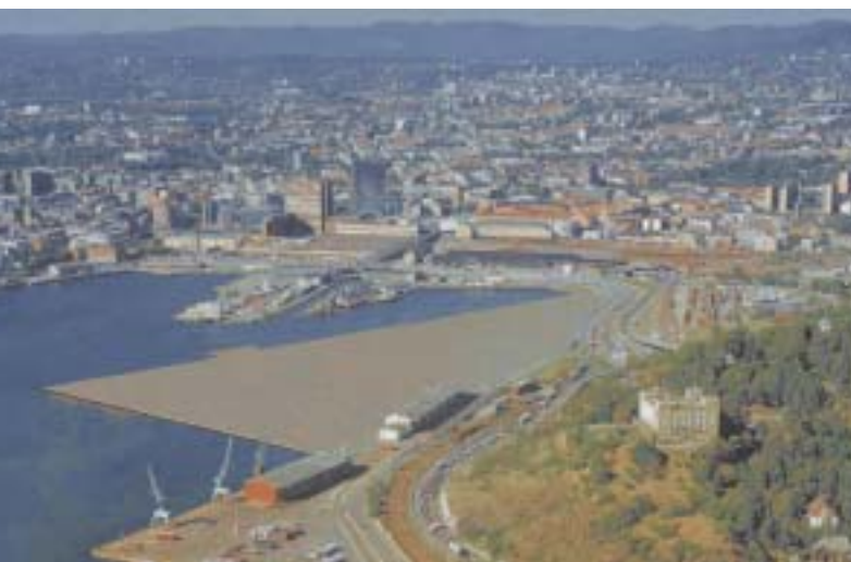
Fig. 17. Konsekvensutgreiing for utbygging av Lohavn, Oslo. Fotomontasje viser full utfylling med og utan aktivitet på kaia, eit aspekt som har mykje å seie for oppleving av tiltaket.
