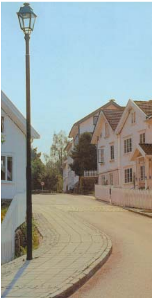
Fig. 31. Innfartsveg til Tvedestrand frå sør går gjennom eit verdifullt trehusmiljø. Dette partiet var for trangt til å romme to køyrefelt og fortau. Ved å innsnevre riksvegen til eitt felt, har ein unngått riving.
