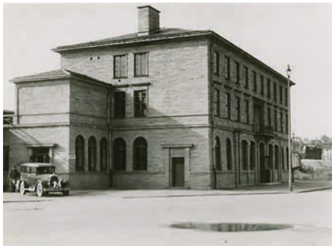
I kjølvannet av den industrielle revolusjon ble det fra 1854 bygd jernbaner mange steder i Norge og vi får et nytt urbant tilfang, nemlig stasjonsbyene. Disse ble anlagt som satellitter langs jernbanelinjene. Lillestrøm er et typisk eksempel på en stasjonsby. Bildet fra Lillestrøm jernbanestasjon er tatt mellom 1930 og 1940. Foto: Mittet/NB.
