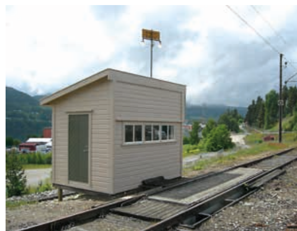
Gjenåpnet stasjon, juni 2012. Foto: Alexander Ytteborg © Riksantikvaren
