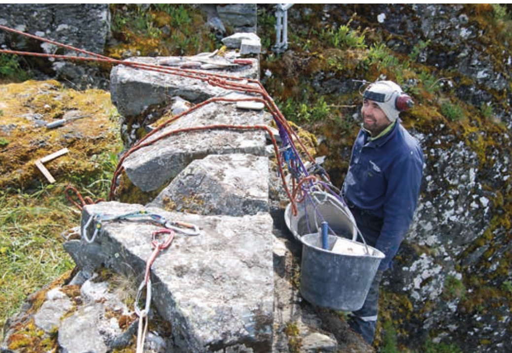
Murar i arbeid på Sverresborg i Trondheim: Borga til kong Sverre Sigurdsson (ca. 1153 til 1202) blei bygd 1182. I år, etter seks års arbeid, er borga ferdig konservert. Foto: Geir Magnussen
